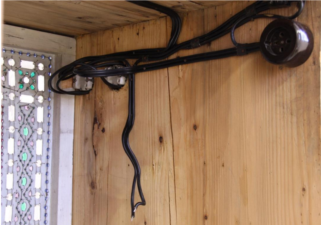
Obr. 171: Detail elektrického vedení a dřeva po restaurování
