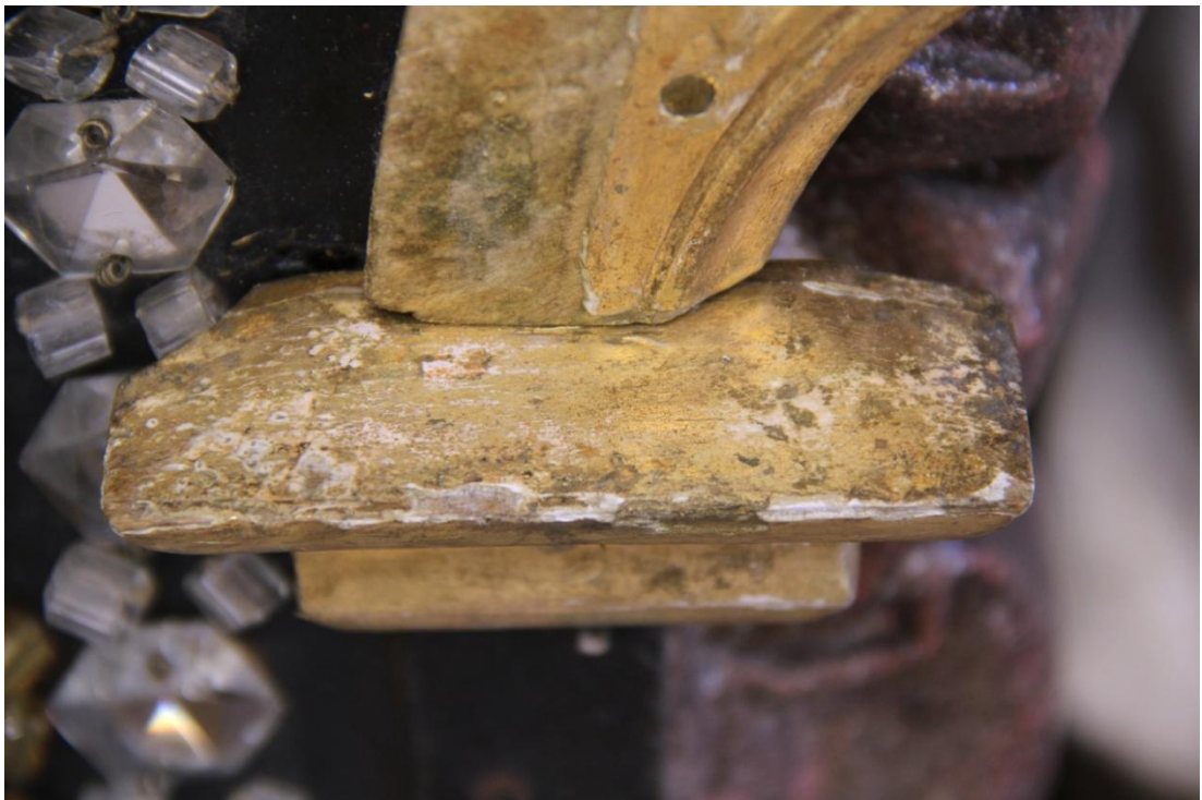
Obr. 132: Detail hlavice levého sloupku po sejmutí bronzového nátěru
