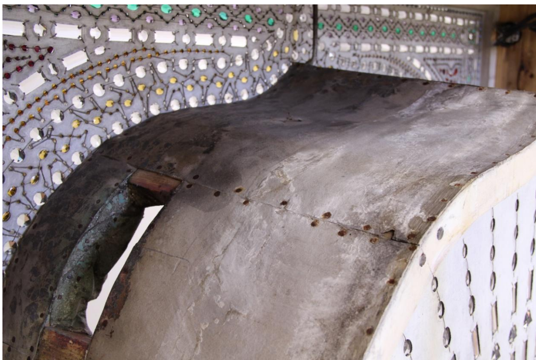
Obr. 85: Detail lepenek na korpusu hrobu ve vnitřním prostoru dřevěné konstrukce po čištění suchou cestou, po konsolidaci křídové vrstvy, korozních produktů alobalu a po ošetření hřebíků
