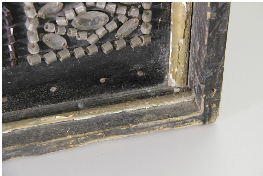
Obr. 140: Detail půlkulaté lišty vpravo před restaurováním, poškození a ztráta křídové vrstvy
