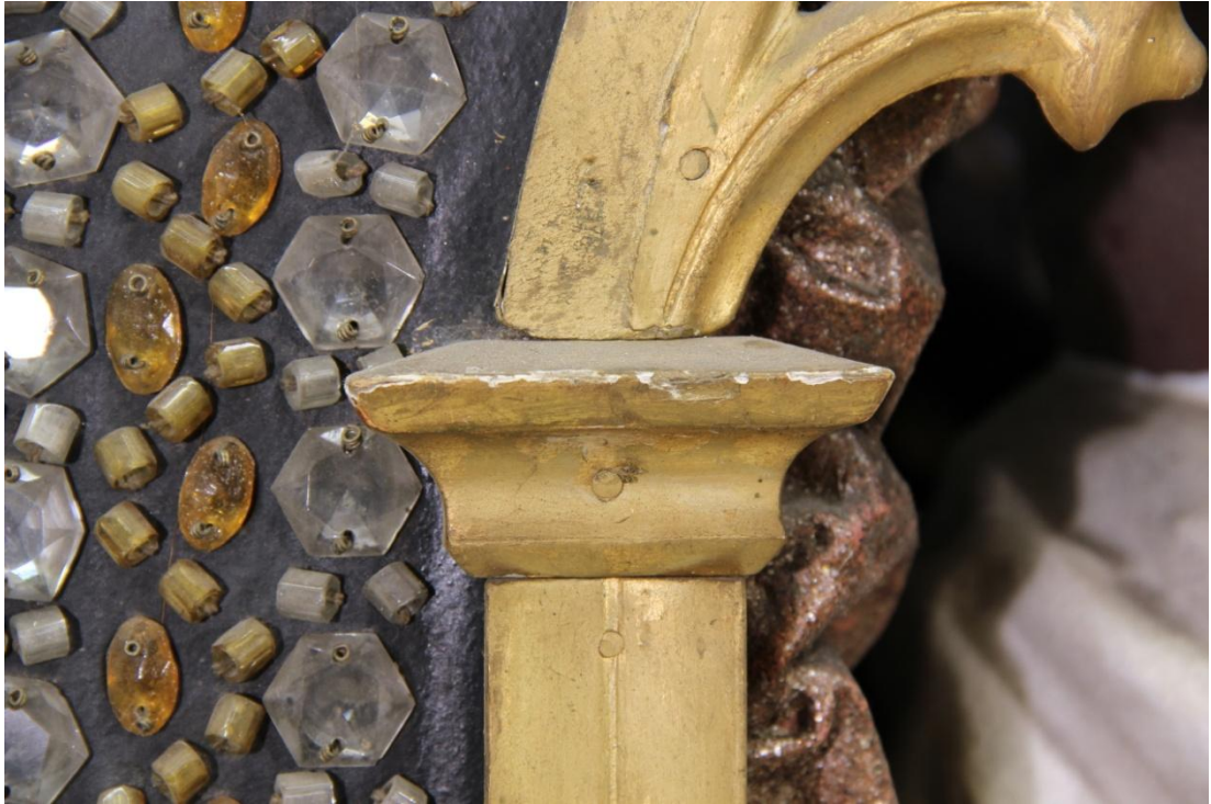
Obr. 129: Detail hlavice levého sloupku před restaurováním, poškození prachovým depozitem a ztráty křídové vrstvy
