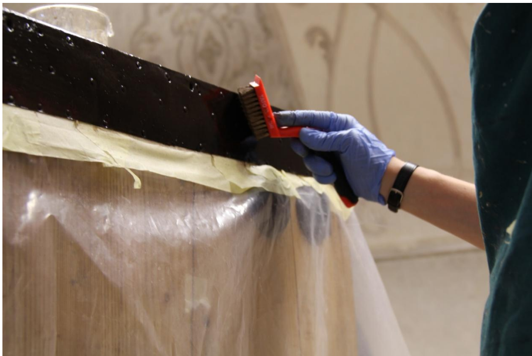
Obr. 199: Detail aplikace taninového roztoku na povrch kovu
