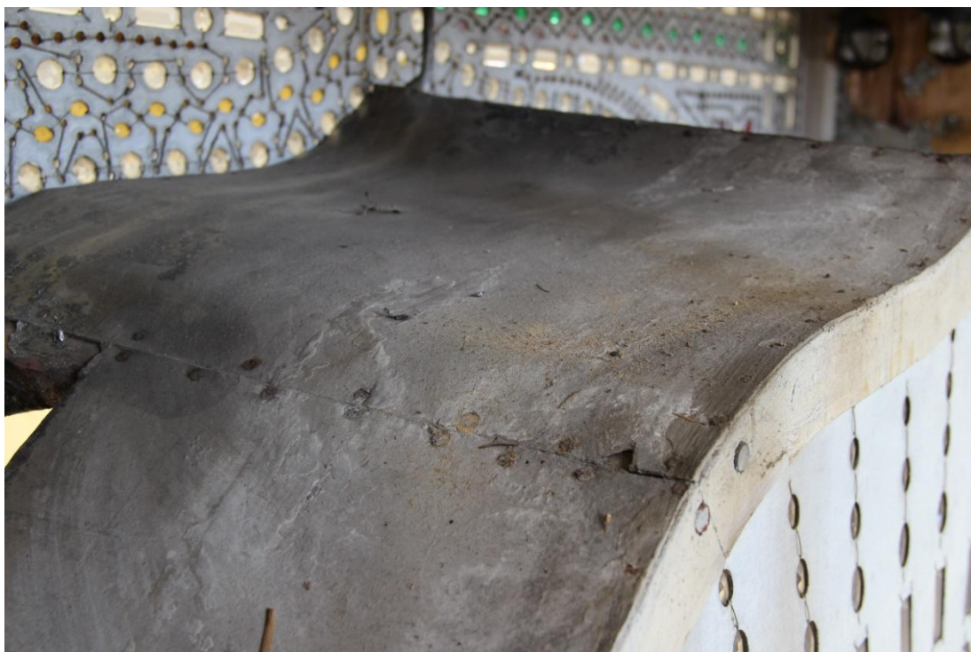
Obr. 84: Detail lepenek na korpusu hrobu ve vnitřním prostoru dřevěné konstrukce před restaurováním, prachový depozit
