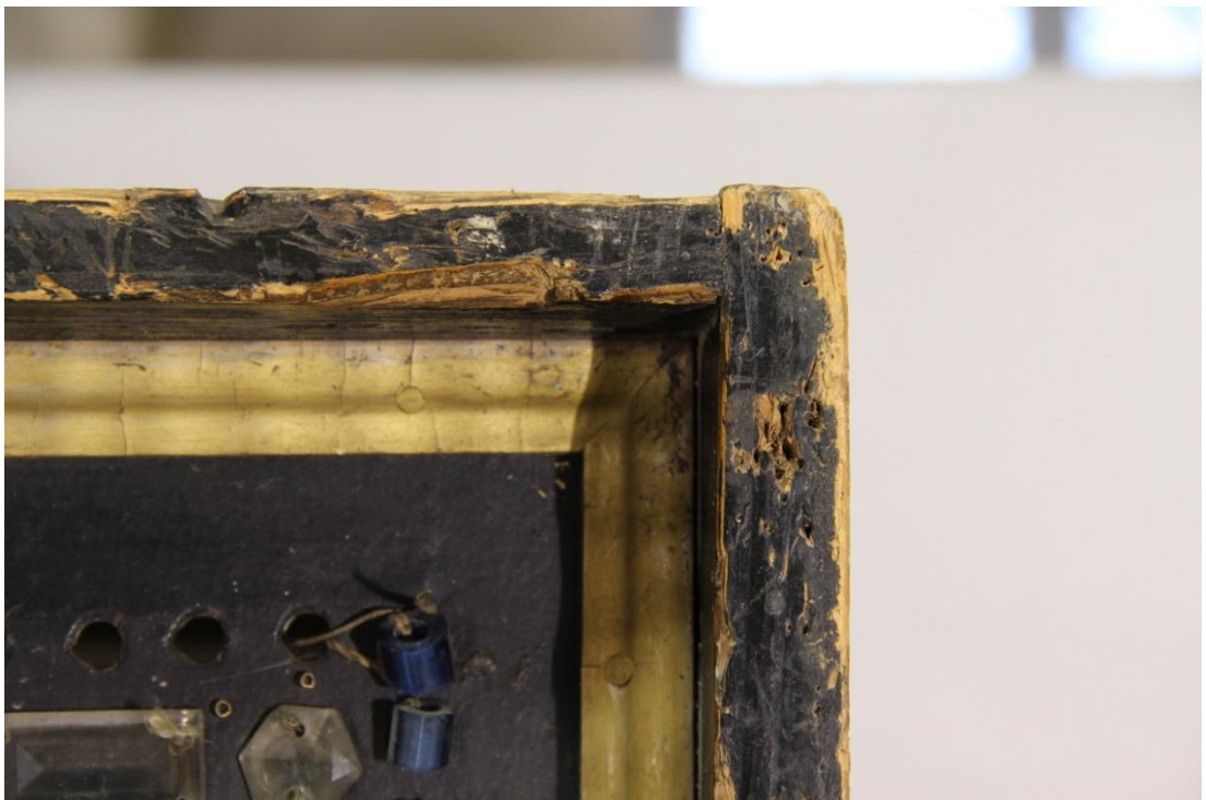
Obr. 180: Detail pravého horního rohu před restaurováním, perforace po hřebících, chybějící dřevěná hmota
