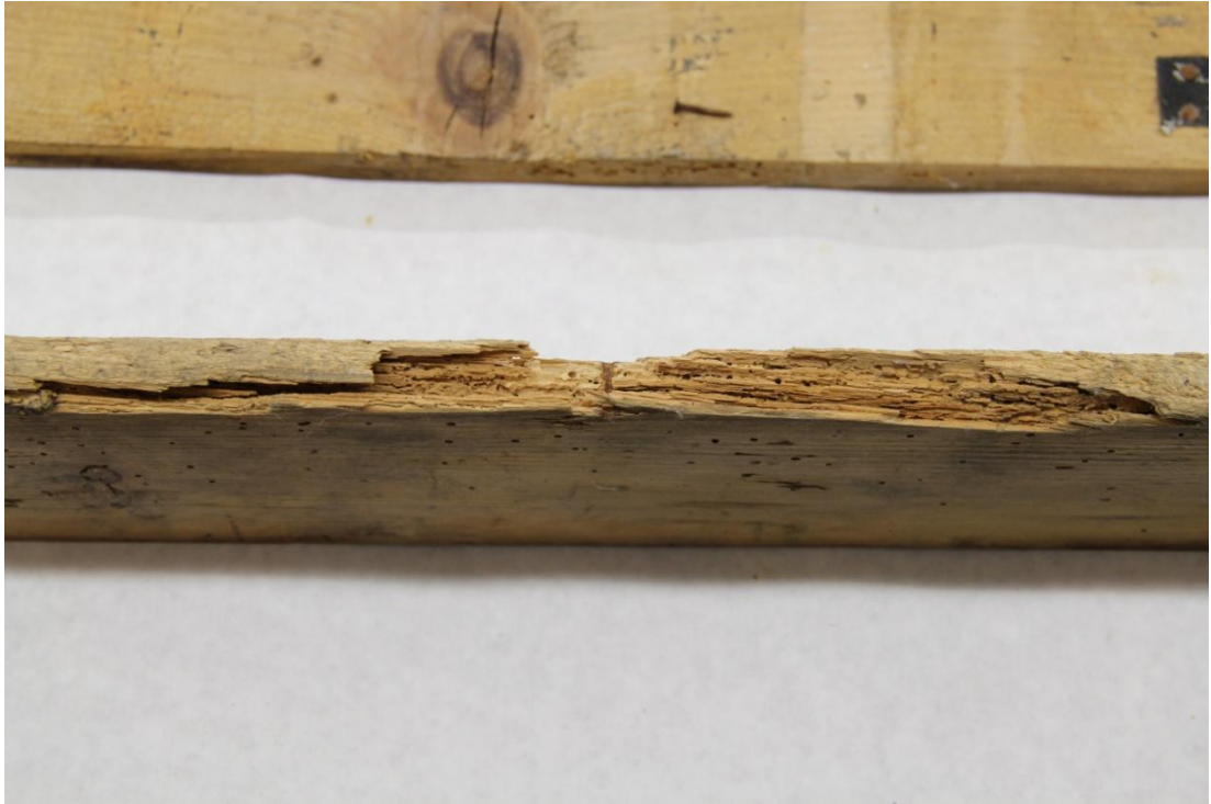
Obr. 175: Detail poškození dřeva dřevokazným hmyzem
