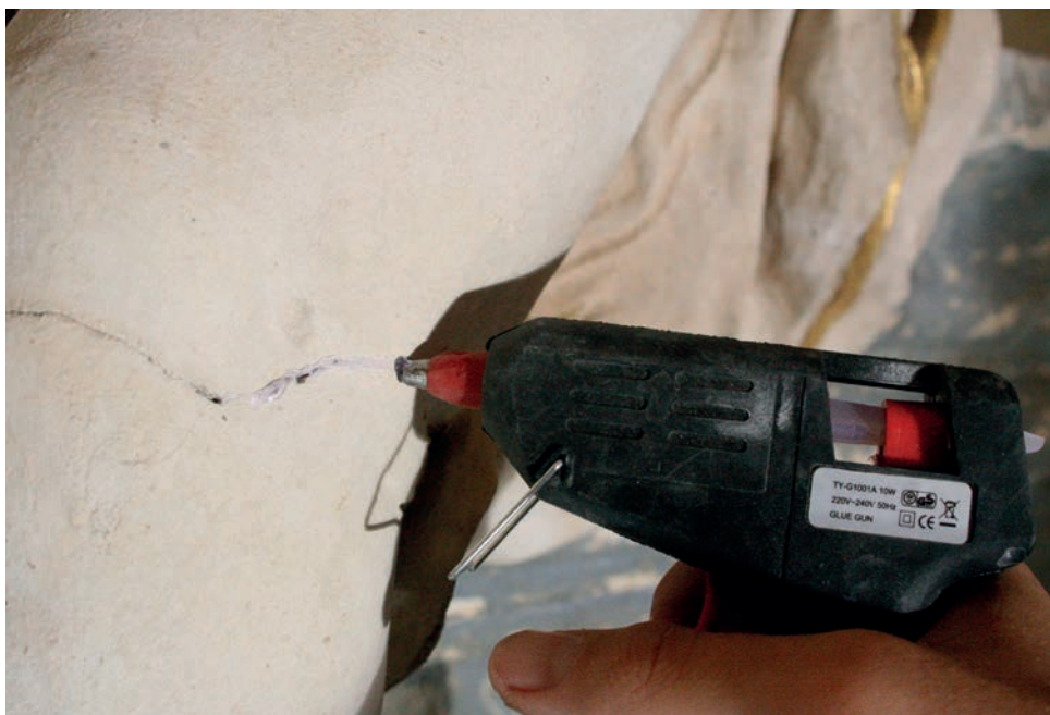
obr. 142 Příprava před injeztáží
