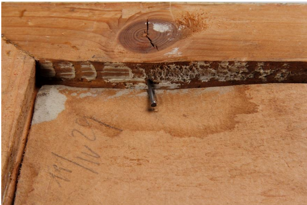
Obr. 3. 4 Stav před restaurováním, detail, zadní strana
