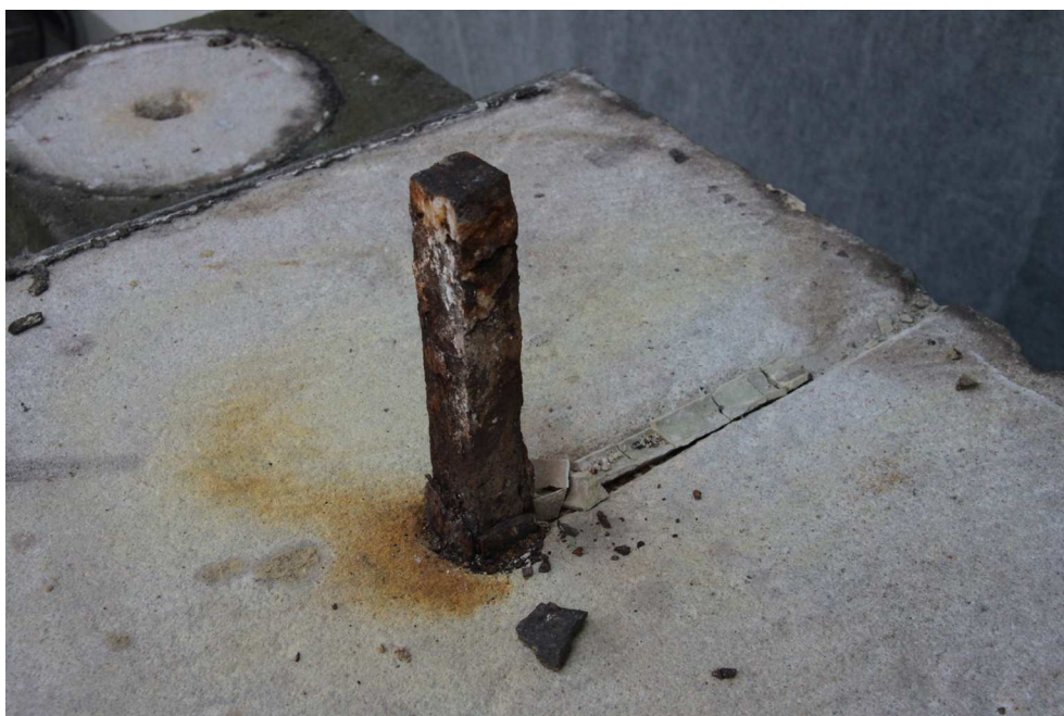
Obr. 76 Stav před restaurováním, zkorodovaný čep a síra
