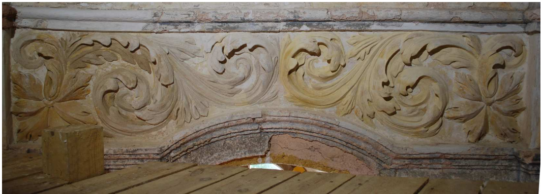
Obr. 44 Povrchová podkladová úprava rozvilin, celkový pohled
