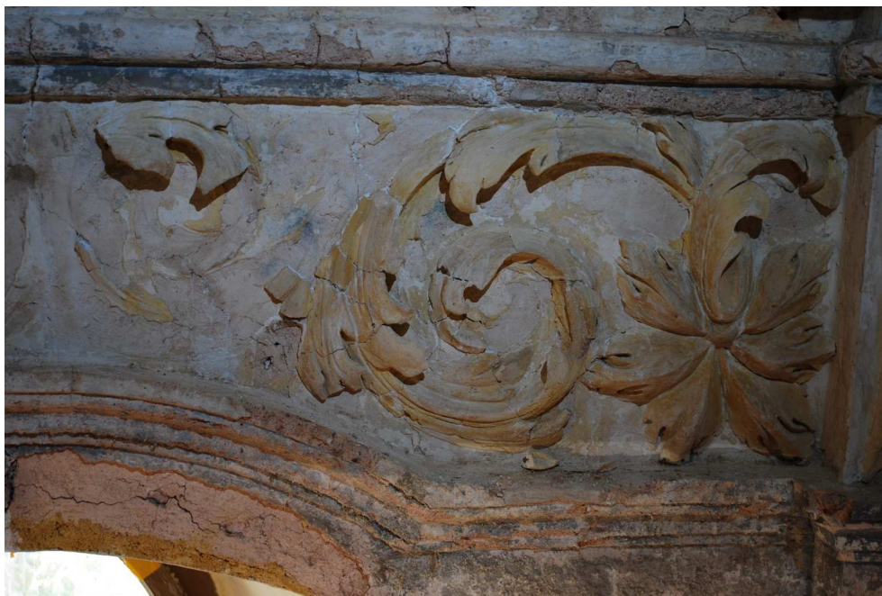
Obr. 38 Stav po čištění a injektování, detail
