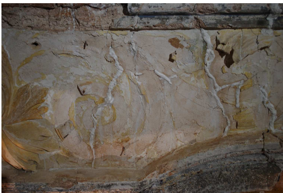
Obr. 37 Stav po čištění, injektování prasklin
