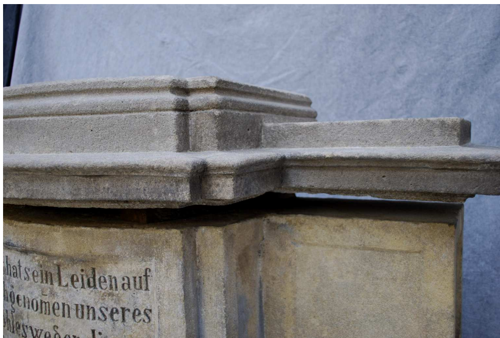
Obr. 93 Stav po restaurování, detail
