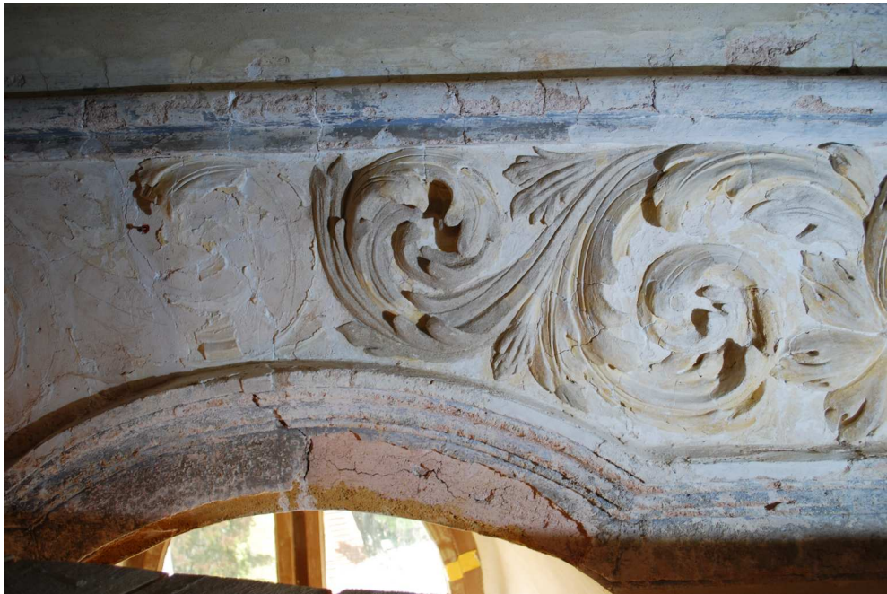
Obr. 41 Průběh rekonstrukce rostlinného ornamentu, detail
