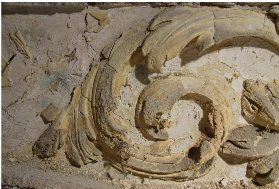
Obr. 34 Stav před restaurováním, detail poškození, krusty a prachové depozity
