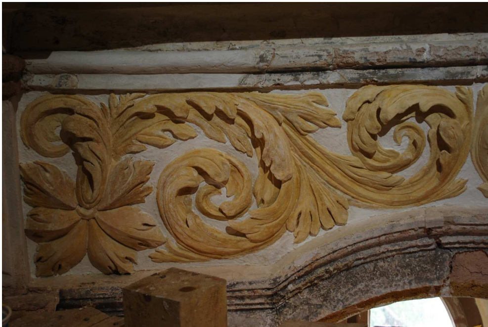
Obr. 47 Stav po restaurování štukového vlysu, detail
