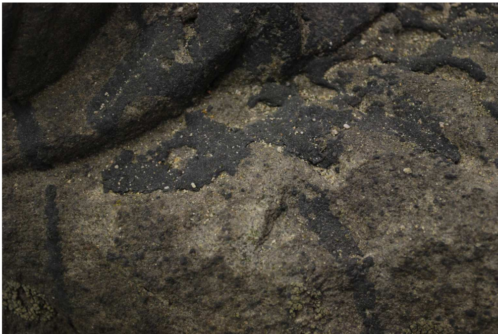
Obr. 84 Detail skály kříže, znečištění povrchu - asfalt
