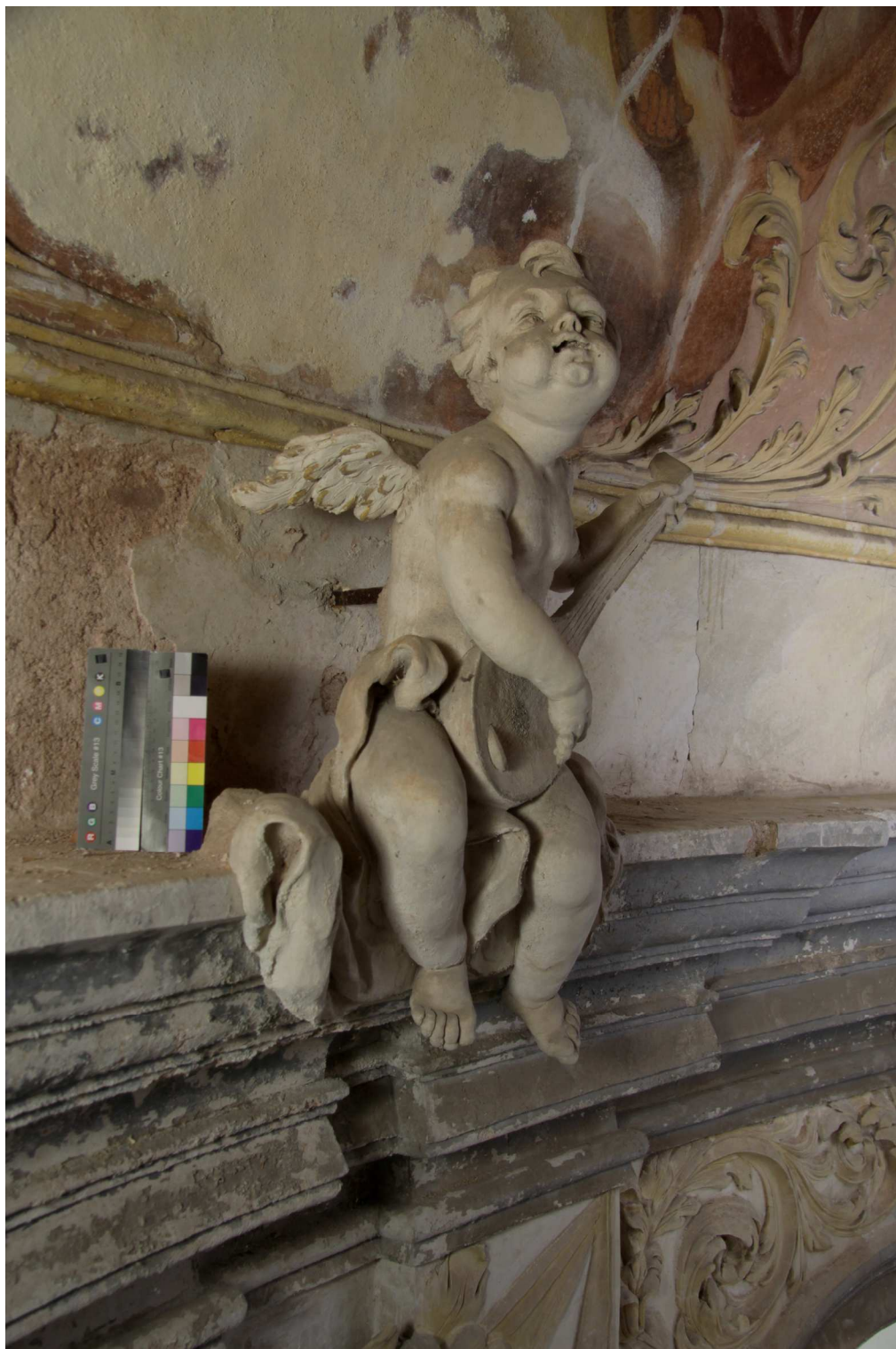
Obr. 9 Stav před restaurováním, pohled zprava
