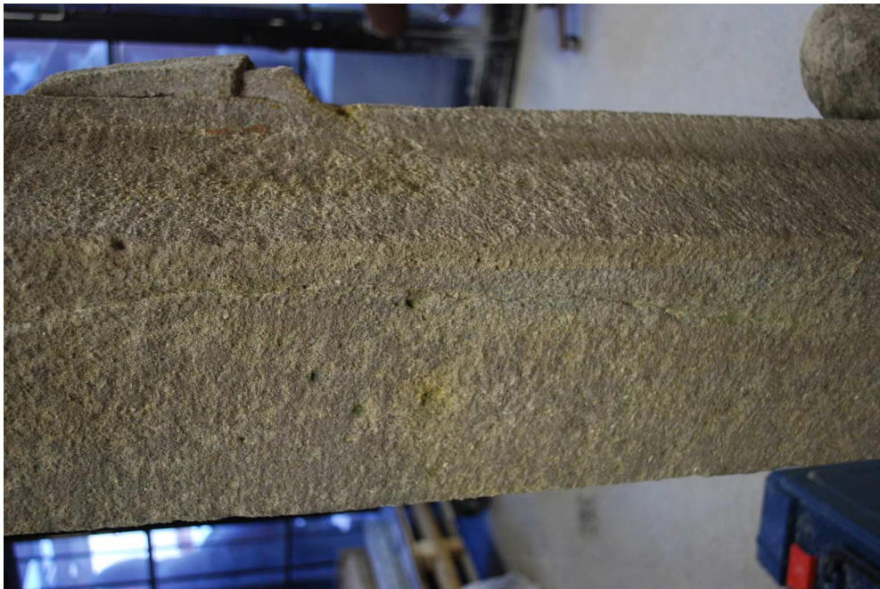
Obr. 80 Detail poškození, mikroprasklina
