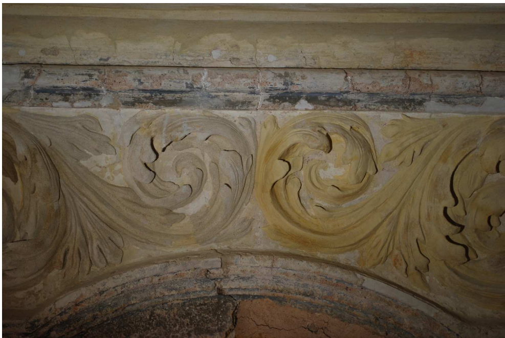
Obr. 45 Povrchová podkladová úprava rozvilin, detail
