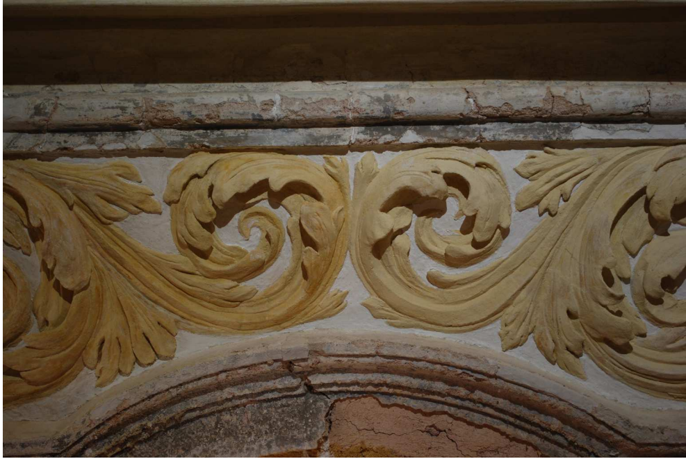
Obr. 46 Průběh retuše nových doplňků, detail
