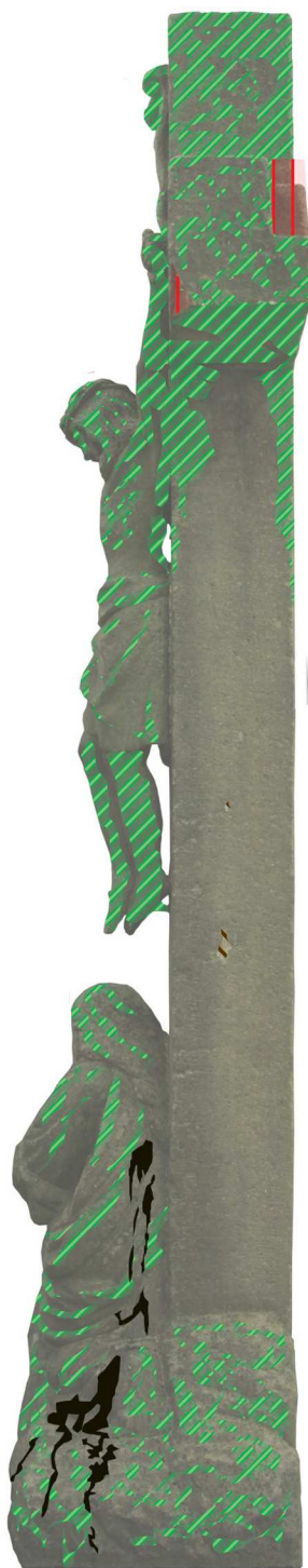
Obr. 62 zákresy poškození kříže, pohled zleva
