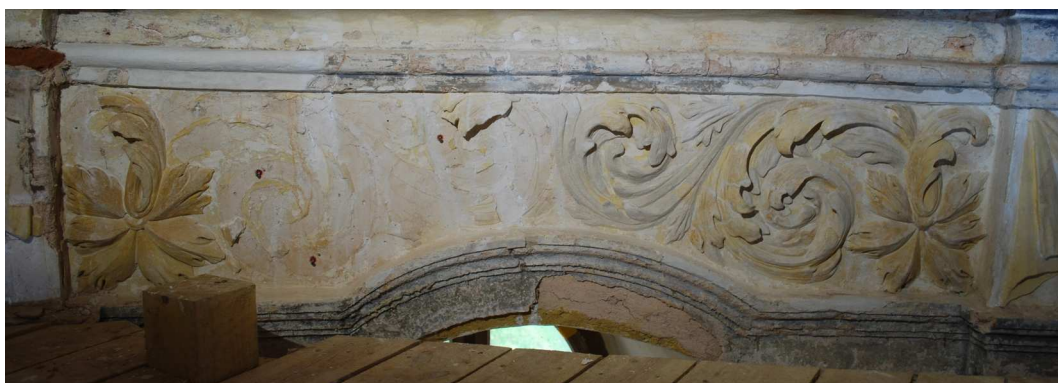
Obr. 40 Průběh rekonstrukce, celkový pohled
