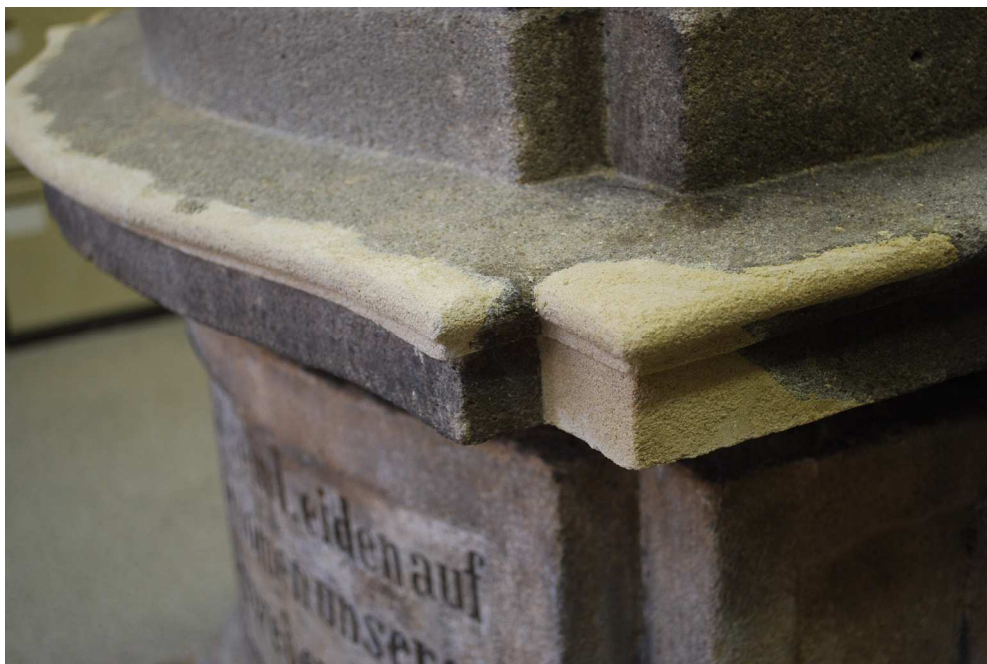
Obr. 88 Doplnování architektonických částí
