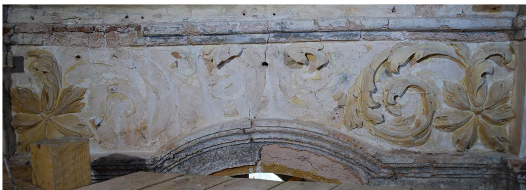
Obr. 39 Stav po čištění a injektování, celkový pohled
