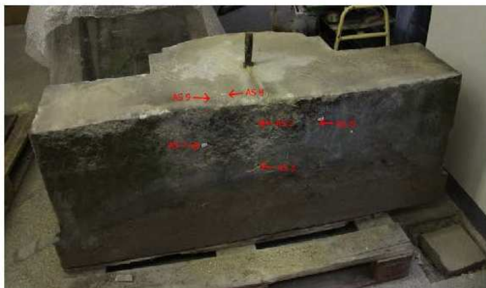
Obr. 1 Odběr vzorků na určení vodorozpustných solí spodního dílu A, celkový pohled, AS1, AS2, AS6-9.
