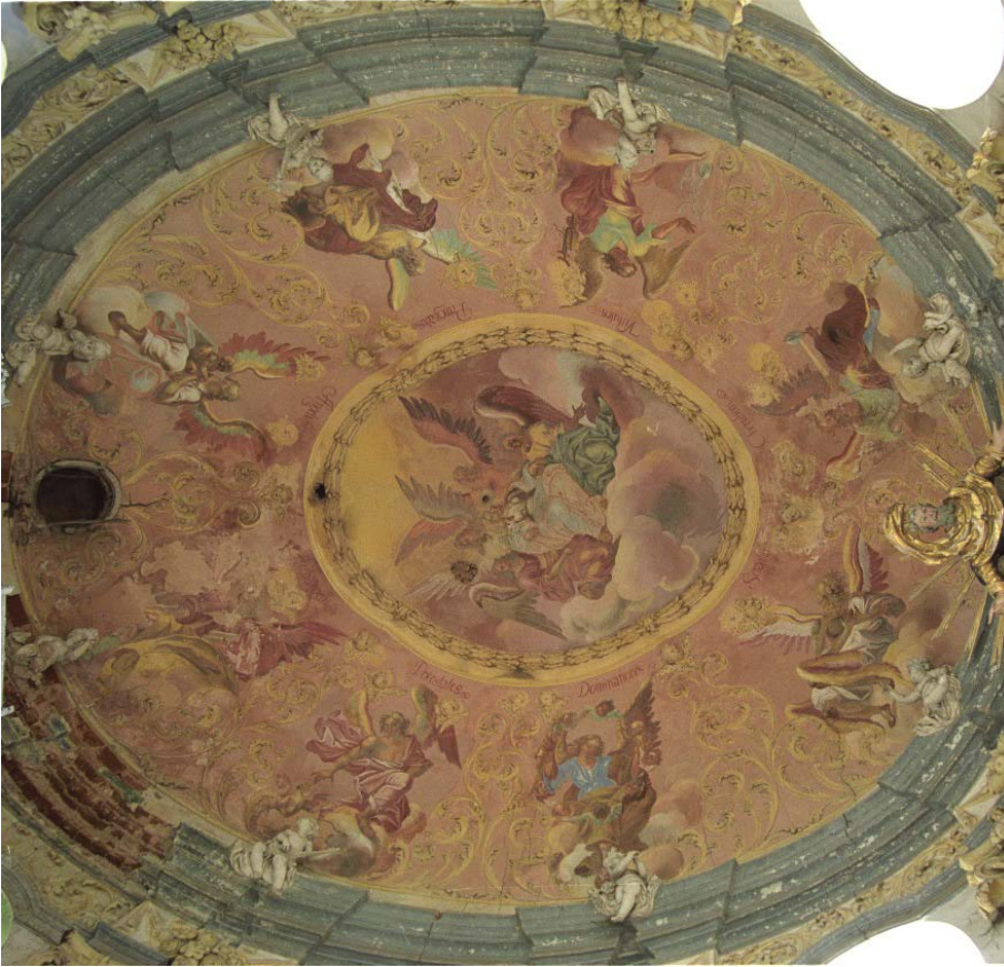
Obrázek 19 - Celkový pohled do kaple kaple sv. Isidora v Křenově. Fotografie není aktuální, neboť v současné době je prostor kaple vyplněn lešením.
