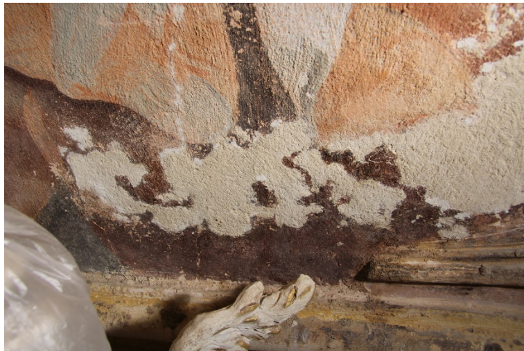
Obrázek 72 – dokumentace postupu práce, spodní část pole, oblast rozsáhlých tmelů. Stav po odstranění starších nevyhovujících tmelů a očištění barevné vrstvy.
