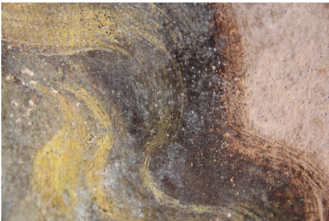
Obrázek 45 – Dokumentace poškození, detail vlasů anděla. Místa bílých zákalů se vyskytují v celé ploše malby. Na této fotografii jsou patrné i výkvěty vodorozpustných solí projevující se výrazně bílými tečkami.
