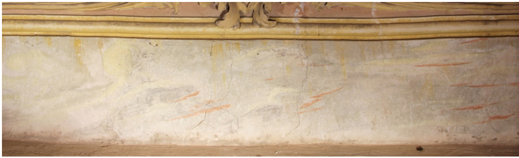
Obrázek 78- dokumentace postupu prací, pás s iluzivními oblaky. Stav po očištění a vytmelení defektů
