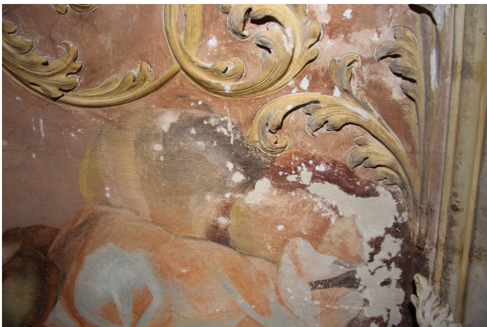
Obrázek 67 – spodní pravá část malby. Stav po vyčištění a tmeleňi.
