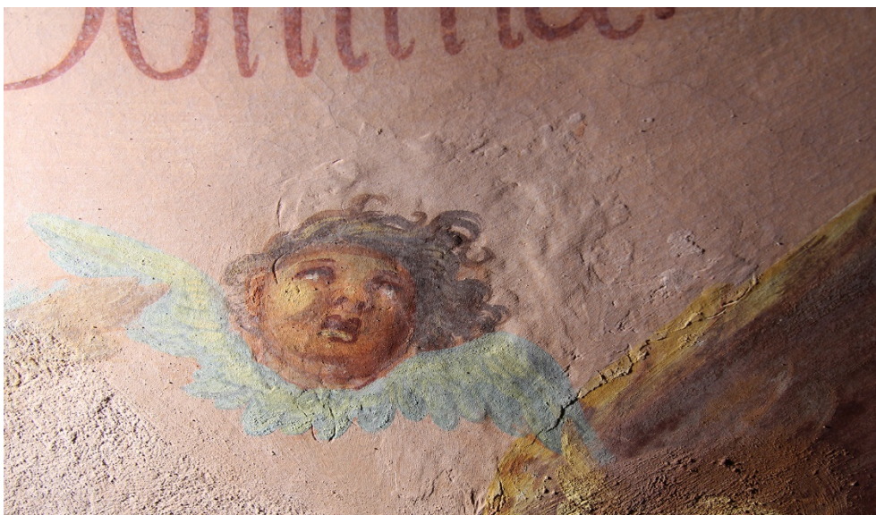
Obrázek 23 - fotografie detailu výjevu Dominaciones . V bočním světle je patrná plocha, která byla zakryta jemným štukem. Na některých místech (například vlevo) jsou patrné zbytky ryté kresby náčrtku štukového prvku andělské hlavičky.
