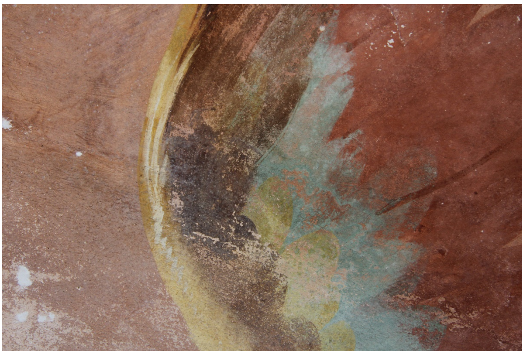
Obrázek 75 – dokumentace postupu práce, oblast levého křídla. Stav po vyčištění, zpevnění barevných vrstev a vytymelení defektů.
