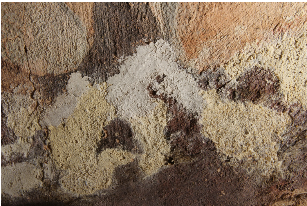
Obrázek 50 – dokumentace poškození, spodní část výjevu. Tato fotografie dokumentuje povahu předchozích tmelů. Zde je vidět, že bylo použito dvou druhů tmelu, z nichž ani jeden nerespektuje barevnost a strukturu okolních omítek.
