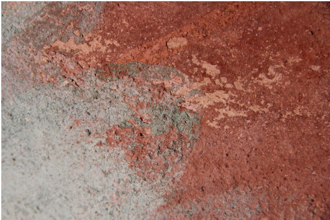
Obrázek 44 – Dokumentace poškození, pravé křídlo anděla. Detail degradované barevné vrstvy, jež se odlupuje od vrstvy intonaca prostřednictvím šupinek. Na mnoha místech došlo k jejímu odpadnutí
