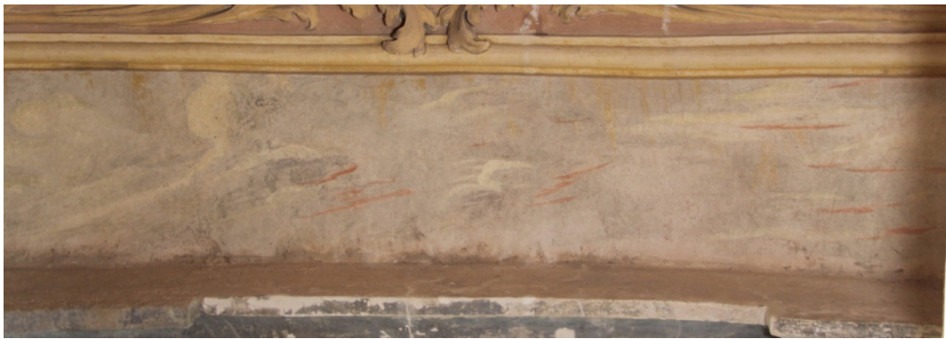
Obrázek 79 - dokumentace postupu prací, pás s iluzivními oblaky. Stav po restaurování
