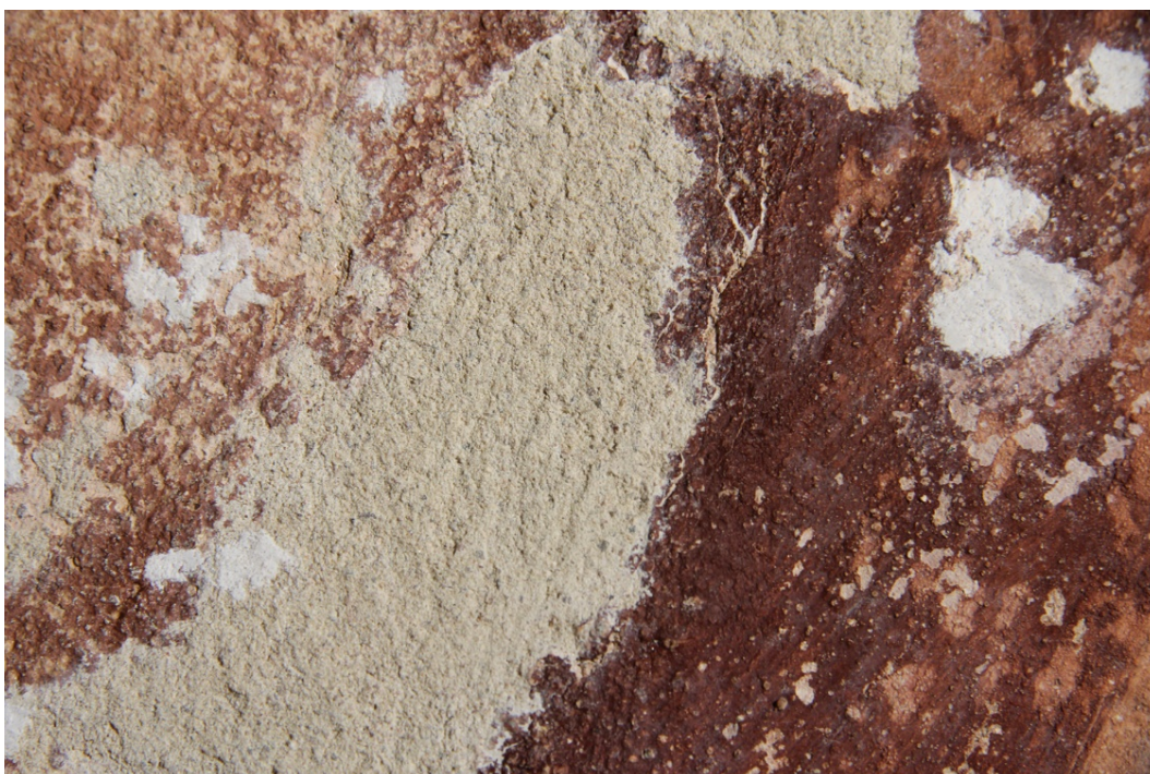
Obrázek 63 – fotografie dokumentující charakter aplikovaných hrubých tmelů. Ty byly pomocí skalpeli opatřeny strukturou napodobující okolní charakter omítky. V pravé části jsou viditelné jemnější tmely v oblasti hladkého intonaca.
