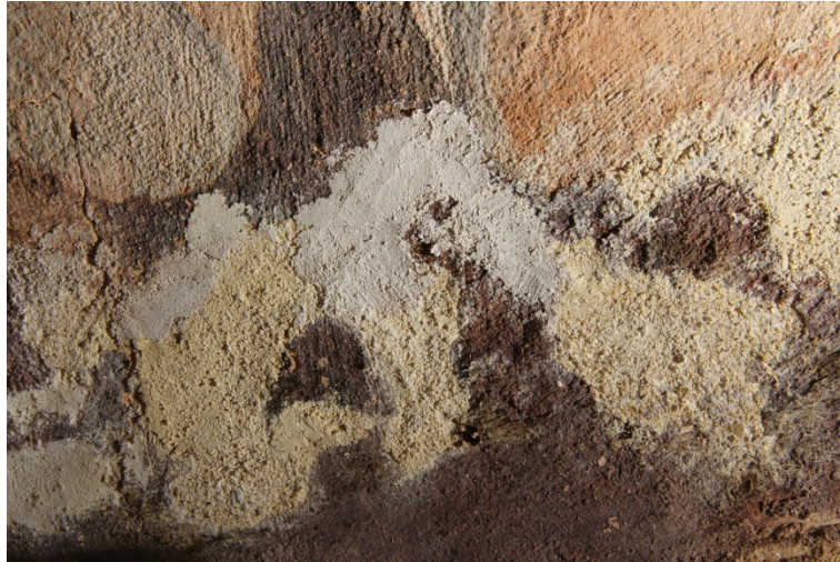
Obrázek 73 – dokumentace průběhu prací. Spodní část pole, oblast rozsáhlých tmelů.. Stav před restaurováním.
