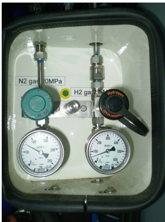
Obrázek 32: Ukazatele stavu vodíku a dusíku v prostoru palivového článku (50)
