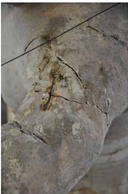
Obrázek 16 - Detail kramličky spojující prasklinu v levé ruce
