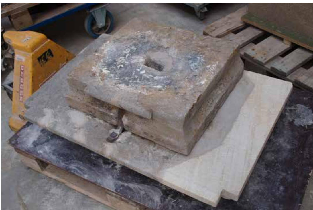
Obrázek 71 - Stav hlavice po tmelení a po doplnění kamenické náhrady
