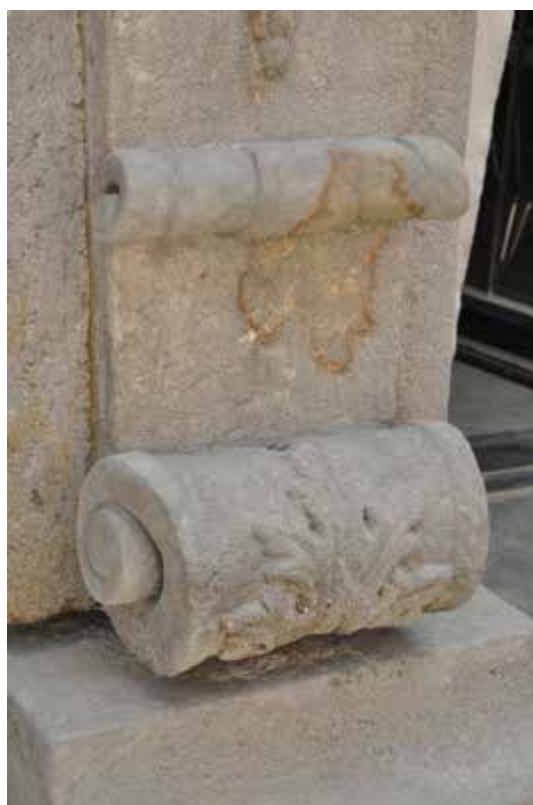
Obrázek 75 - Detail rekonstruovaných volut, stav po restaurování
