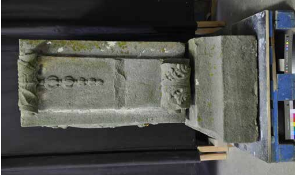
Obrázek 61 - Stav podstavce s patkou před restaurováním, pohled zleva
