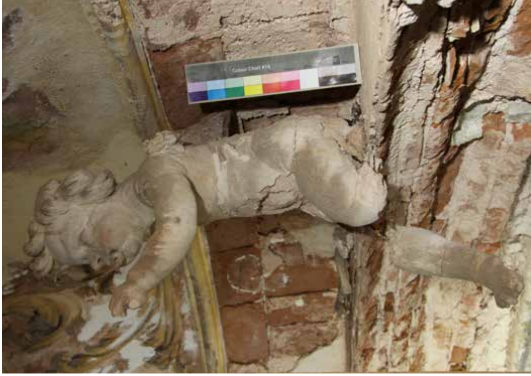
Obrázek 6 - Stav anděla č. 17 před restaurováním, pohled zprava
