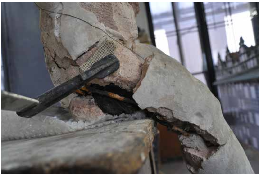
Obrázek 13 - Ilustrační fotka zajištění při injektáži
