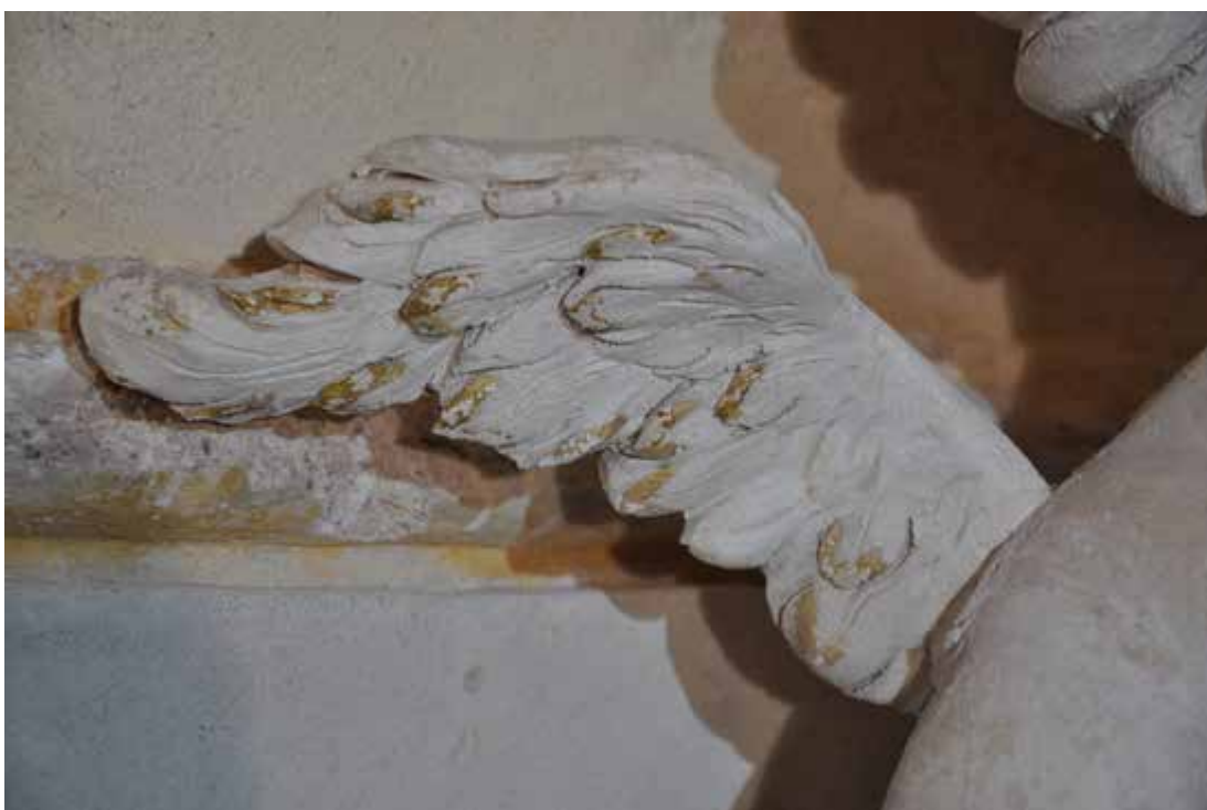
Obrázek 24 - Stav křídla po doplnění chybějící hmoty
