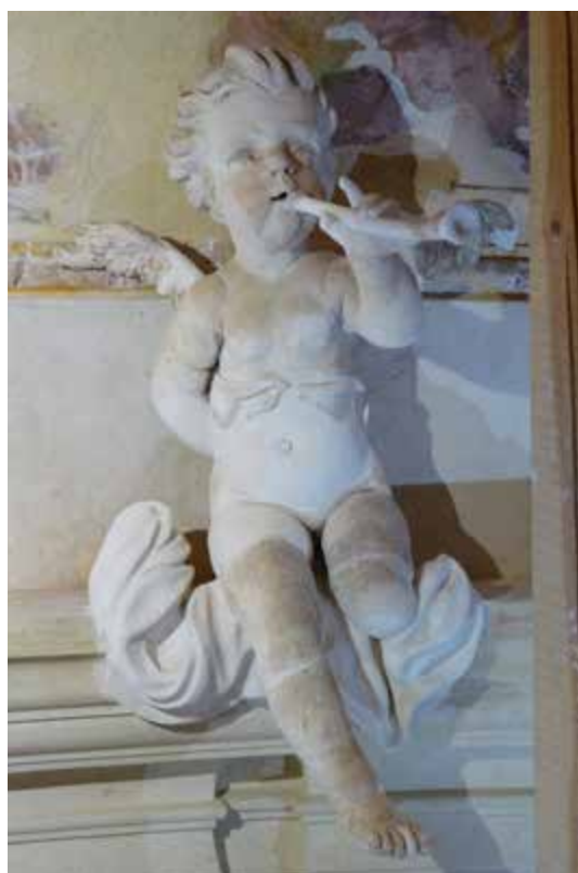
Obrázek 21 - Stav po nanesení jemné vrchní štukové vrstvy
