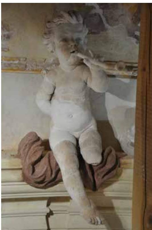
Obrázek 20 - Stav po nanesení hrubého jádra draperie
