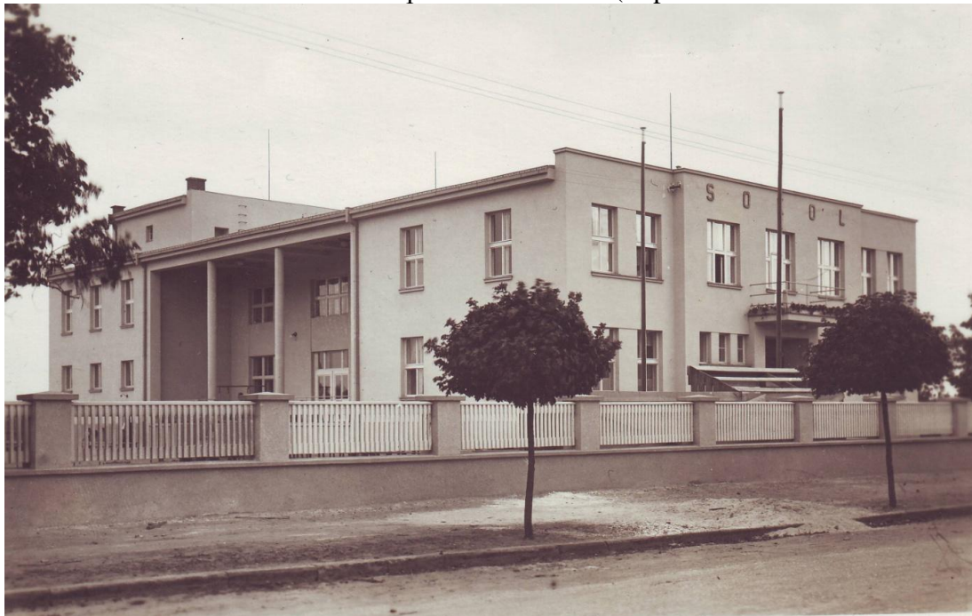
Obr. č. 13. Sokolovna Lázně Bohdaneč před rekonstrukcí ( http://www.sokolbohdanec.xf.cz/ )
