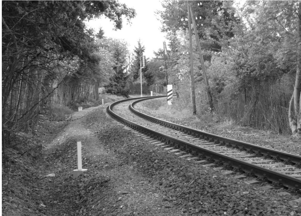
Obrázek č. 13: Prostor budoucí zastávky v Rudné, zdroj: autor
