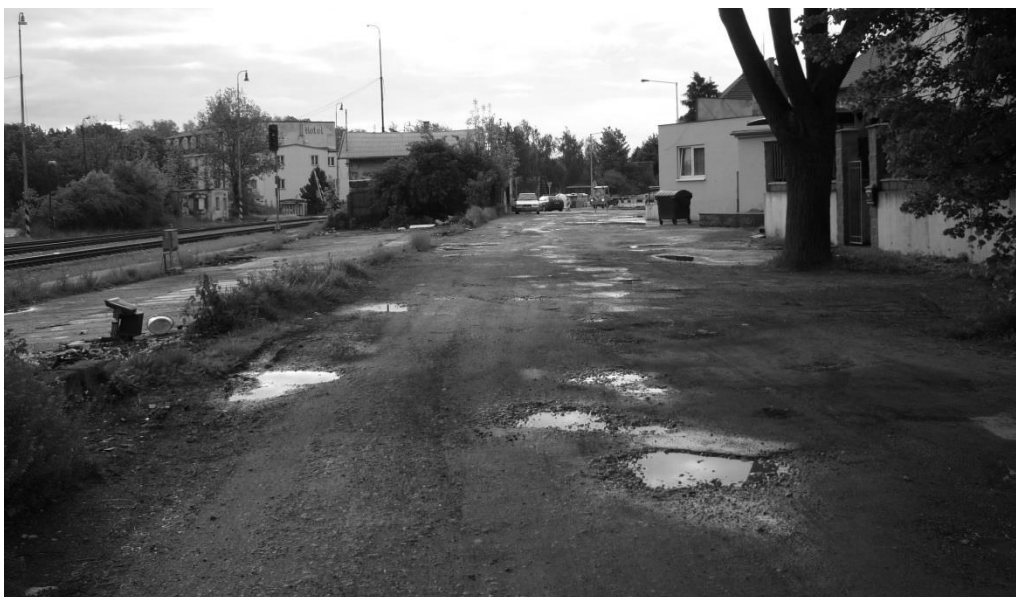
Obrázek č. 11: Nevyhovující komunikace od nádraží v Řeporyjích, zdroj: autor
