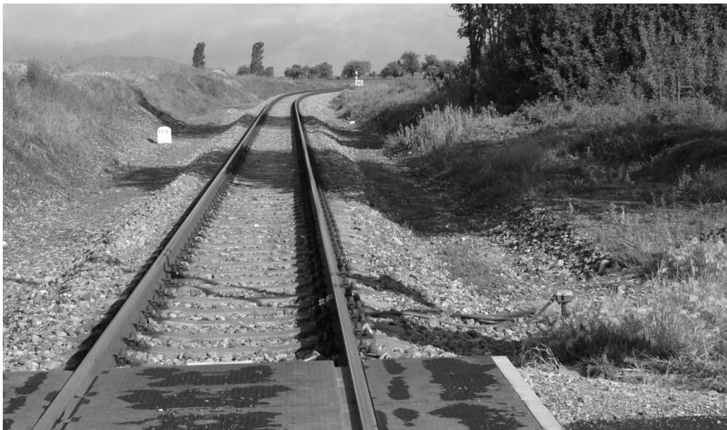
Obrázek č. 12: Prostor budoucí zastávky v Jinočanech, zdroj: autor
