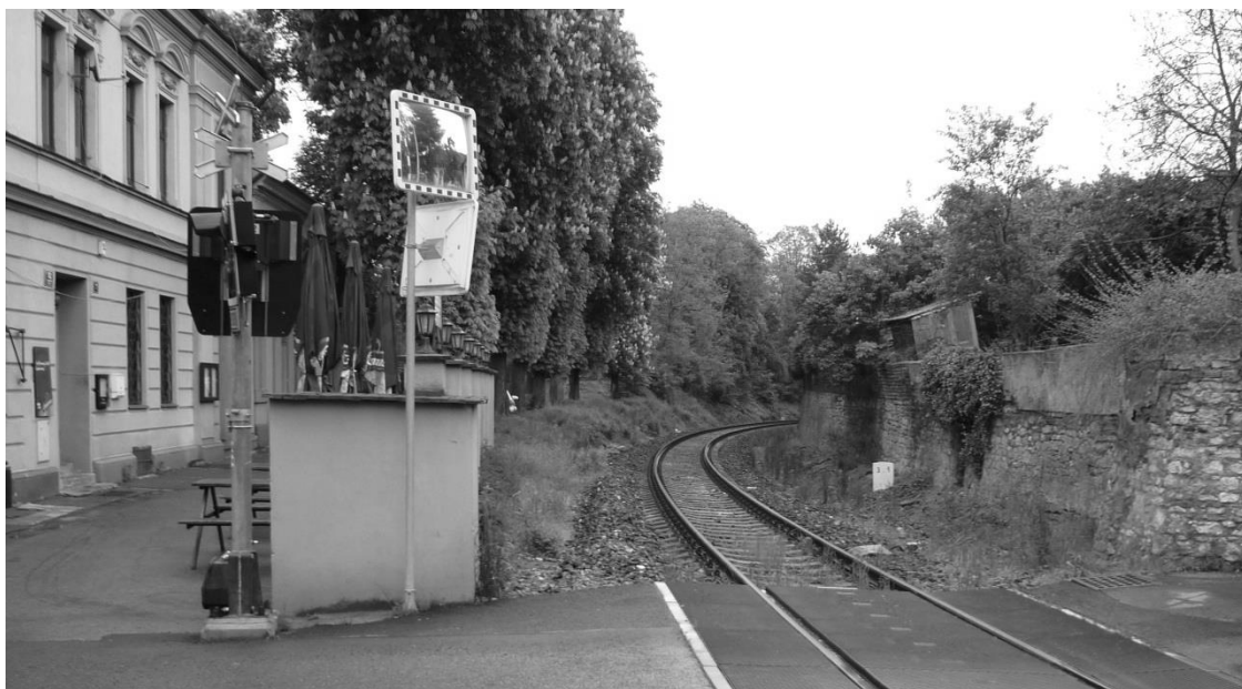
Obrázek č. 10: Prostor nové zastávky v Hlubočepích, zdroj: autor
