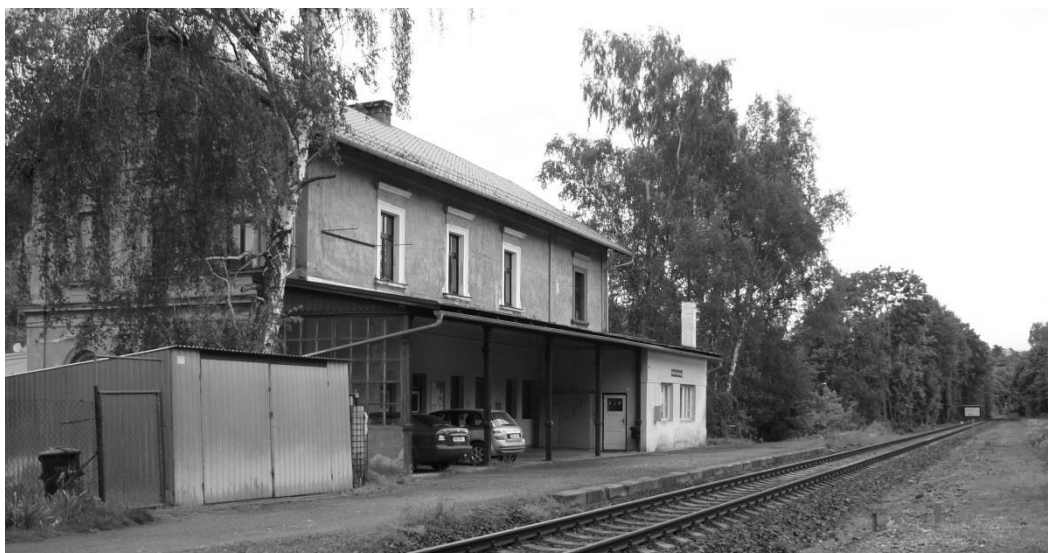
Obrázek č. 3: Nádraží Praha-Hlubočepy, zdroj: autor
