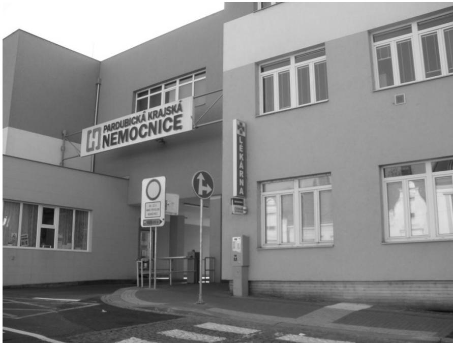
Obr. 3 Jízdenkový automat umístěný u budovy nemocnice
