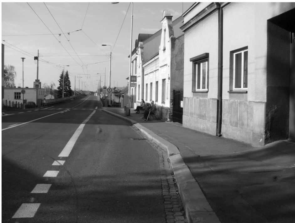
Obr. 2 Chybějící přístřešek na zastávce Nemocnice směrem do centra
