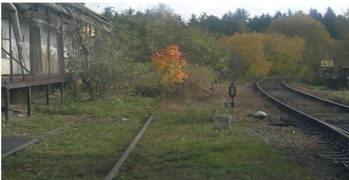
Obrázek č. 9: Skladiště na zastávce Sepekov
