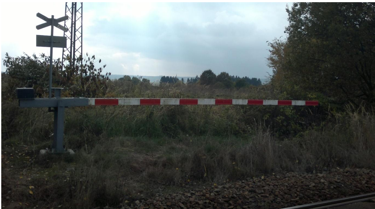
Obrázek č. 6: Aktuální stav železničního přejezdu v žst. Balkova Lhota
