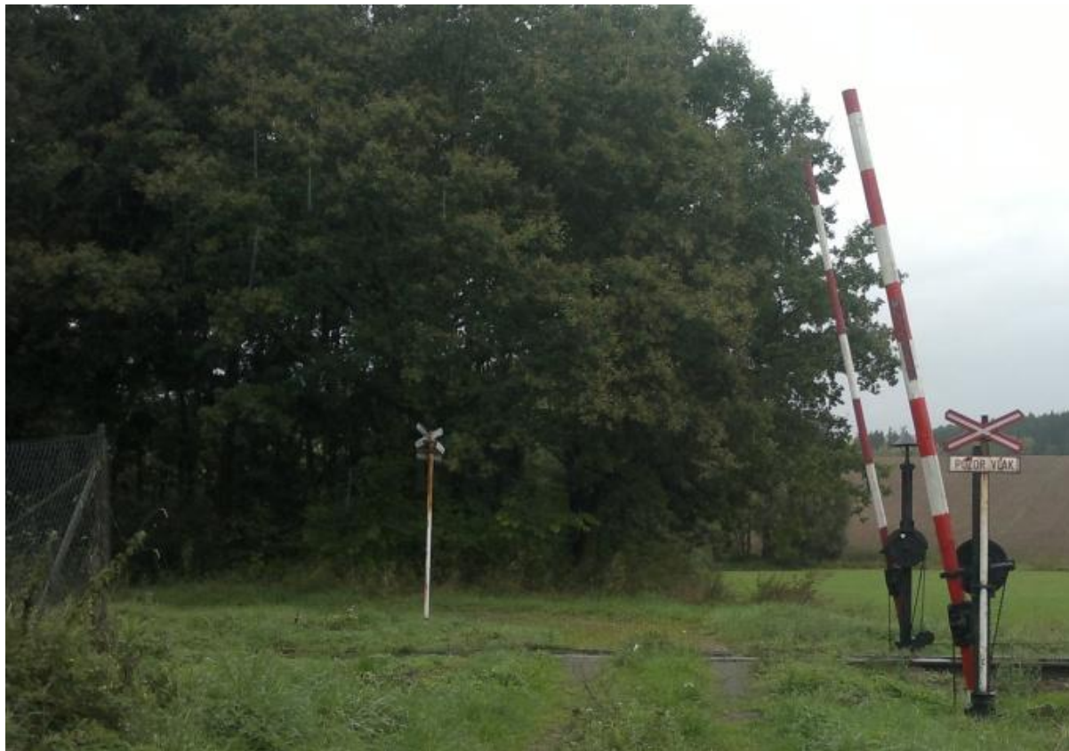
Obrázek č. 15: Současný stav železničního přejezdu mezi žst. Záhoří – Písek město
