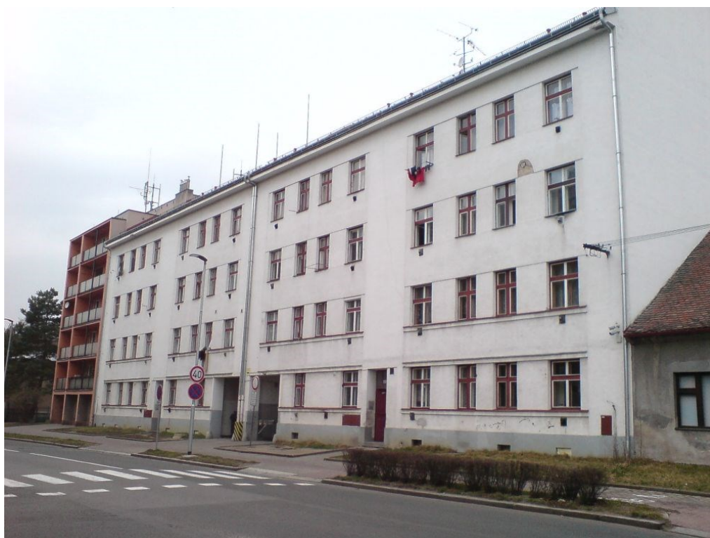
Obr. č. 5 – Pohled na lokalitu z ulice Husova b
