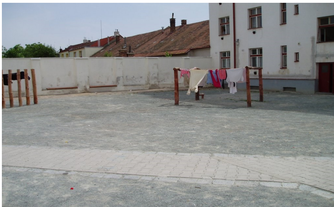
Obr. č. 10 – Opravený vnitroblok a
