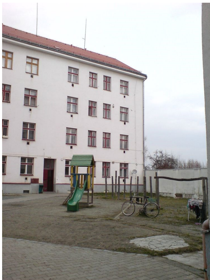
Obr. č. 14 – Vnitroblok nyní b
