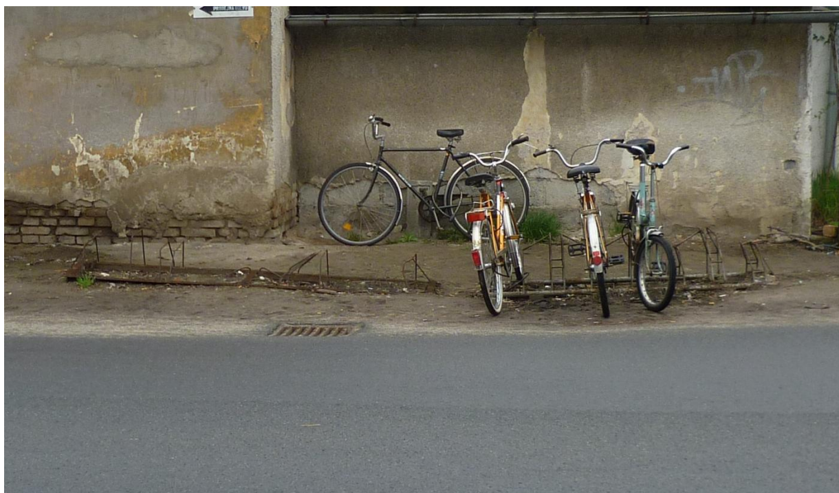
Obr. 4: Stav kolostavu v ulici Nádražní
