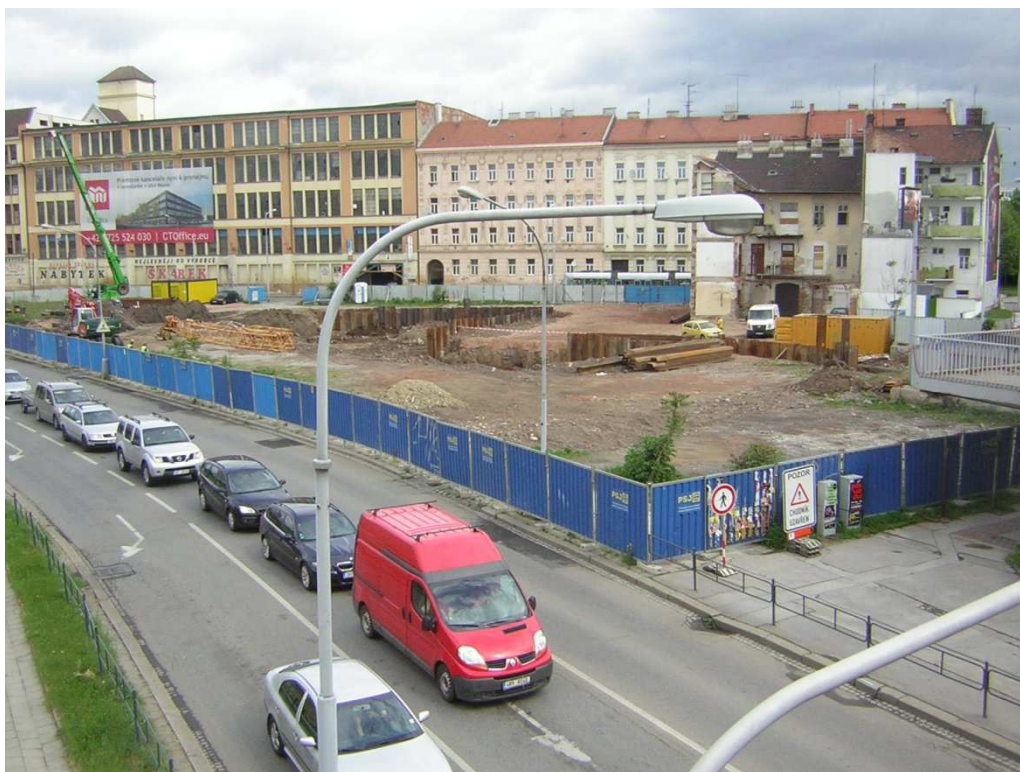
Obr. 6 Demolice staveb podél ulice Plotní
