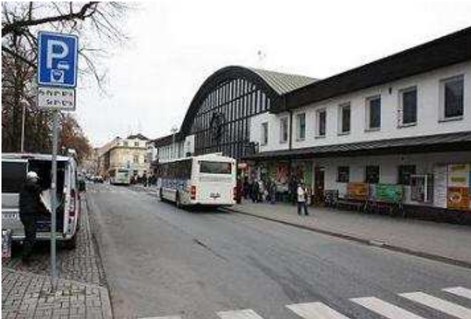
Obr. B26 Pohled od ŽST k AN, pohled z ulice Valdovská; Tábor
