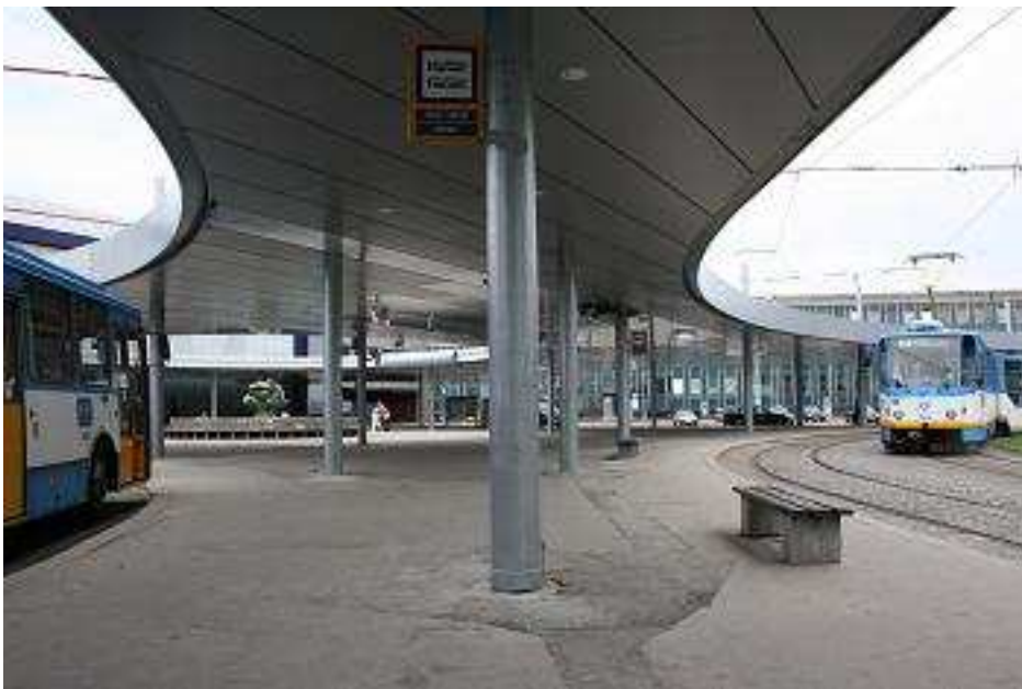
Obr. B31 Přednádraží prostor ŽST Ostrava hl. n. před rekonstrukcí
