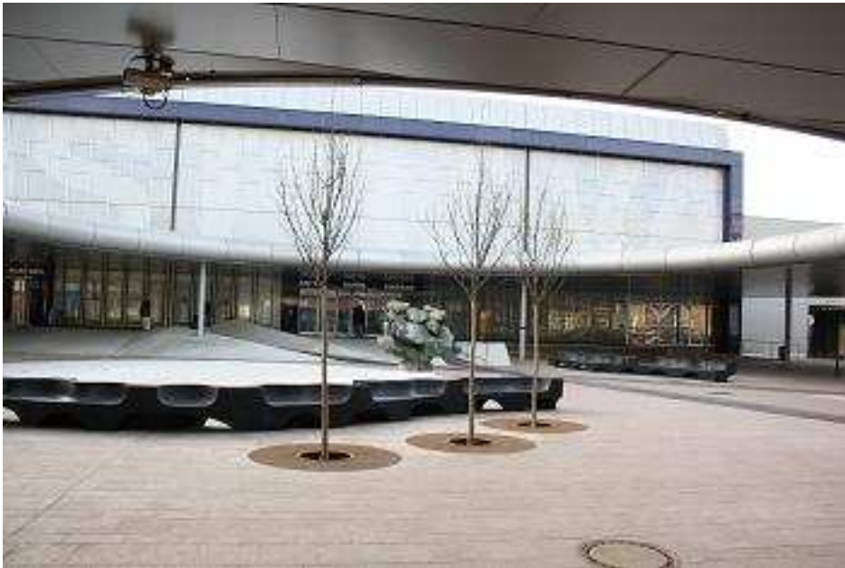
Obr. B32 Přednádraží prostor ŽST Ostrava hl. n. po rekonstrukci
