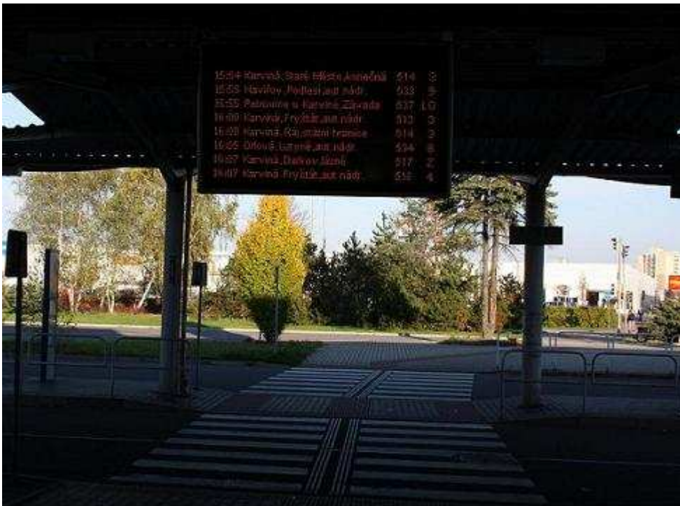
Obr. B35 Elektronická tabule informující cestující o nástupištích jednotlivých autobusových spojů; Karviná
