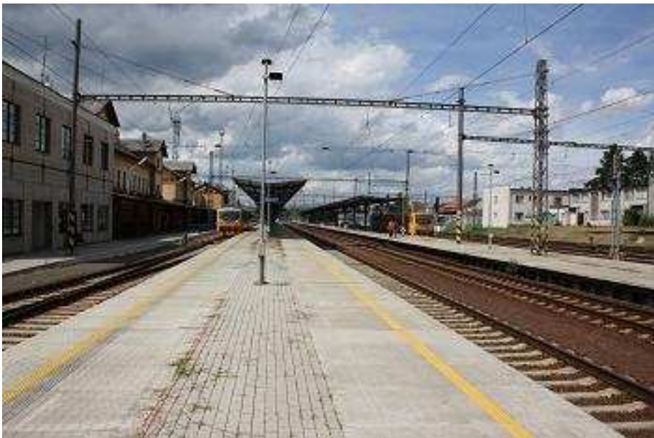
Obr. B25 Železniční stanice Tábor; pohled z 2. nástupiště
