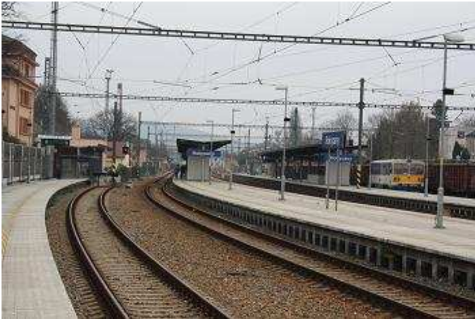
Obr. B28 Železniční stanice Rokycany; pohled z 1. nástupiště
