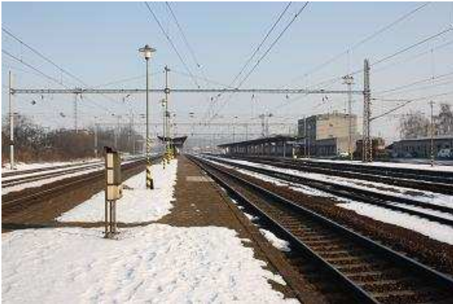
Obr. B04 Železniční stanice Hranice na Moravě; pohled z 3. nástupiště
