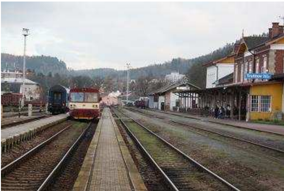
Obr B19 Železniční stanice Trutnov hl. n.; pohled z 3. nástupiště
