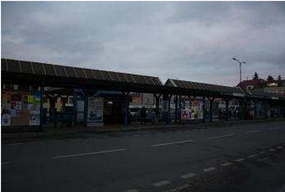
Obr. B24 Pohled od ŽST k AN; Benešov u Prahy
