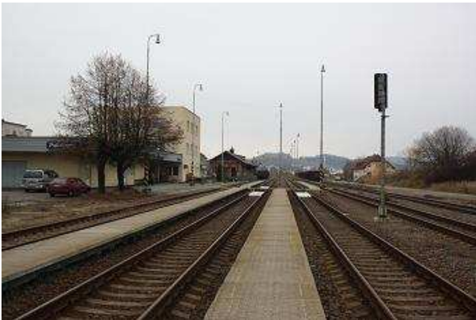
Obr. B13 Železniční stanice Pelhřimov; pohled z 2. nástupiště
