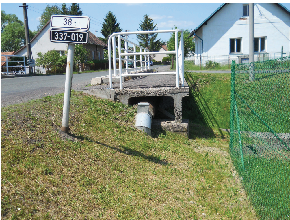
Detail stávajícího mostu
