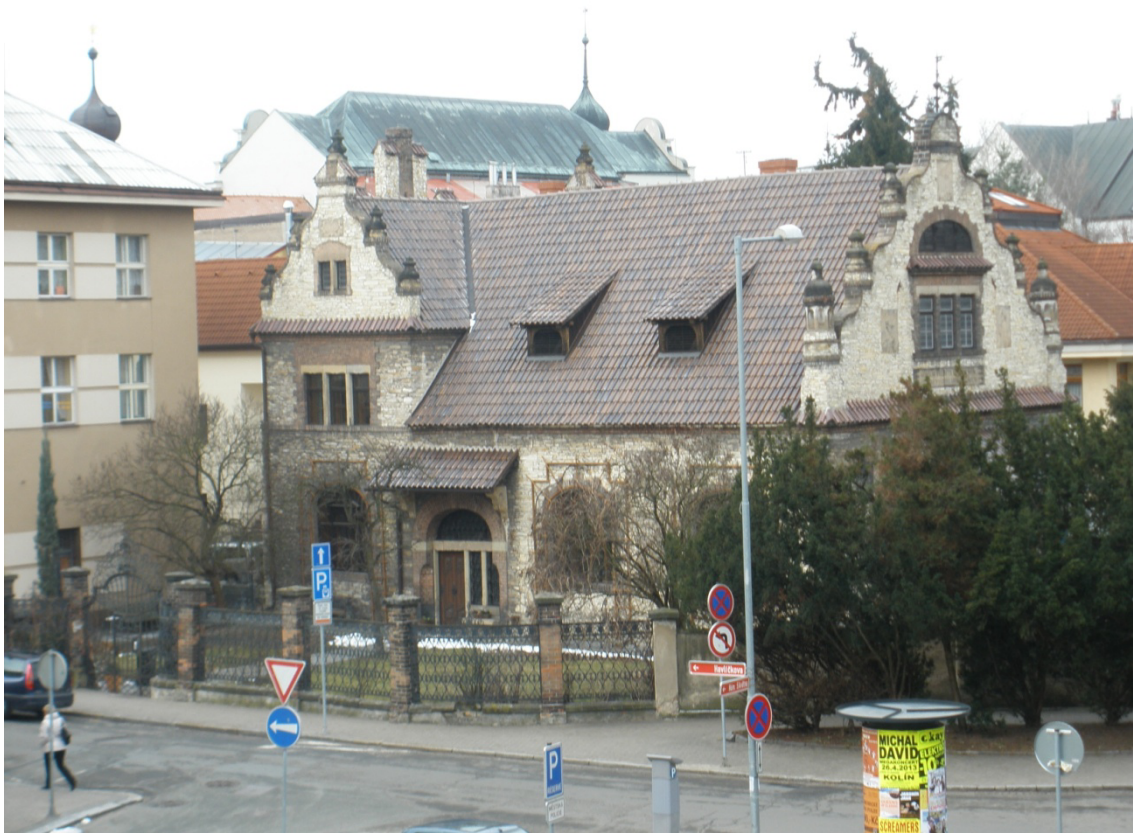
Obr. č. 18 Obereignerova vila, ulice Havlíčkova 1/ III.
