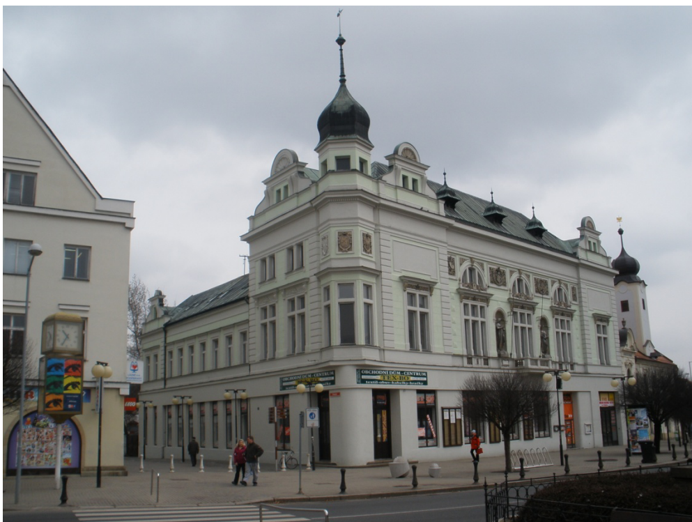
Obr. č. 15 Občanská záložna v Poděbradech, současný stav.
