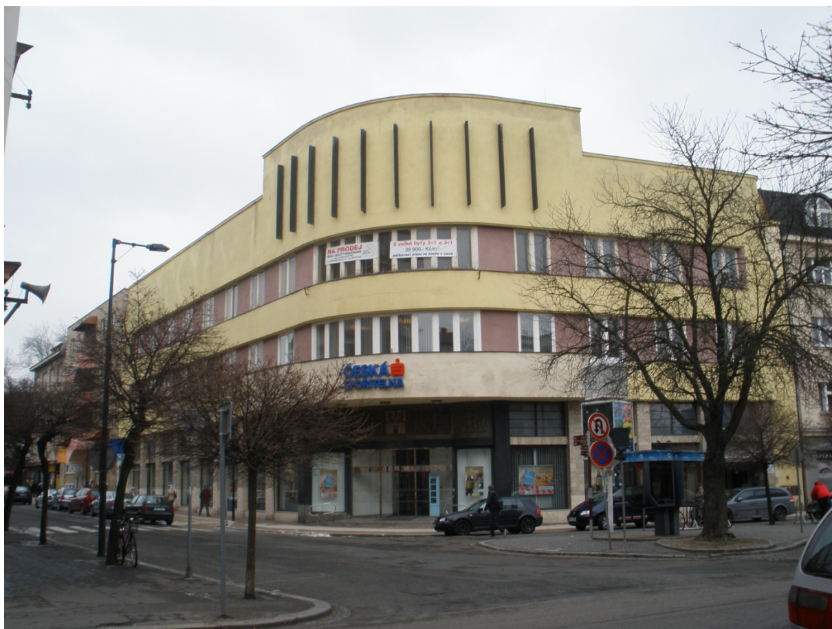
Obr. č. 16 Budova České spořitelny, Riegrovo náměstí 4/ 27.
