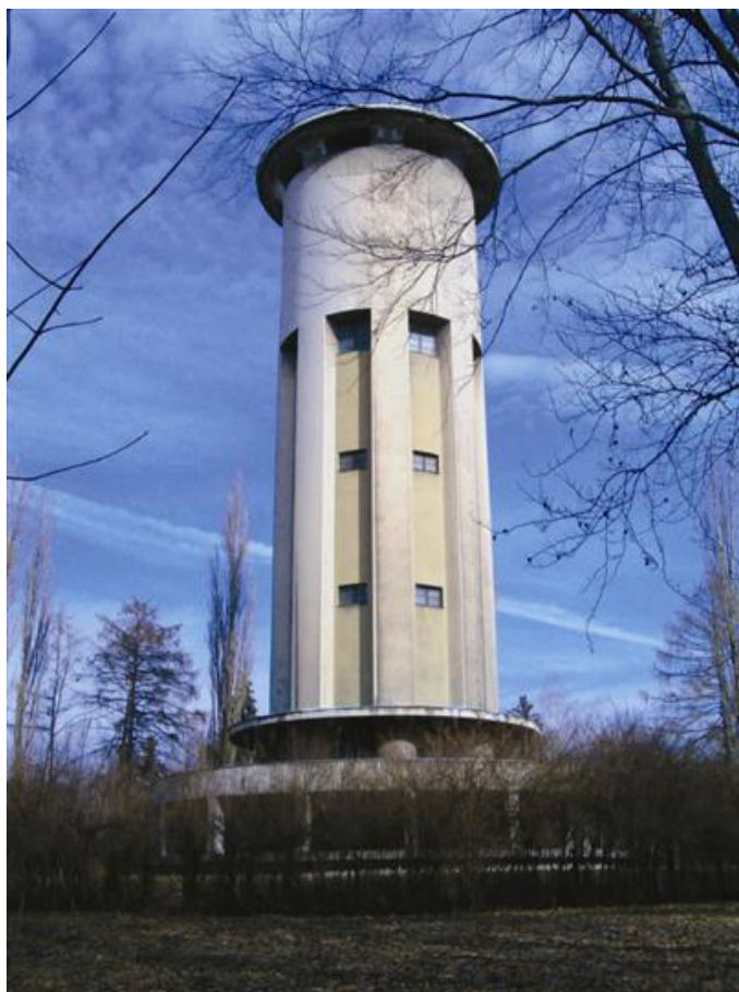
Obr. č. 5 Vodojem, ulice U nové vodárny.
