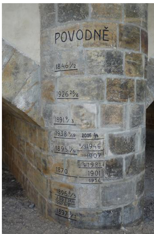
Obr. č. 6 Ukazatel hladiny při povodních na prvním pilíři inundačního mostu.
