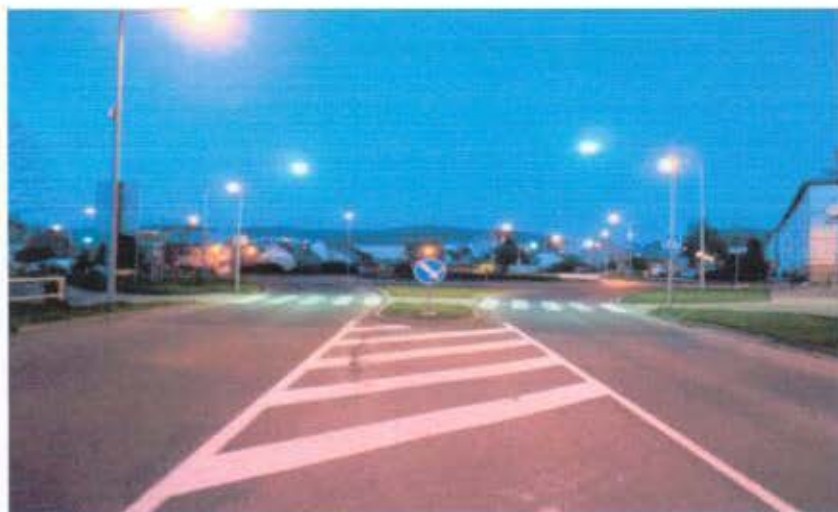
Obr. 10 - Osvětený přechod pro chodce s bezpečnostním ostrůvkem
