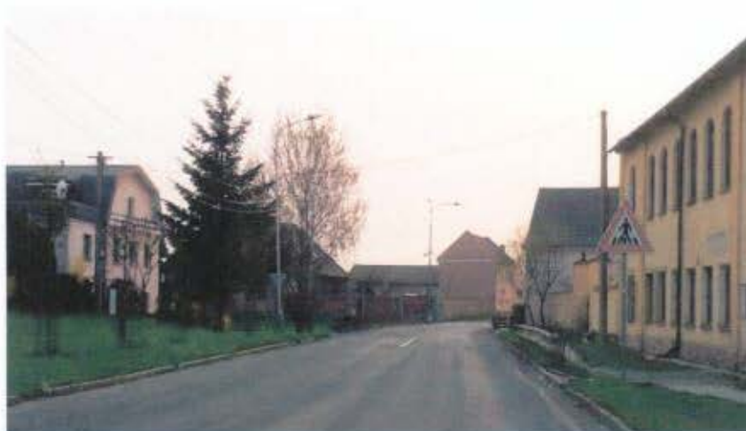
Obr. 8 - Nevhodně umístěný přechod pro chodce
