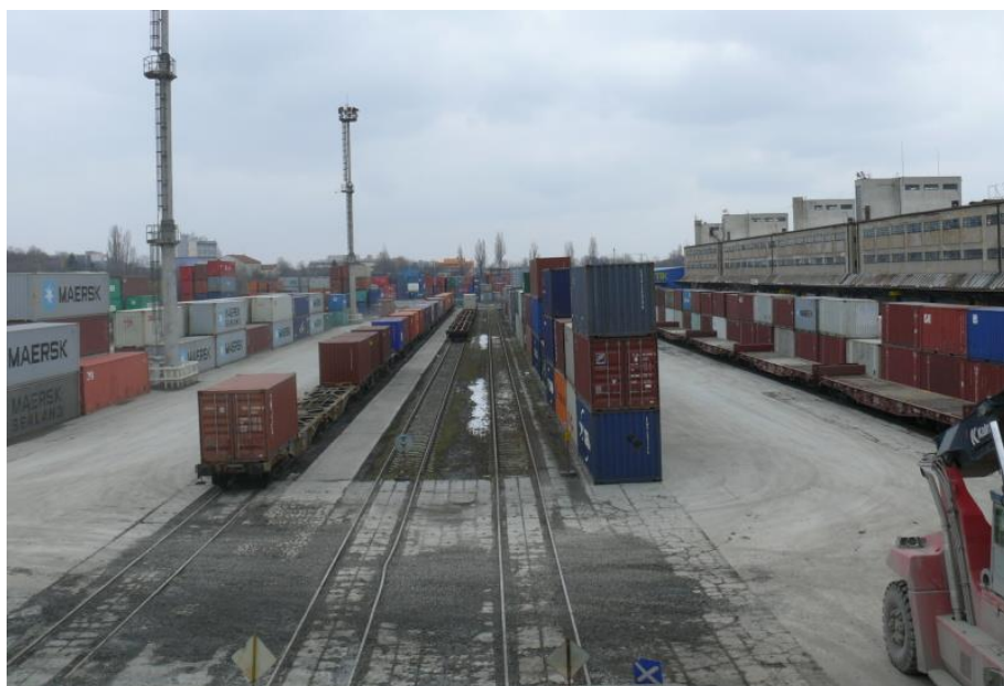
Obrázek 2 Koleje v kontejnerovém překladišti ČSKD INTRANS Praha-Žižkov
