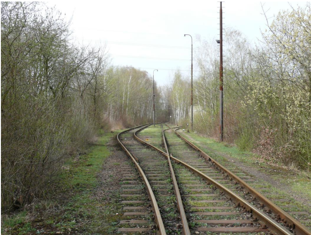
Obrázek 2 příloha E: Výhybna od výhybky S5
