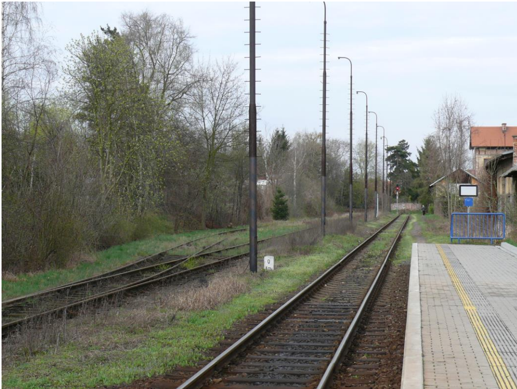
Obrázek 1 příloha E: Zleva odstavné kusé koleje 2A, 1A, výhybka S2 a traťová kolej
