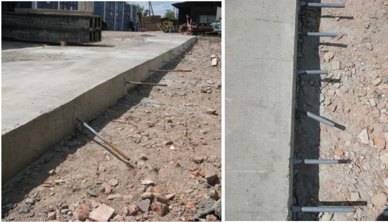
Obr. 5 Pohled na zkušební úsek se zabudovanými kotvami a pohled shora na kluzné trny
