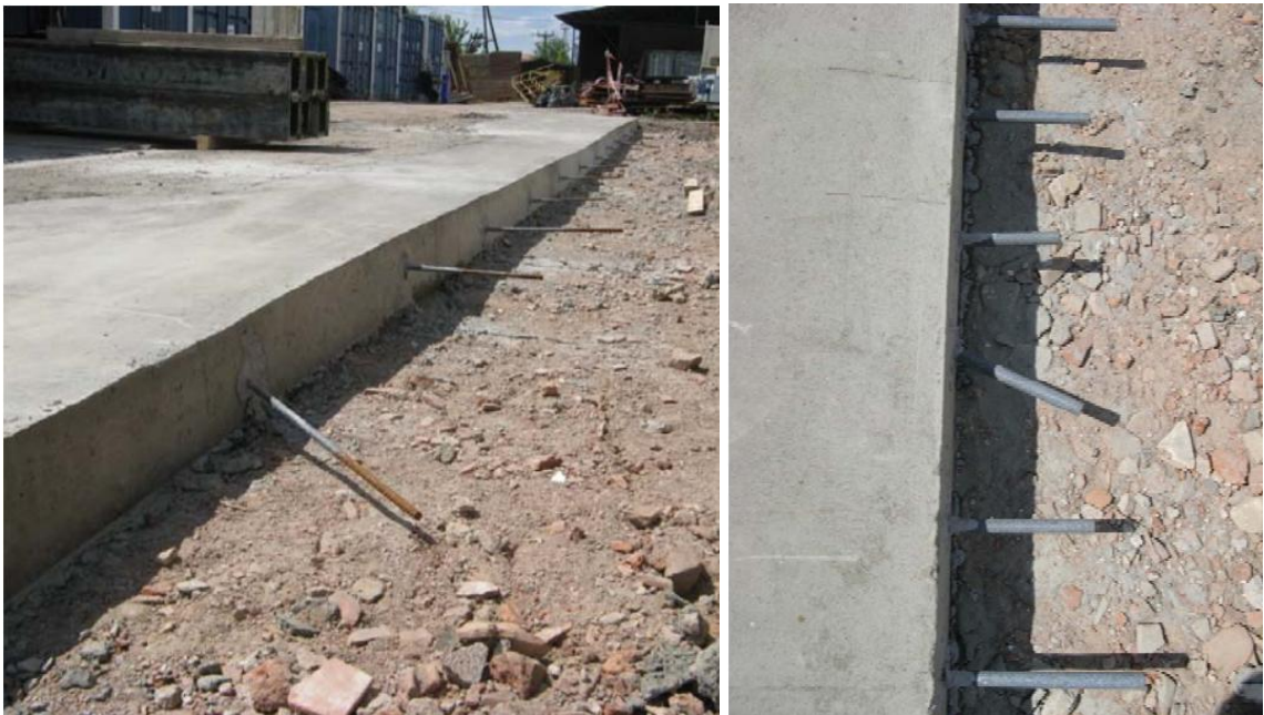
Obr. 79 Pohled na zkušební úsek se zabudovanými kotvami a pohled shora na kluzné trny
