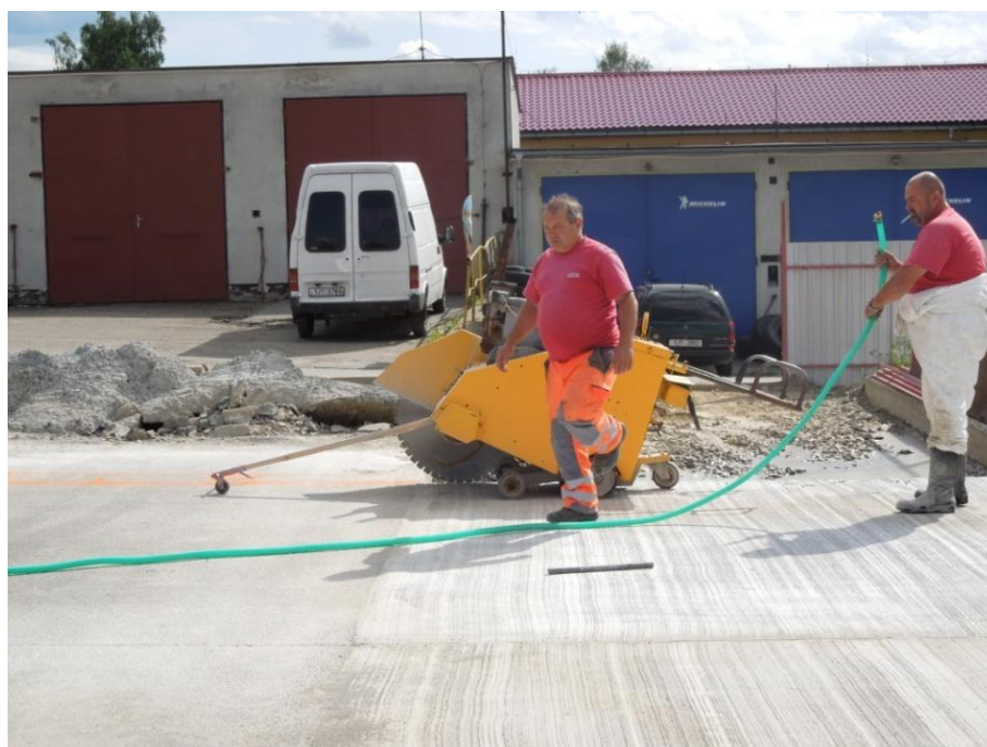
Obr. 66 Destruktivní stanovení polohy kluzných trnů – řezání trámce s osazenými kluznými trny
