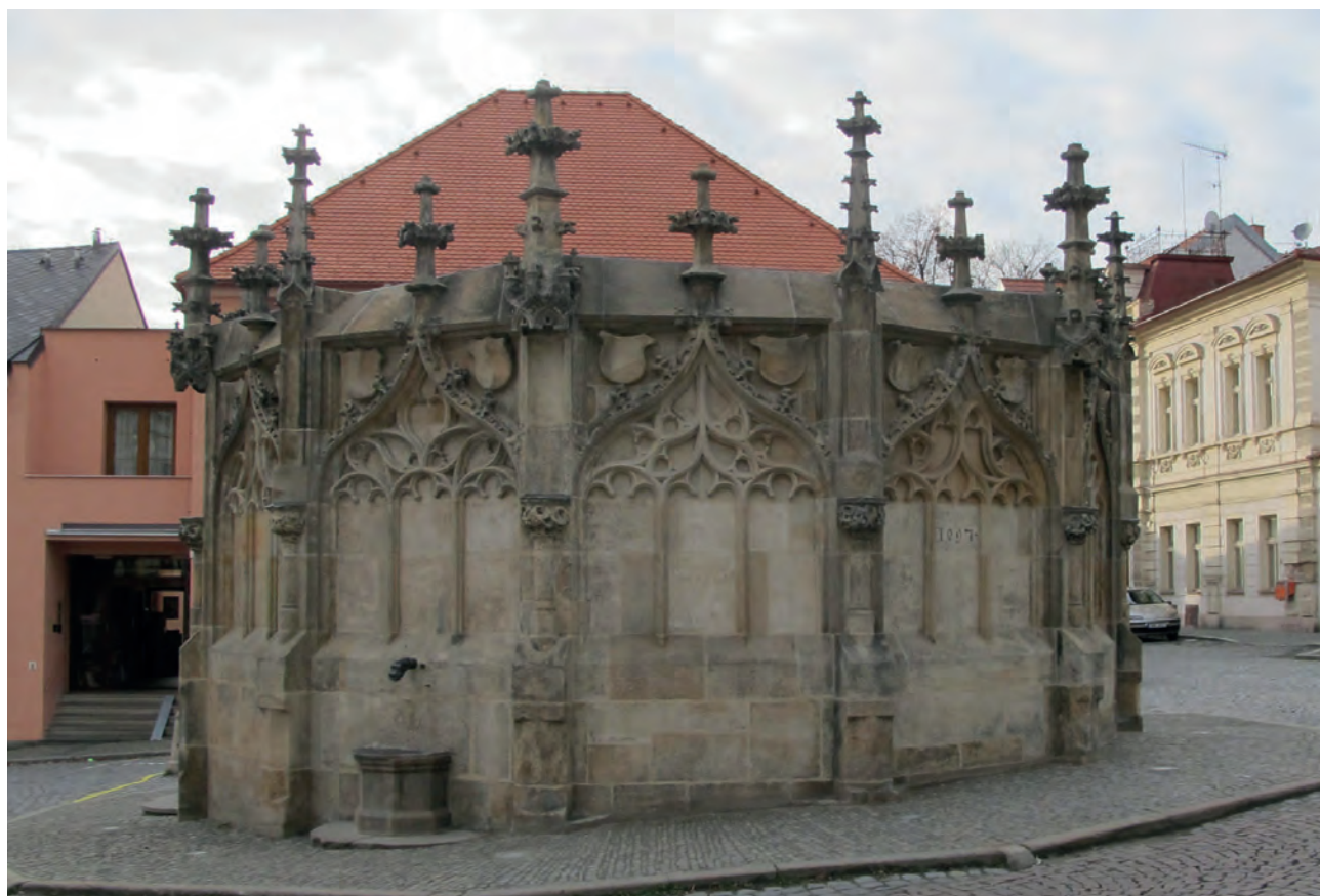
Stav po dokončení prací.
