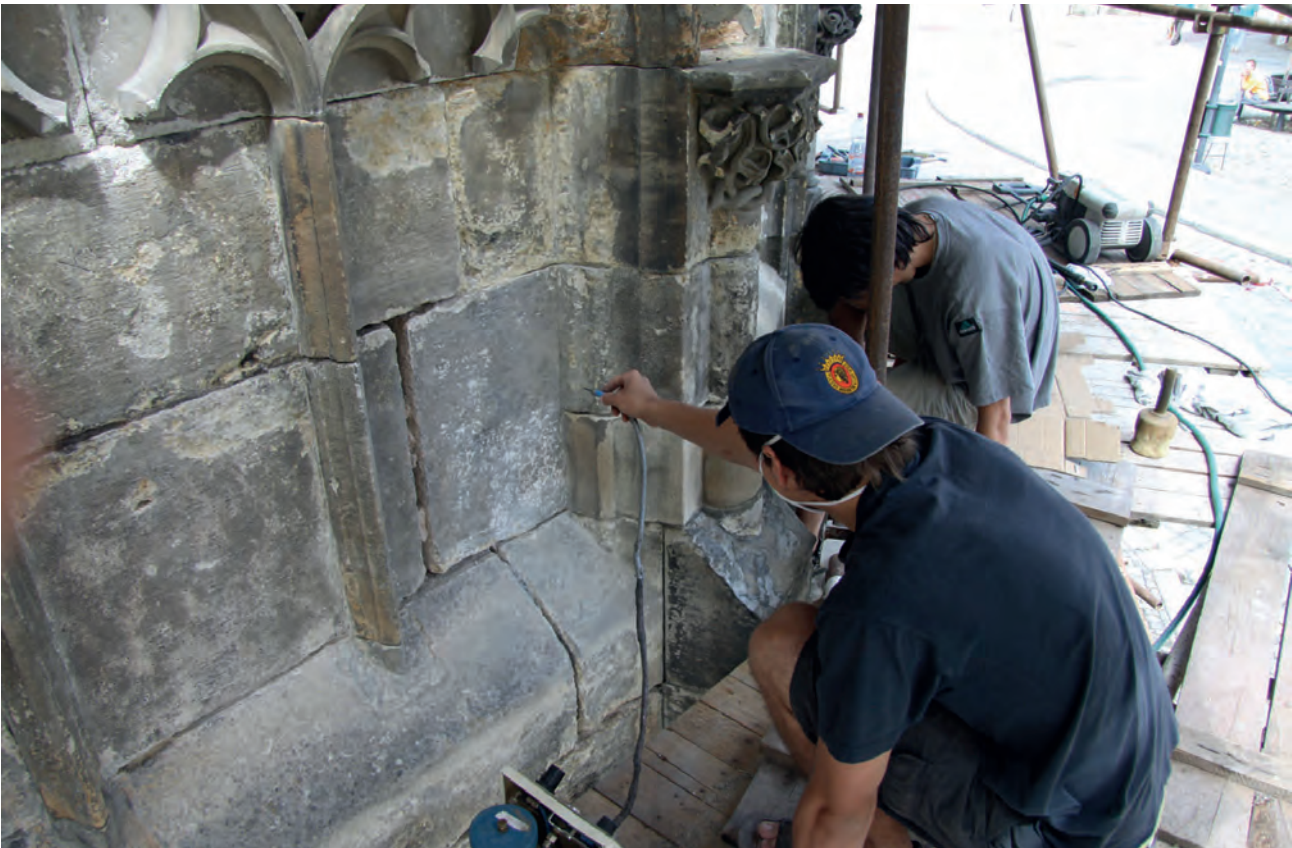
Průběh prací, čištění pomocí mikrotryskávání.
