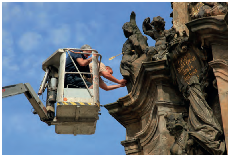
Zjišťování stavu vybraných částí sloupu neinvazivní metodou ultrazvukové transmise.
