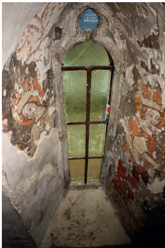
Celkový pohled na okenní špaletu. Stav po restaurování.
