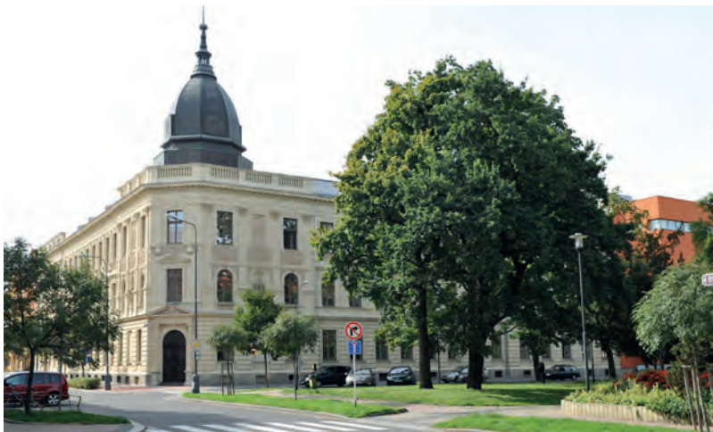
Pohled na fasádu po dokončení prací.
