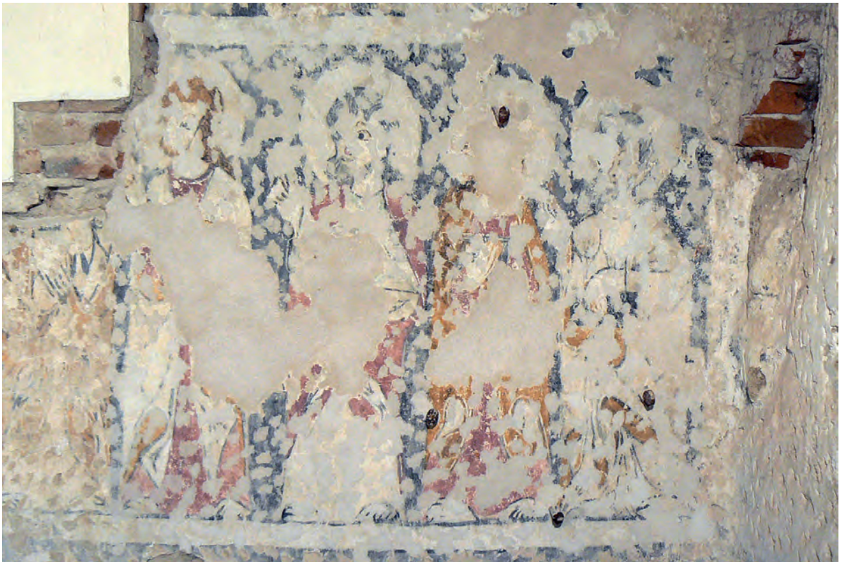
Celkový pohled na referenční plochu. Stav po restaurování.
