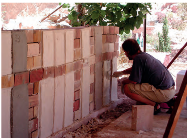
Zkoušky doplňovacích malt na zkušební zdi.
