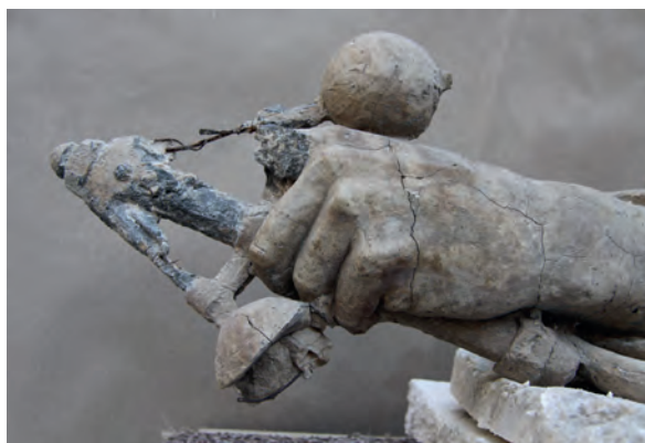
Typické poškození románského cementu – síť prasklin v důsledku koroze kovových armatur, přirozená síť trhlin v důsledku zrání materiálu.
