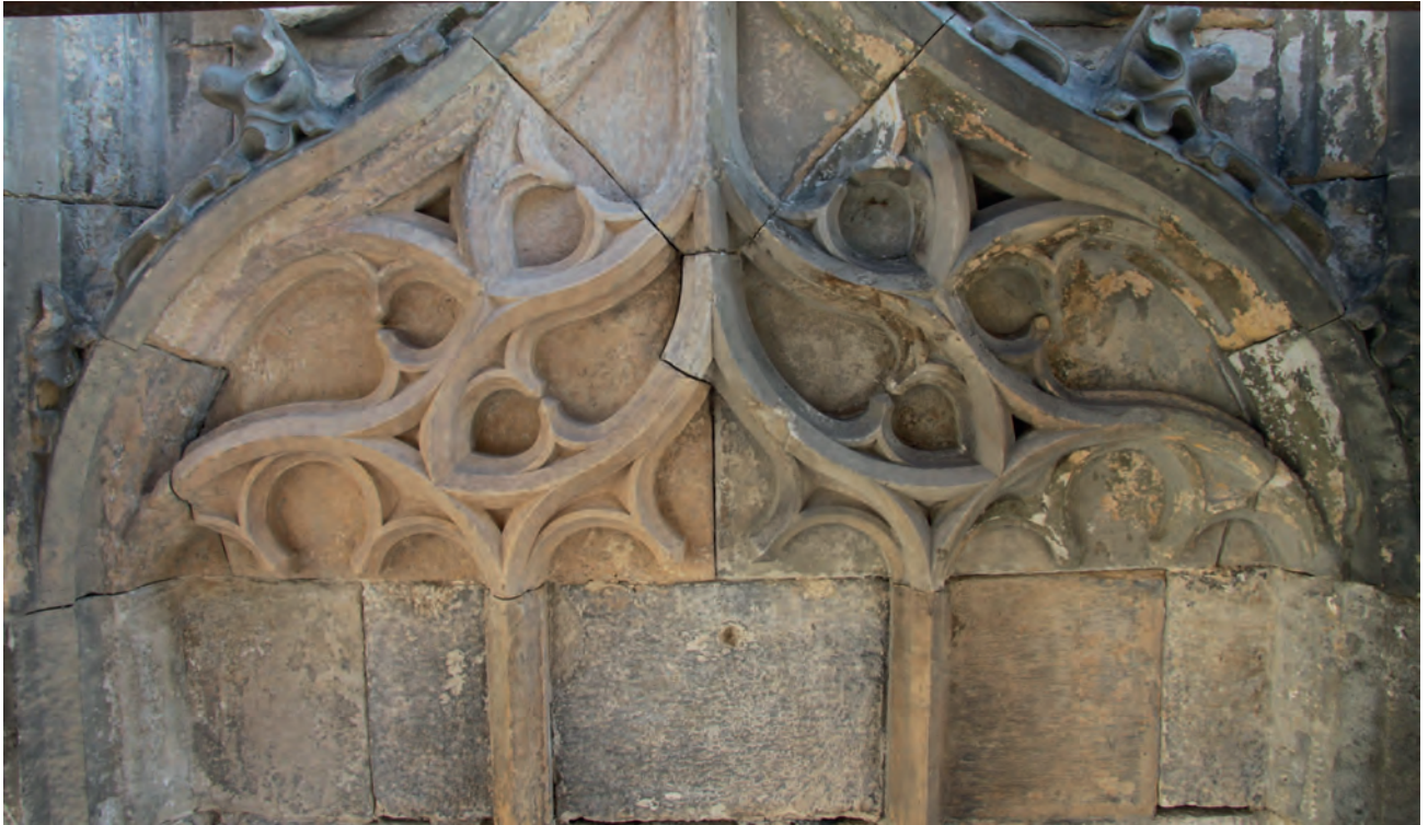
Průběh prací, stav po částečném očištění.
