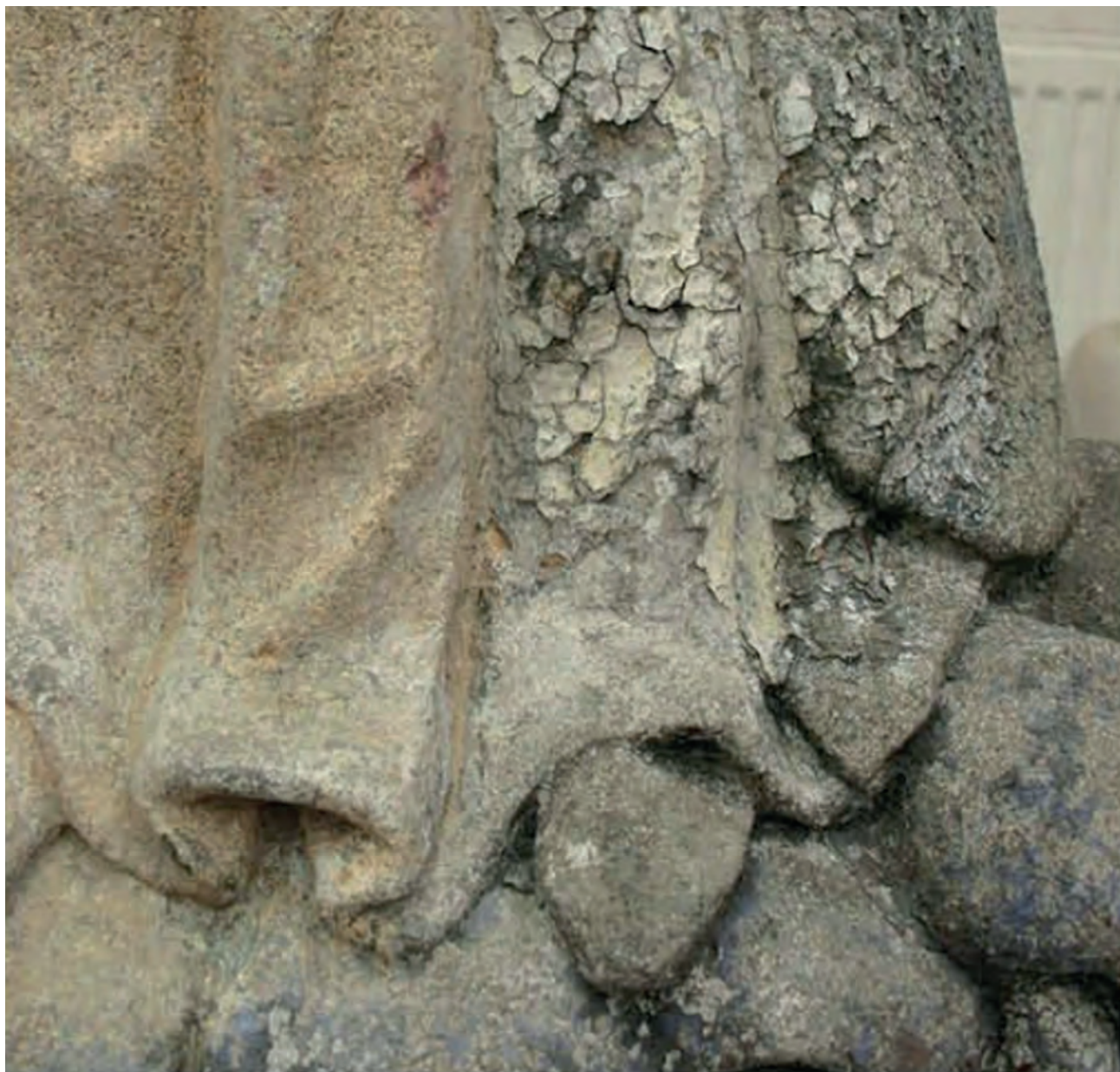
Snímání pozdějších přemalovaných zaslepujících modelací.
