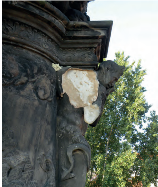
Sousoší sv. Vincence Ferrerského a sv. Prokopa, detail poškození.
