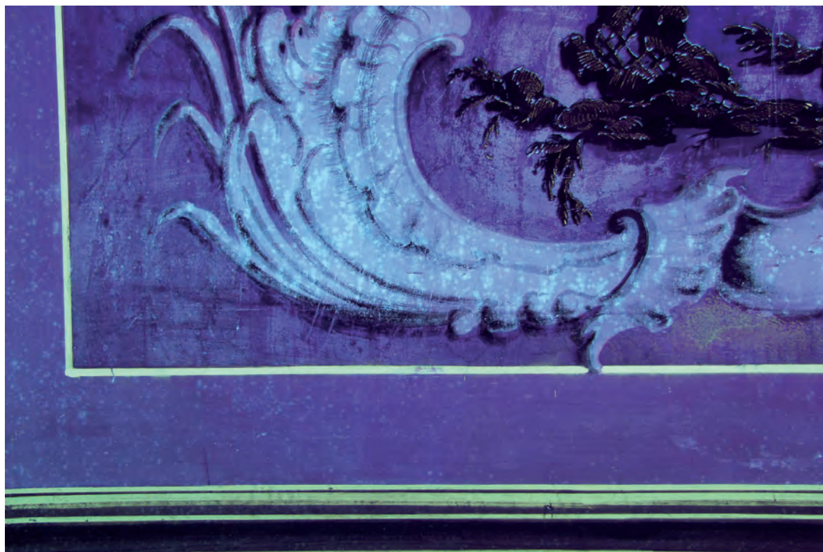
Detail malby ve východní části jižní stěny – fotografie v UV světle – žlutozelenou luminiscencí se projevují přemalby bílých linek rámování, světle modré až bělavé skvrnky jsou projevem výskytu plísní.
