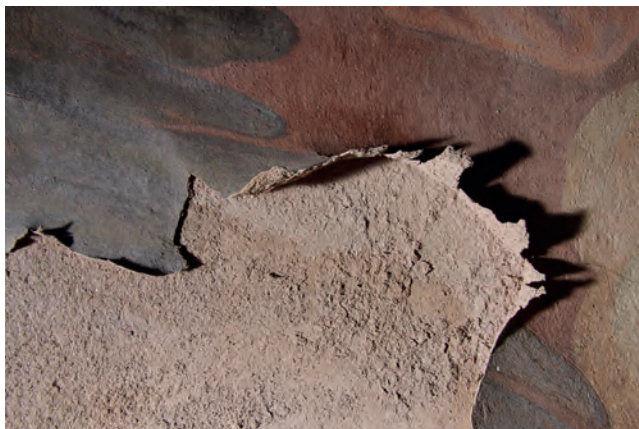
Typická poškození nástěnné malby: odlupování barevné vrstvy od podkladu a krystalizace vodorozpuštěných solí.
