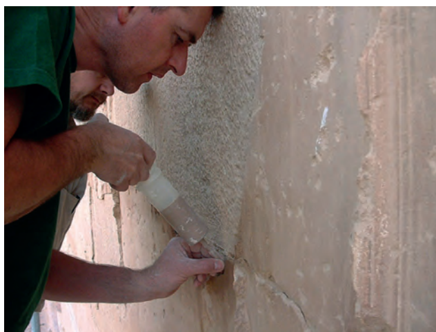
Testování injektážních prostředků pro stabilizaci omítek.
