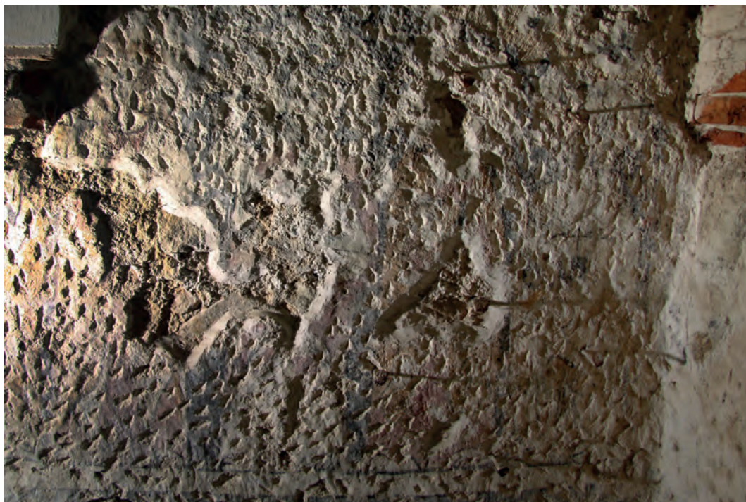
Peky se zajišťovacími tmely a jiná mechanická poškození, která znesnadňují čitelnost malby. Foto v razantním bočním osvětlení. Stav před restaurováním.
