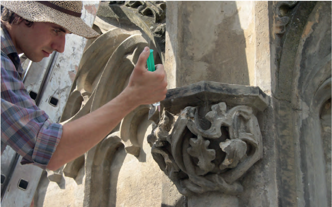
Průběh prací, zajištění narušeného kamene.
