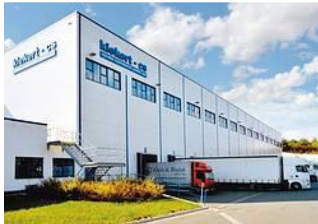
Obr. 4.15 - Výrobní hala Přelouč
