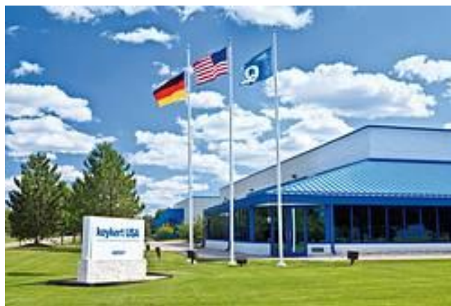
Obr. 4.16 - Výrobní hala Wixom
