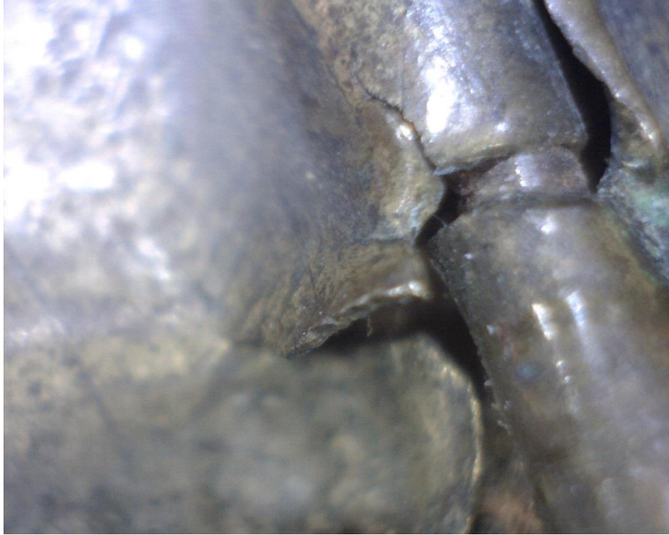
Obr. č. 31 Pohled na mikropraskliny v kovovém pokryvu z USB mikroskopu
