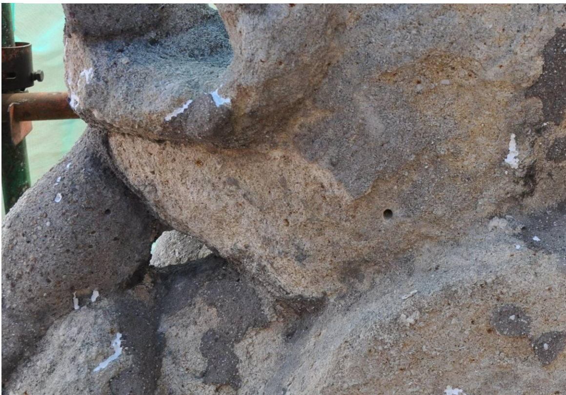
Obr. 11) Detail zadní části po očištění mikroabrazí a injektáží
