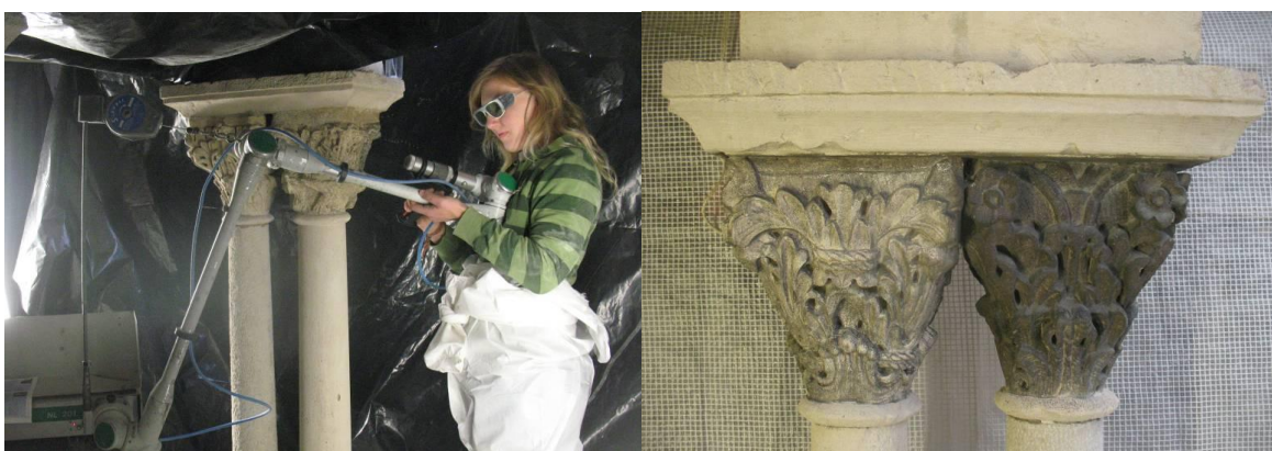
Obrázek č. XXXV, Čištění vápencových hlavic v exteriéru. Šárka Voláková, Atelier Jean Loup Bouvier, klášter Saint-André du bas, Vienne Francie. Vpravo: srovnání výsledku před a po čištění laserem.
