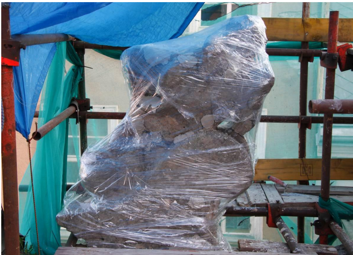
Obr. 8) Zábál, Arbocel a destilovaná voda
