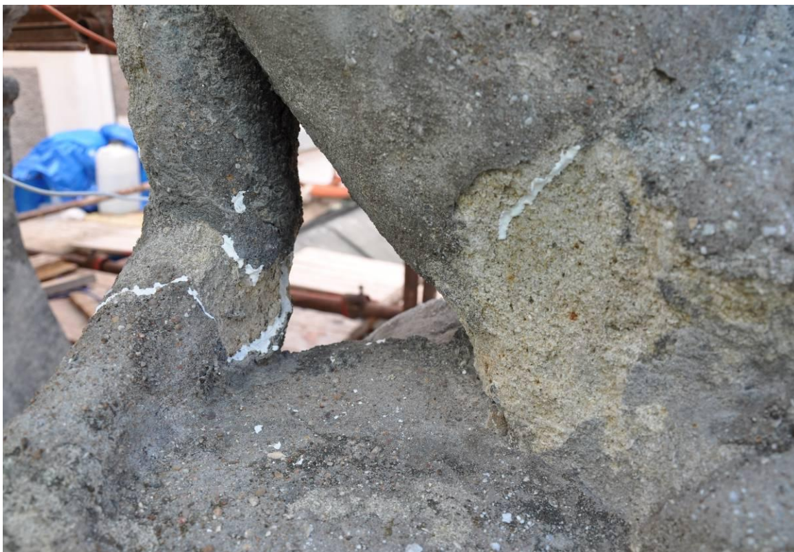
Obr. 14) Injektáž a zajištění okraje starých tmel, detail břicha
