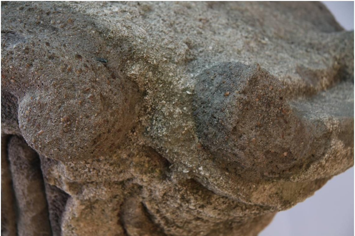
Obr. 39) Stav vázy před restaurováním tmely s vyčnívající měděnou armaturou
