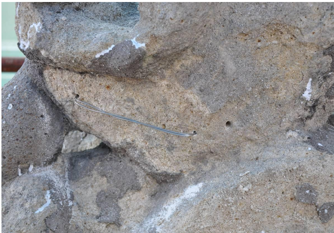
Obr. 12) Detail zadní části vložení armatury z nerezové oceli
