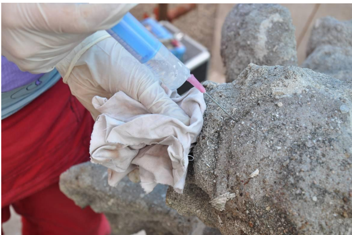
Obr. 9) Injektáž organokřemičitanem
