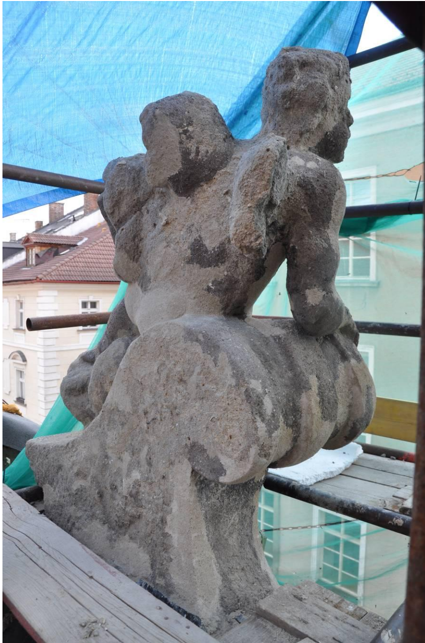
Obr. 16) Celkový rozsah plastické retuše – pohled zezadu
