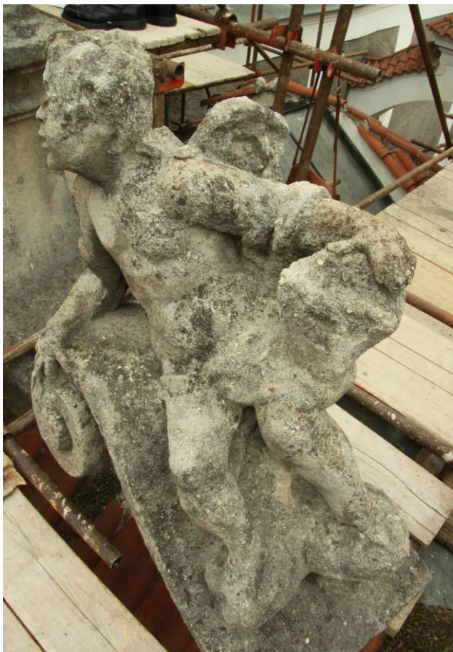
Obr. 19) Celkový rozsah plastické retuše – pohled shora
