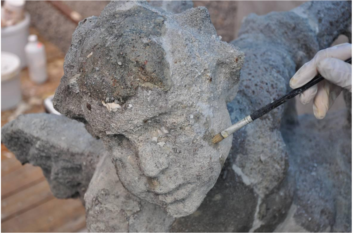
Obr. 28) Retuš, scelení několika rozdílných povrchů lazurním vápenným nátěrem
