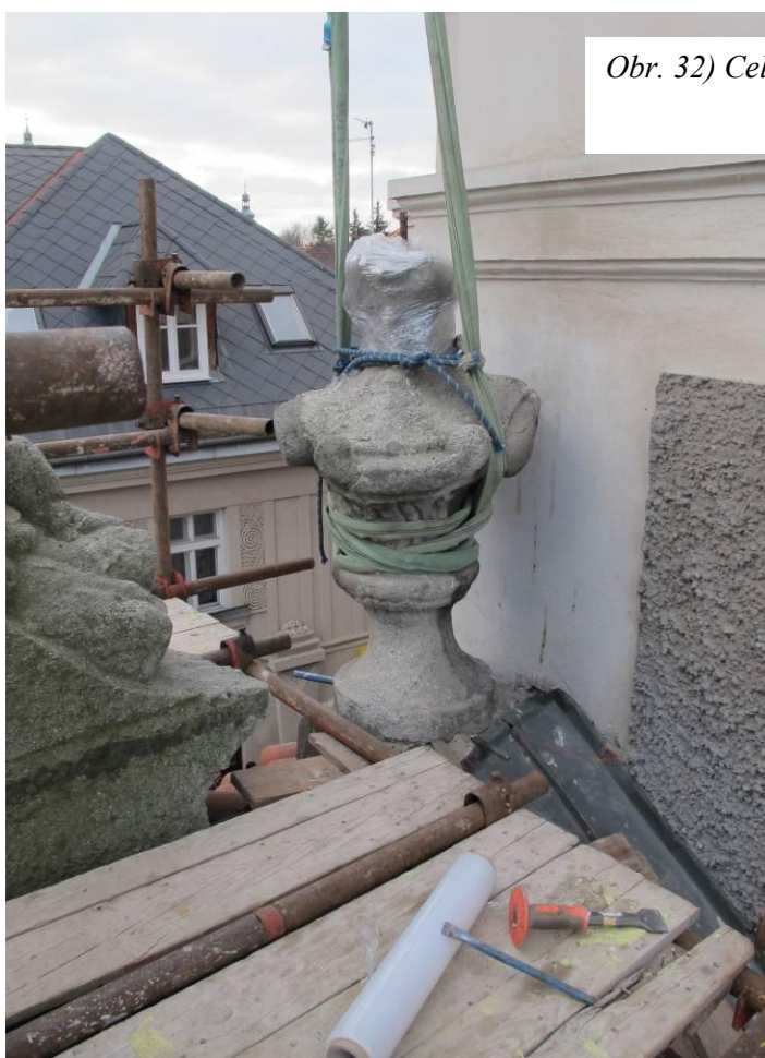
Obr. 33) Demontáž vázy pro převoz do ateliéru školy
