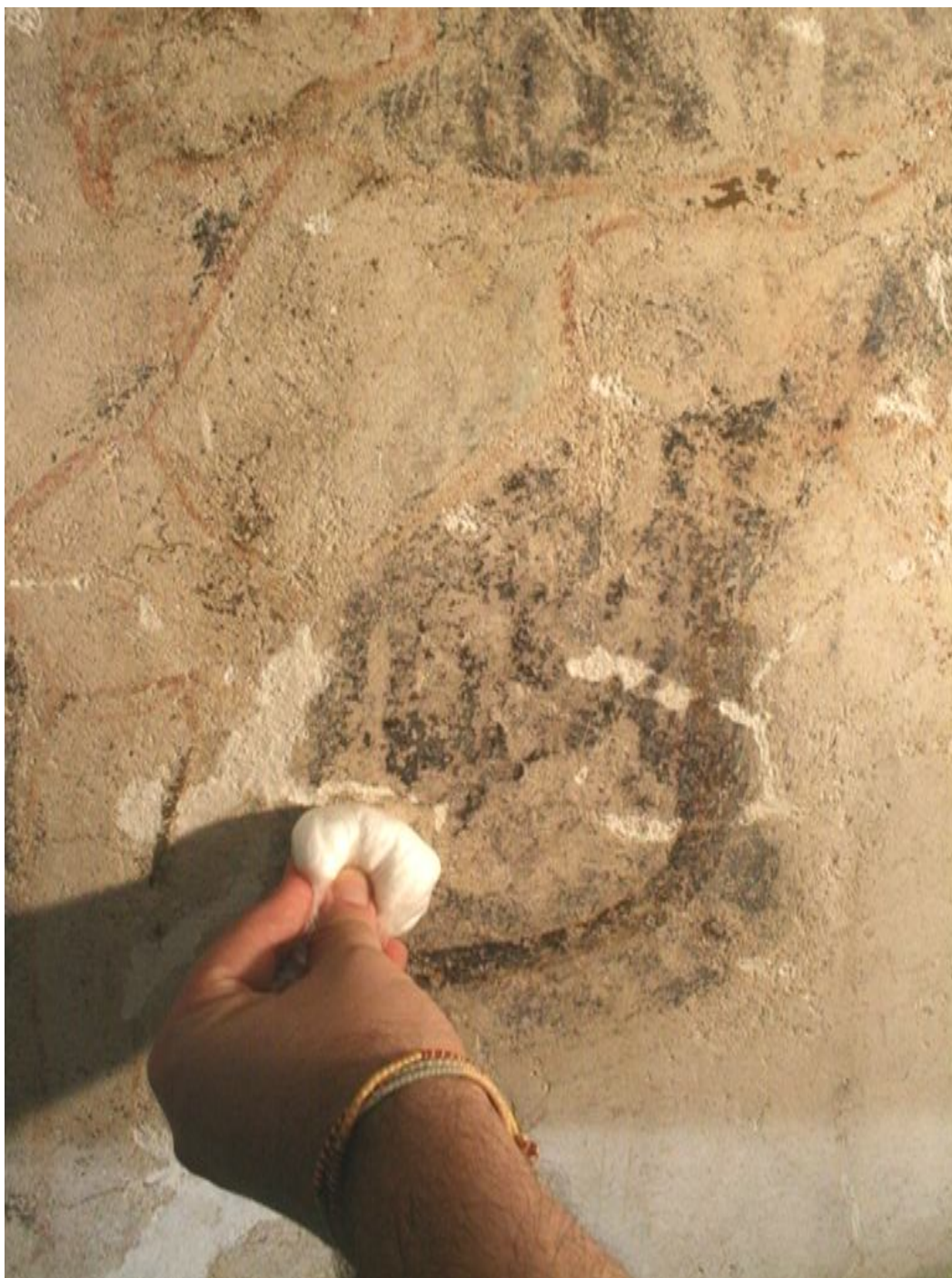
obr. 12, Loukov, kostel sv. Markéty, vítězný oblouk, Boj sv. Jiří s drakem , plošná konsolidace barevné vrstvy malby, přitažení uvolněné barevné vrstvy tampónem
