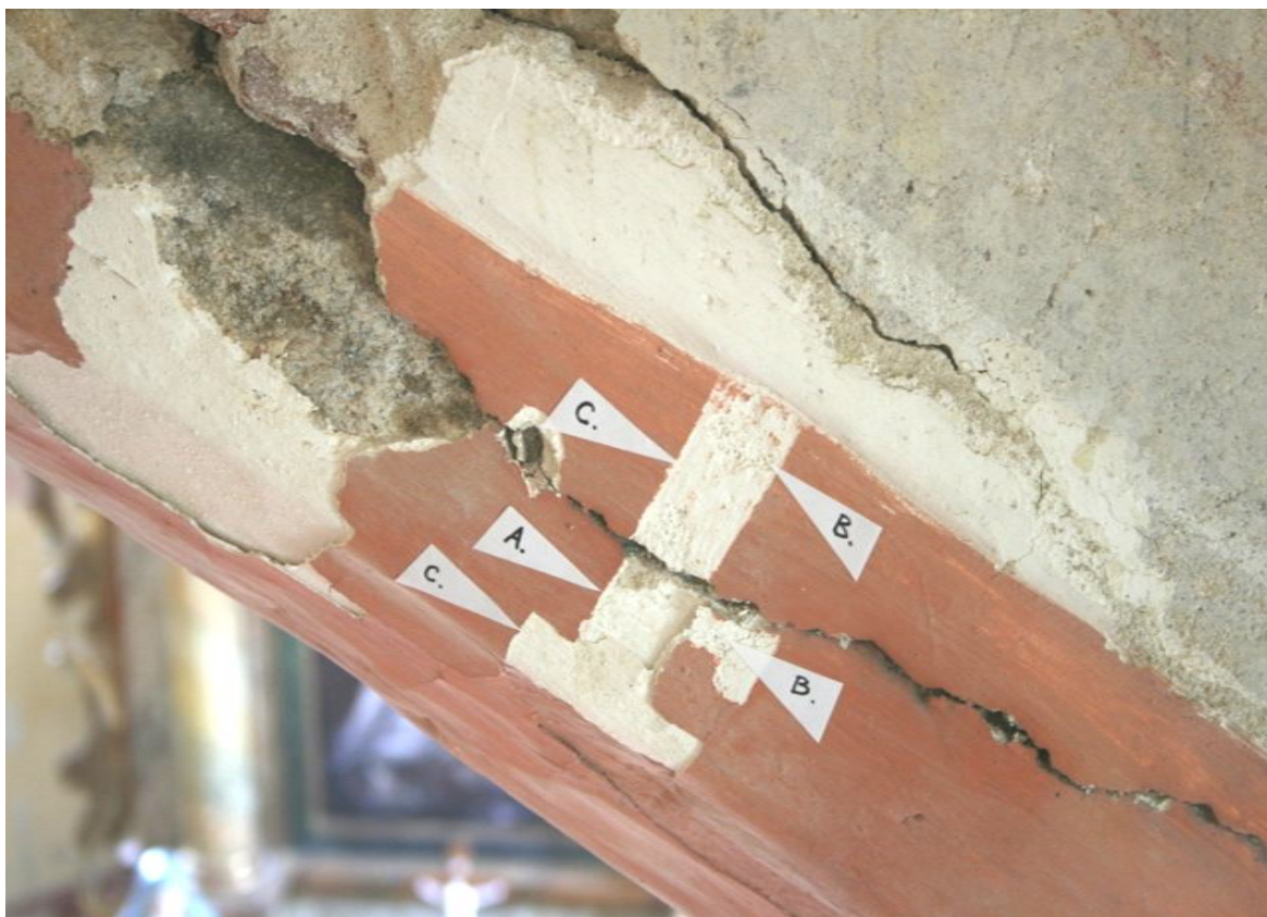
obr. 21, Loukov, kostel sv. Markéty, vítězný oblouk, Boj sv. Jiří s drakem , sonda identifikovala stratigrafii nejstarších vápenných nátěrů ve vrstvě C.
