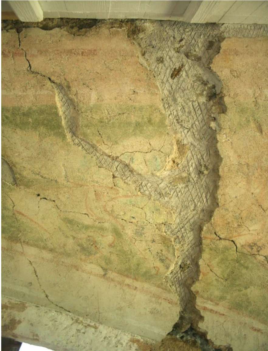
obr. 17, Loukov, kostel sv. Markéty, vítězný oblouk, Boj sv. Jiří s drakem , hloubkové tmelení – plentování žulovými kameny a vápenným tmelem
