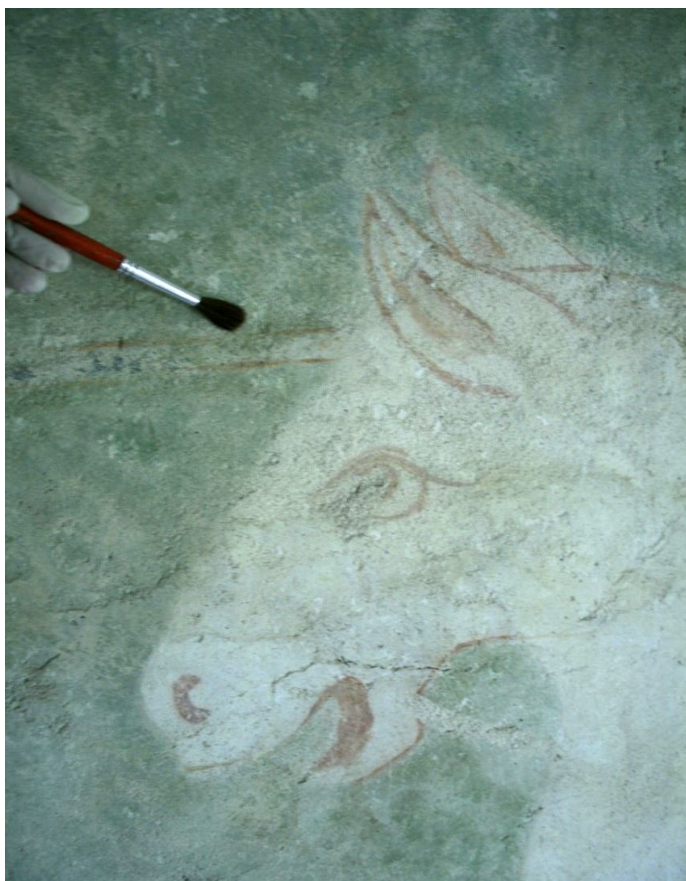
obr. 6, Loukov, kostel sv. Markéty, vítězný oblouk, Boj sv. Jiří s drakem , odstranění prachového depozitu a povrchových nečistot vlasovým štětcem
