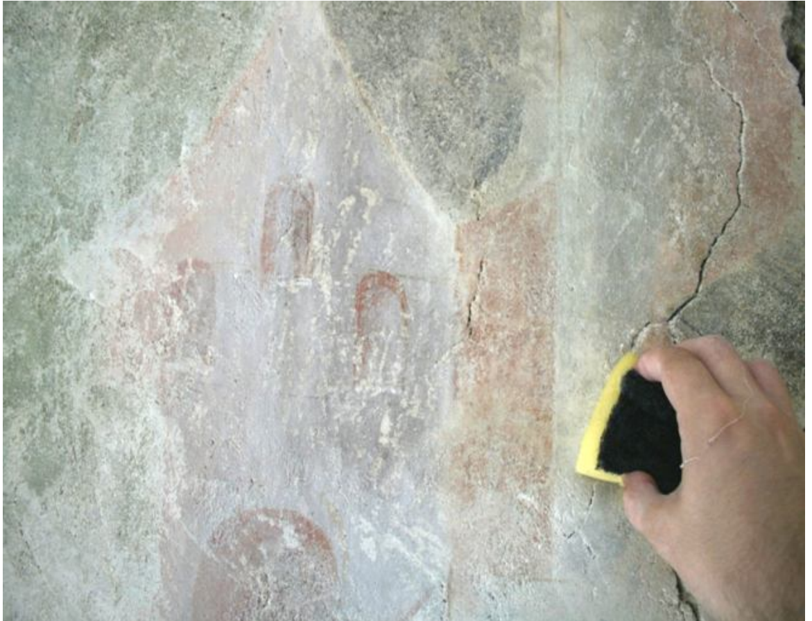
obr. 27, Loukov, kostel sv. Markéty, vítězný oblouk, Boj sv. Jiří s drakem , povrchové dočištění destilovanou vodou
