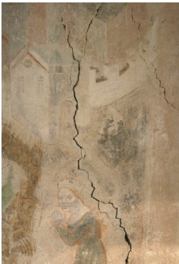
obr. 4, Loukov, kostel sv. Markéty, vítězný oblouk, Boj sv. Jiří s drakem , čištění trhlin a postupné odstranění druhotných vysprávek
