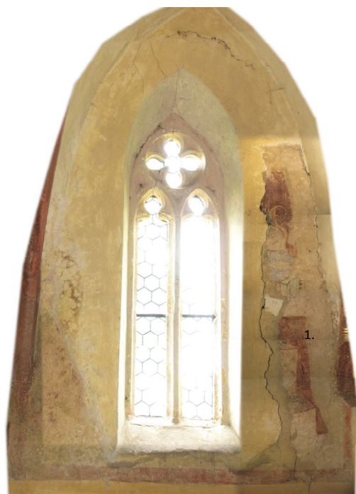
obr. 3, Loukov, kostel sv. Markéty (interiér): severovýchodní stěna závěru presbyteria Ikonomografický popis: 1. fragmenty cyklu Legendy o sv. Markétě poškození v důsledku druhotně vsazeného gotického okna
