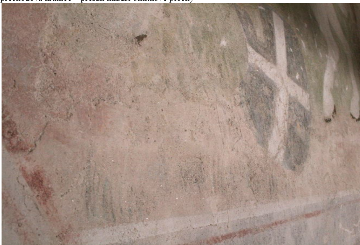
obr. 20, Loukov, kostel sv. Markéty, vítězný oblouk, Boj sv. Jiří s drakem , pontato – přechodové hranice – přesah mladší omítkové plochy (detail)
