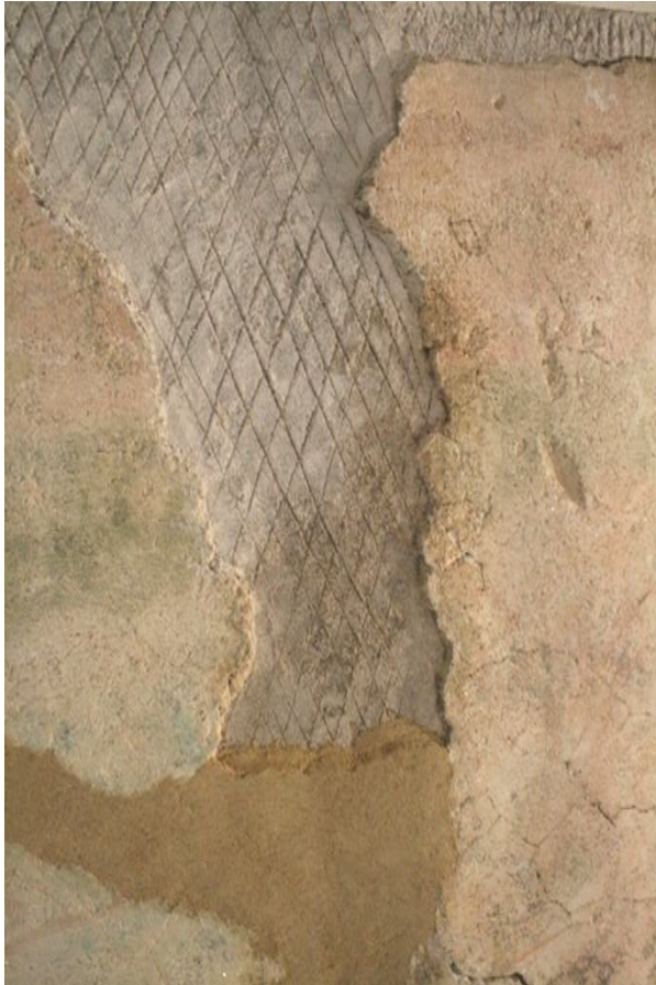
obr. 20, Loukov, kostel sv. Markéty, vítězný oblouk, Boj sv. Jiří s drakem , jemné tmelení vápenným tmelem
