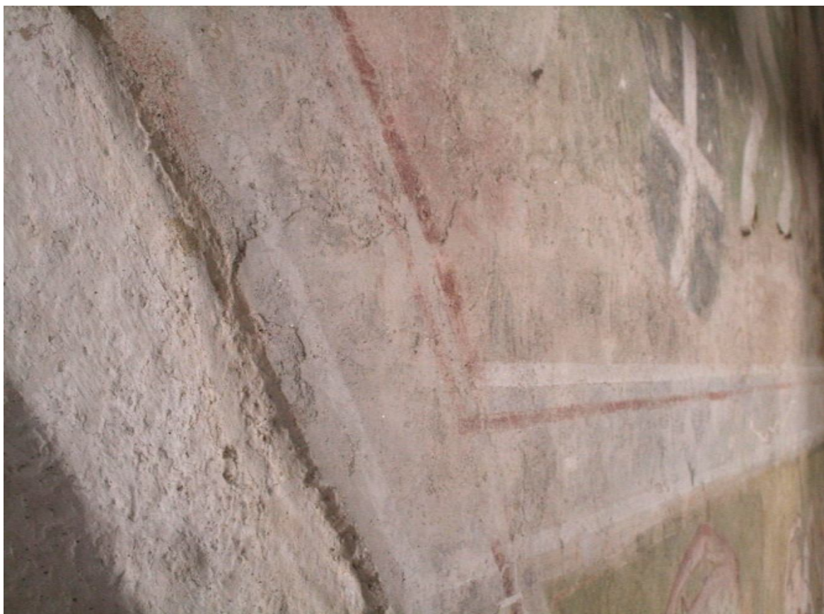
obr. 19, Loukov, kostel sv. Markéty, vítězný oblouk, Boj sv. Jiří s drakem , pontato – přechodová hranice – přesah mladší omítkové plochy
