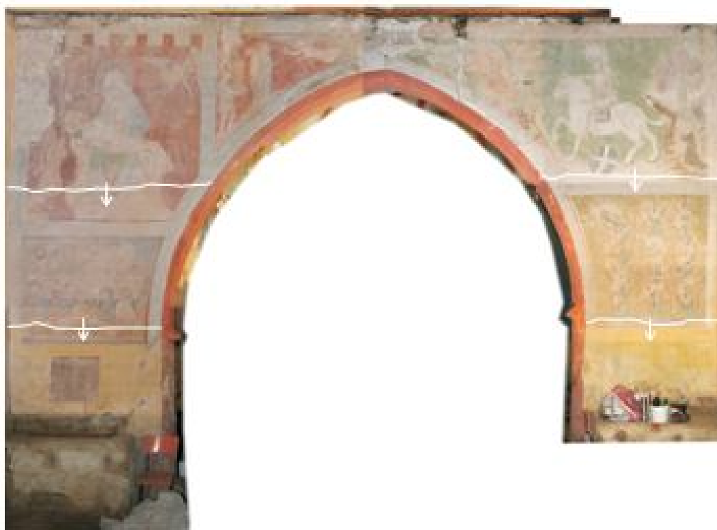
obr. 2, Loukov, kostel sv. Markéty, východní stěna lodi, nástěnná malba (1390) pointata - zakreslení hranic, šipky směřují ze starších omítkových ploch směrem do mladších
