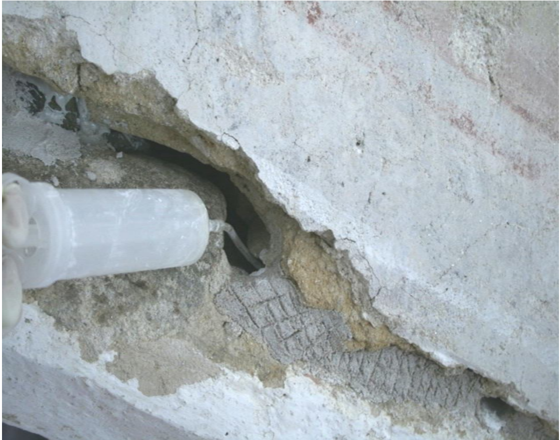
obr. 13, kostel sv. Markéty, vítězný oblouk, Boj sv. Jiří s drakem , hloubková injektáž trhlín Ledanem D2
