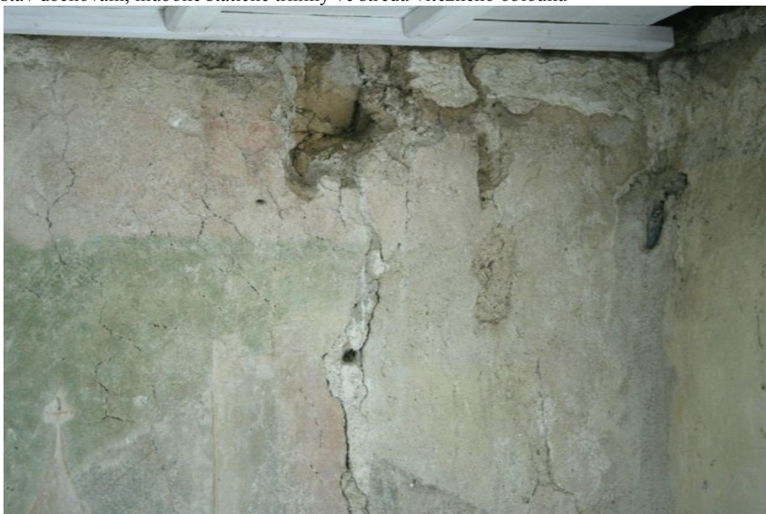
obr. 17, Loukov, kostel sv. Markéty, vítězný oblouk, Boj sv. Jiří s drakem , stav dochování, hluboké statické trhliny, degradace horního okraje malby na podklad
