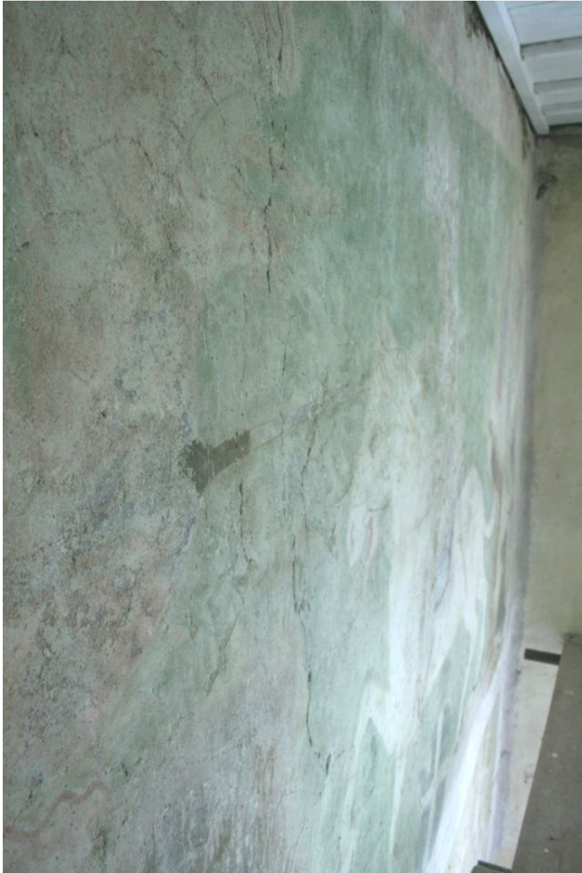
obr. 18, Loukov, kostel sv. Markéty, vítězný oblouk, Boj sv. Jiří s drakem , stav dochování před restaurováním, struktura povrchu nástěnné malby
