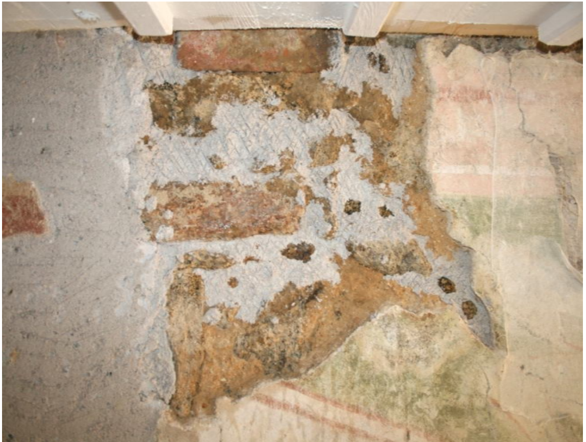
obr. 16, Loukov, kostel sv. Markéty, vítězný oblouk, Boj sv. Jiří s drakem , hloubkové tmelení – plentování žulovými kameny a vápenným tmelem
