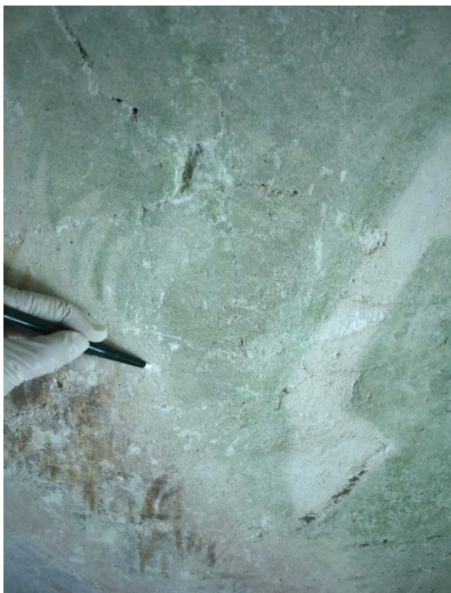
obr. 25, Loukov, kostel sv. Markéty, vítězný oblouk, Boj sv. Jiří s drakem , zkouška odstranění zbytků druhotných vápenných nátěrů pomocí skelného vlákna
