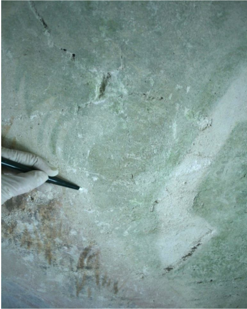
obr. 8, Loukov, kostel sv. Markéty, vítězný oblouk, Boj sv. Jiří s drakem , odstranění zbytků druhotných vápenných nátěrů pomocí skelného vlákna
