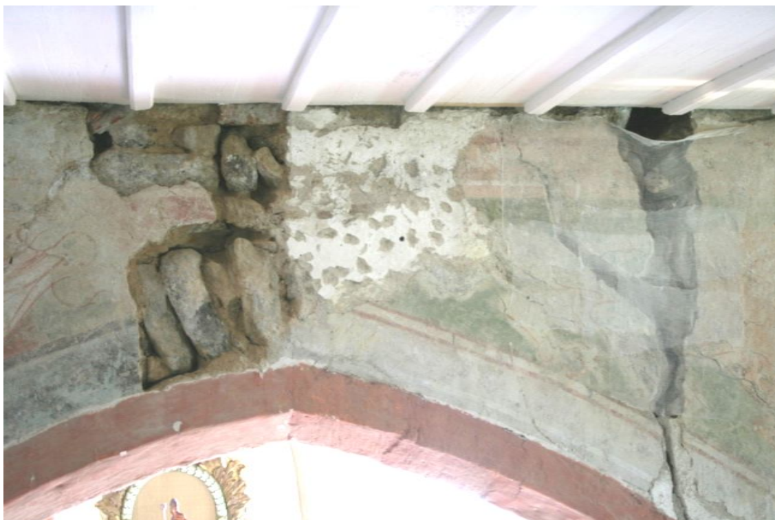
obr. 2, Loukov, kostel sv. Markéty, vítězný oblouk, Boj sv. Jiří s drakem , zajištění trhlin gázovými přeplepy a postupné odstranění druhotných vysprávek
