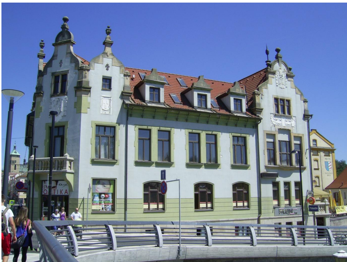
Obr. č. 9 Bývalý Okresní dům č. p. 227 z pohledu od řeky Sázavy (foto autor)
