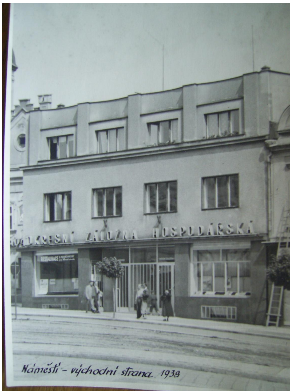
Obr. č. 24 Budova Okresní hospodářské záložny č. p. 168 v roce 1938 (SOkA Havlíčkův Brod, Sběrka fotografií, karton 4, foto 48, reprofoto autor)
