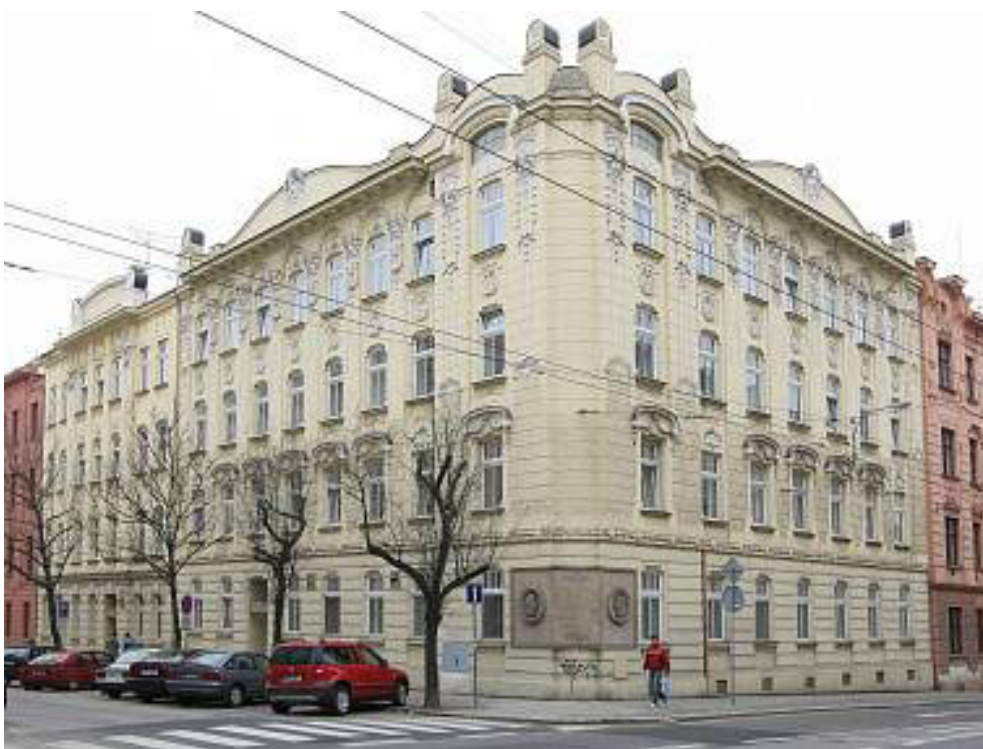
Obr. 2: Budova Útulny ženské, Falkensteinerova ulice č. 35 – nyní ulice Gorkého 440
