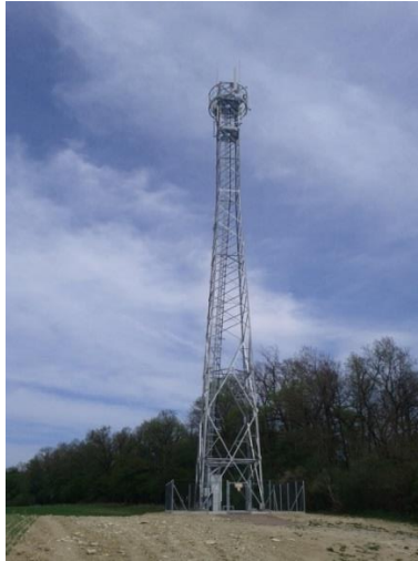
Obrázek 19: Základnová stanice Kunčičky
