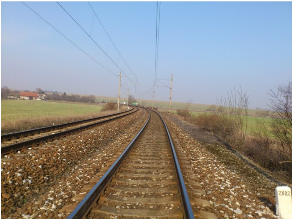
Úsek Čáslav – Třebešice – složené směrové kružnicové oblouky s krajními přechodnicemi
