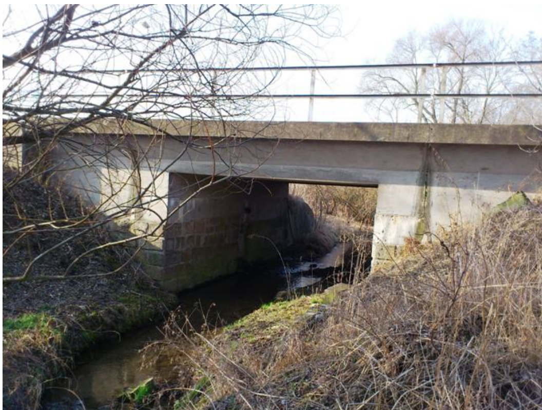
Železobetonový most v zastávce Třebešice v km 283,137
