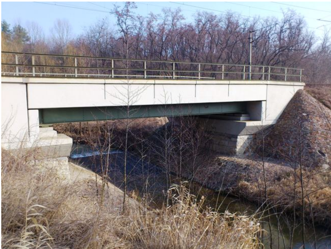
Úsek Čáslav – Třebešice – sprážený železobetonový most v km 276,621
