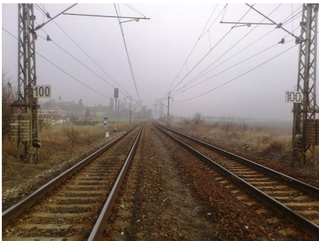
Úsek Golčův Jeníkov – Horky u Čáslavi – směrové oblouky R1 = 2\,580 m, R2 = 2\,495 m
