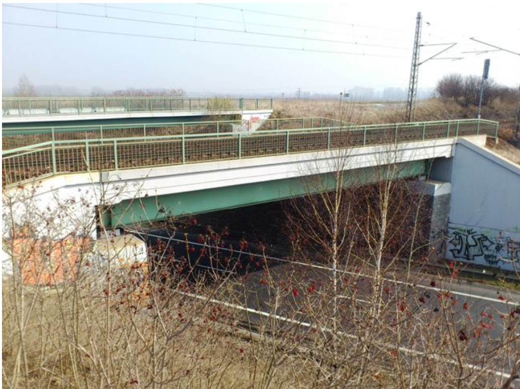
Úsek Horky u Čáslavi – Čáslav – sprážený železobetonový most v km 276,621
