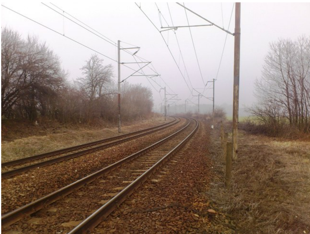
Úsek Golčův Jeníkov – Horky u Čáslavi – směrové oblouky R1 = 585 m, R2 = 589 m
