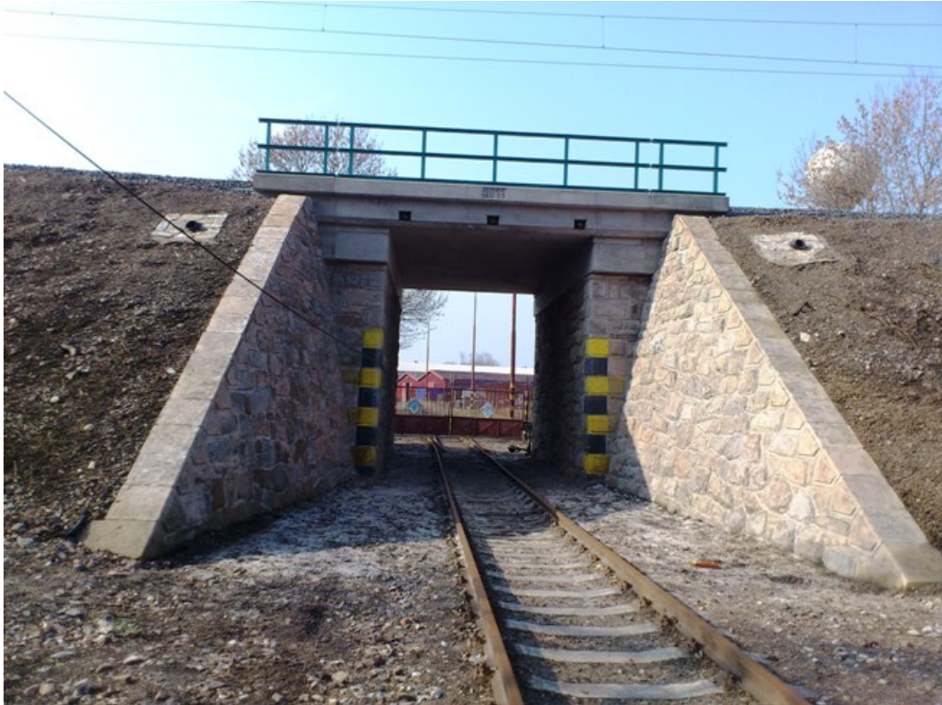
Úsek Čáslav – Třebešice – železobetonový most v km 279,081
