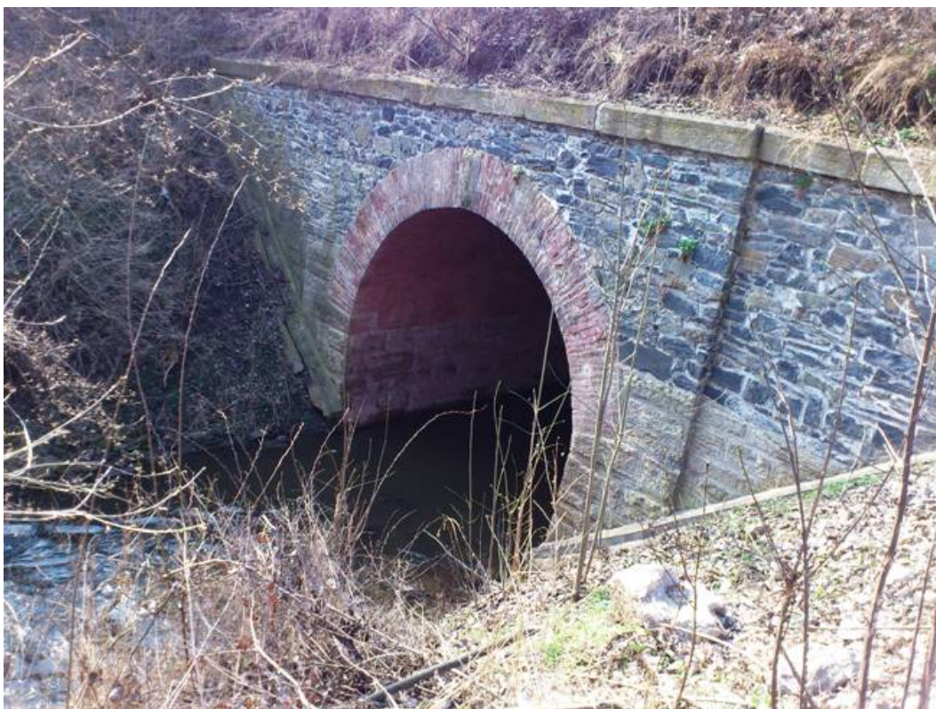
Úsek Čáslav – Třebešice – klenbový most v km 279,057
