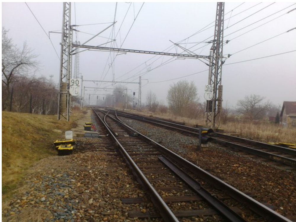
Začátek rekonstruovaného úseku, železniční stanice Golčův Jeníkov
