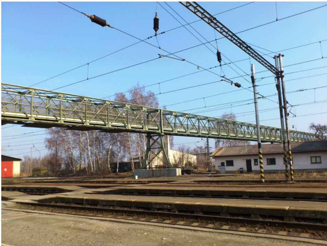
Příhradová lávka pro pěší v železniční stanici Čáslav
