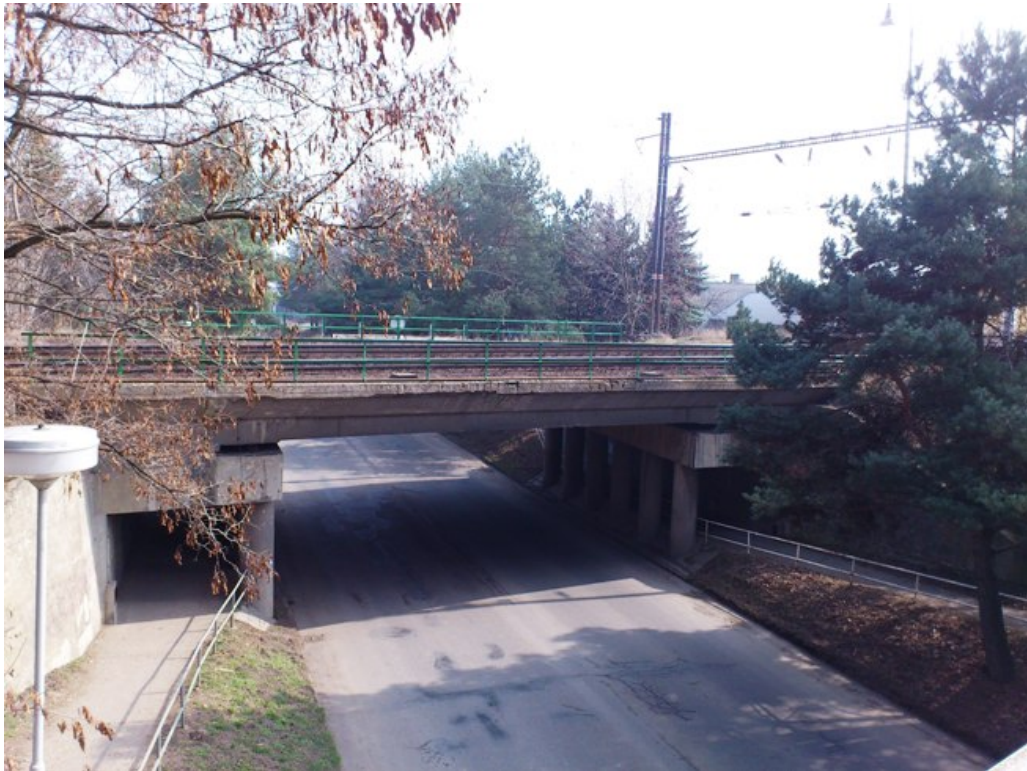
Čáslav – železobetonový most v km 276,621
