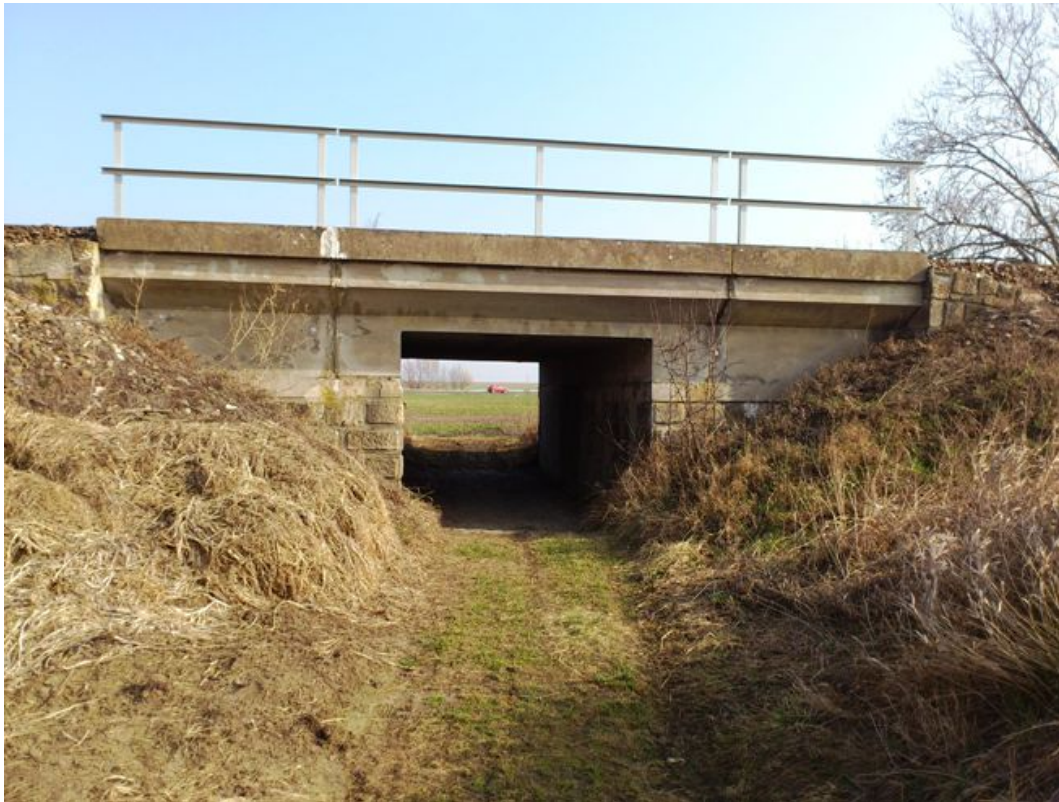
Úsek Čáslav – Třebešice – železobetonový most v km 280,464
