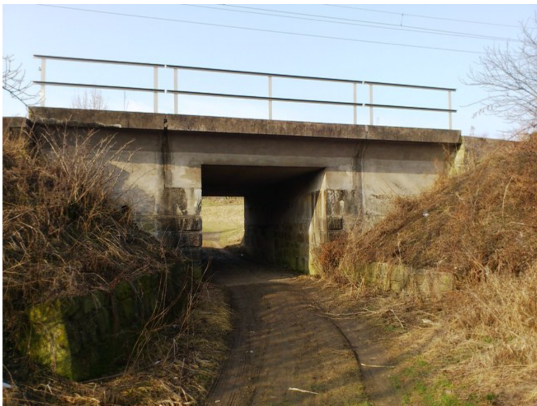
Úsek Čáslav – Třebešice –železobetonový most v km 282,907
