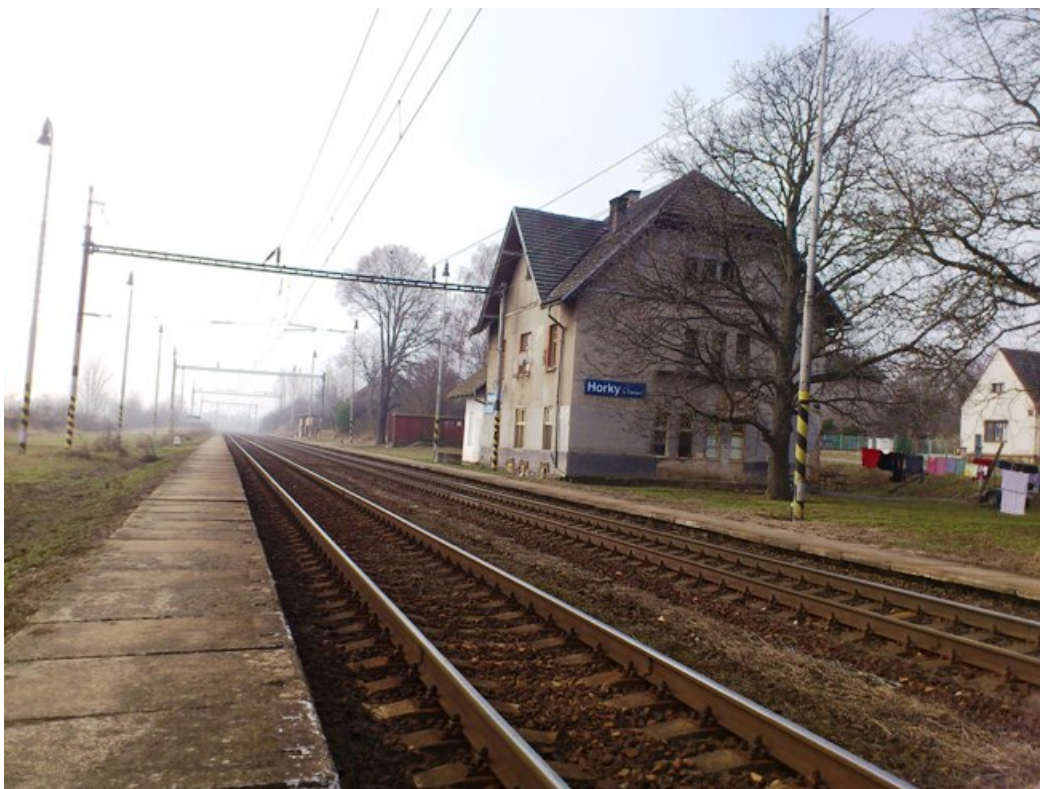
Železniční zastávka Horky u Čáslavi – výpravní budova
