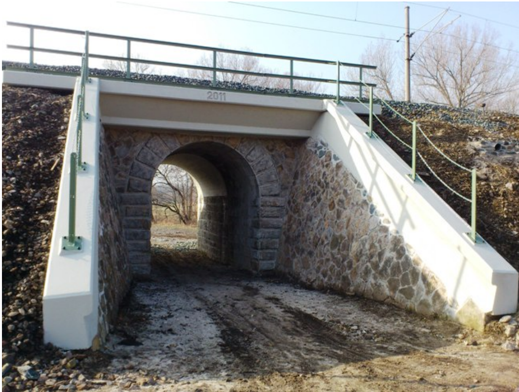
Úsek Čáslav – Třebešice – kamenný klenbový most v km 281,975
