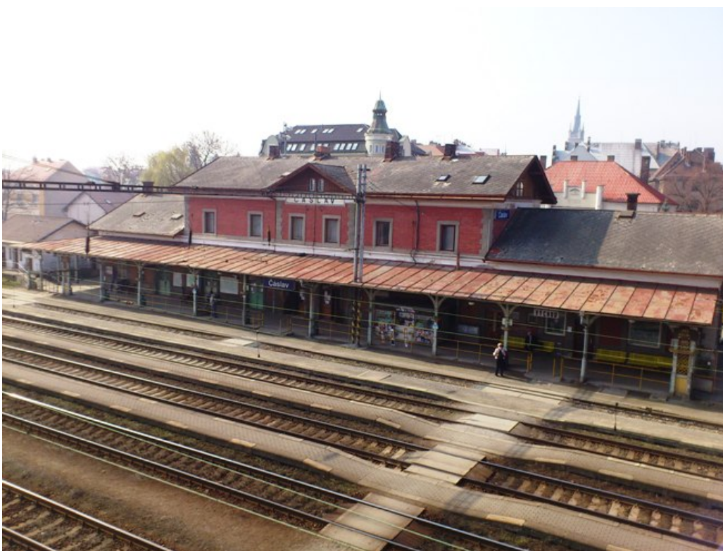
Železniční stanice Čáslav – výpravní budova
