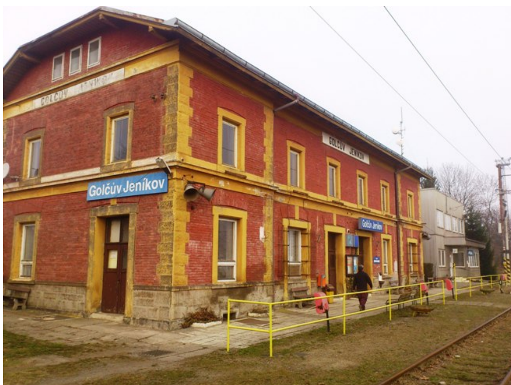
Železniční stanice Golčův Jeníkov – výpravní budova
