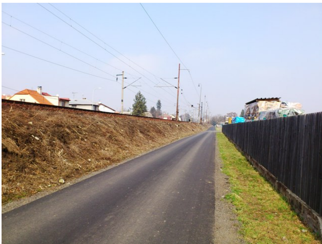
Násyp v přímé trati před železniční stanicí Čáslav
