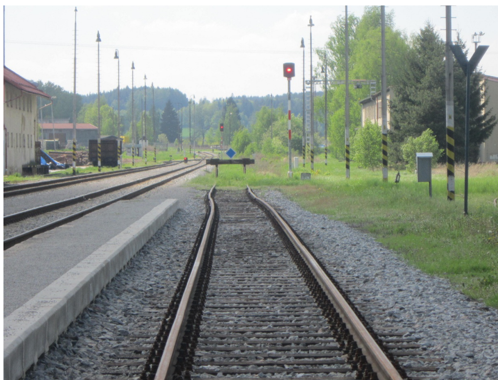
Dopravní kolej č. 4
