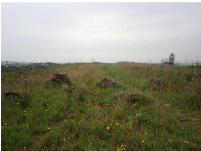
Obrázek č. 44 - Kameny, zamezující vjezdu na ekodukt
