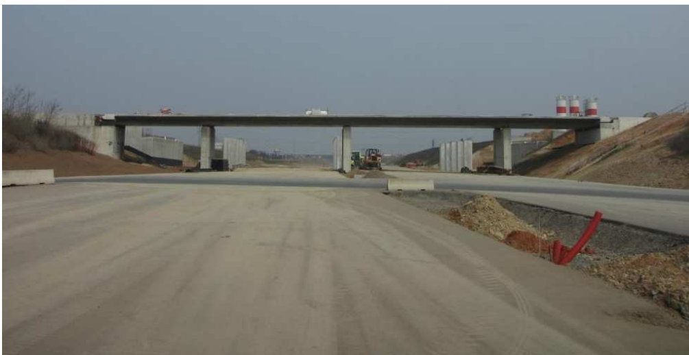
Obrázek č. 41 - Ekodukt Lochkov během výstavby [25]
