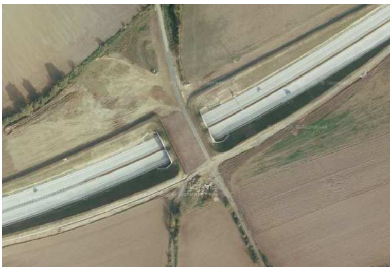
Obrázek č. 57 - Letecký pohled na ekodukt Osnice [21]
