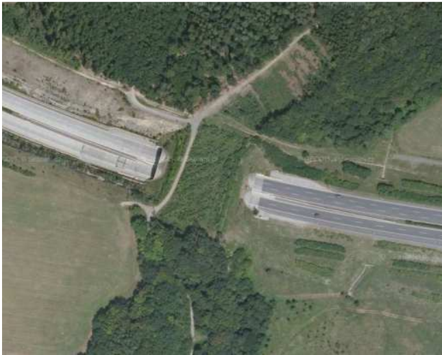
Obrázek č. 29 - Letecký pohled na ekodukt Dolní Újezd [21]
