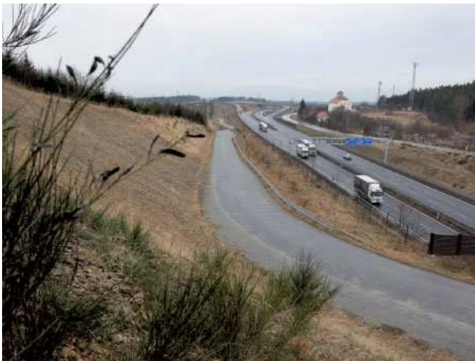
Obrázek č. 20 - Jižní část ekoduktu Nová Hospoda [24]
