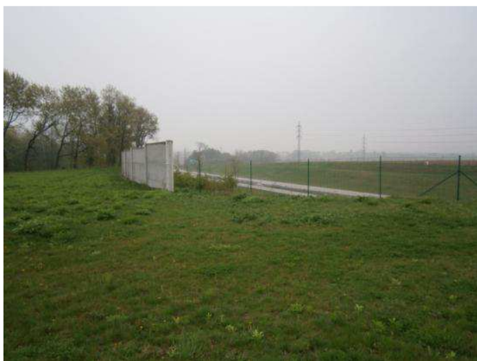
Obrázek č. 35 - Severní vchod do ekoduktu Hrabůvka s protihlukovou stěnou
