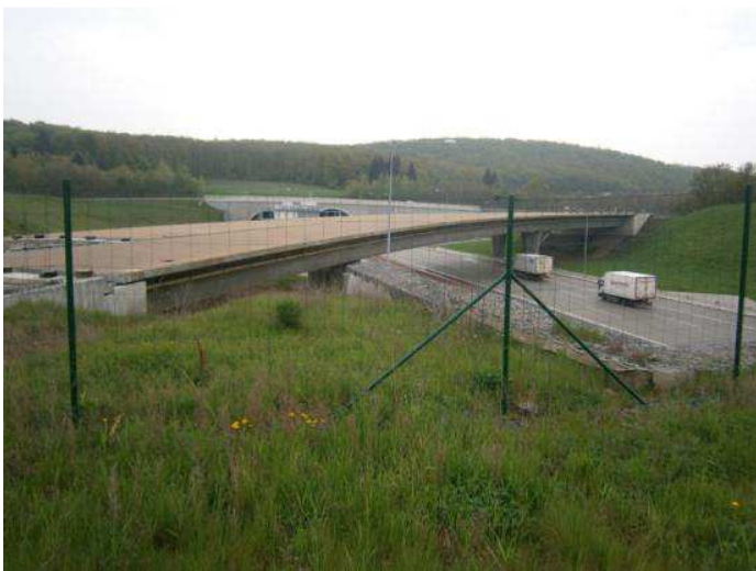
Obrázek č. 46 - Most ve výstavbě, v těsné blízkosti s ekoduktem Šabatka
