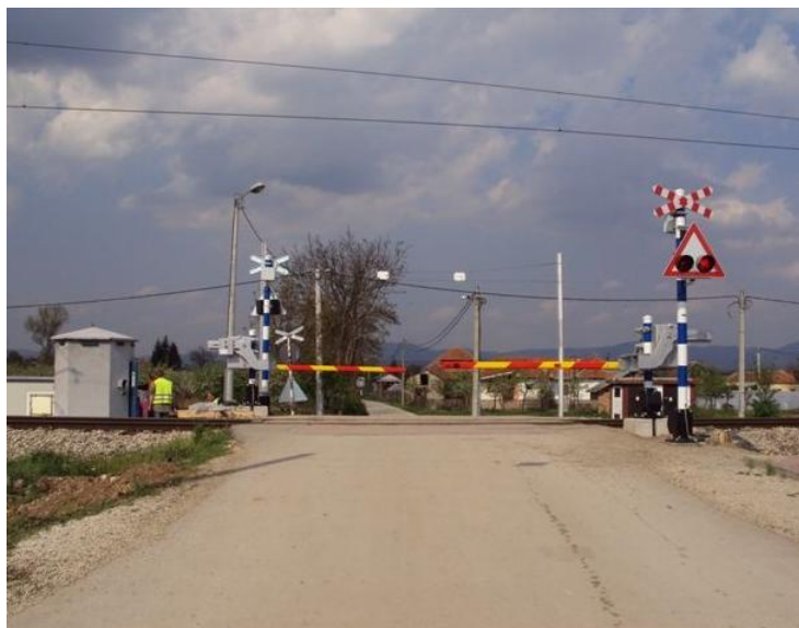
Obrázek 5-1 Železniční přejezd Atenica
