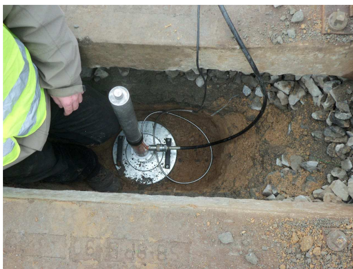
obr. 8 Umístění zatěžovací desky při zkoušce č. 2
