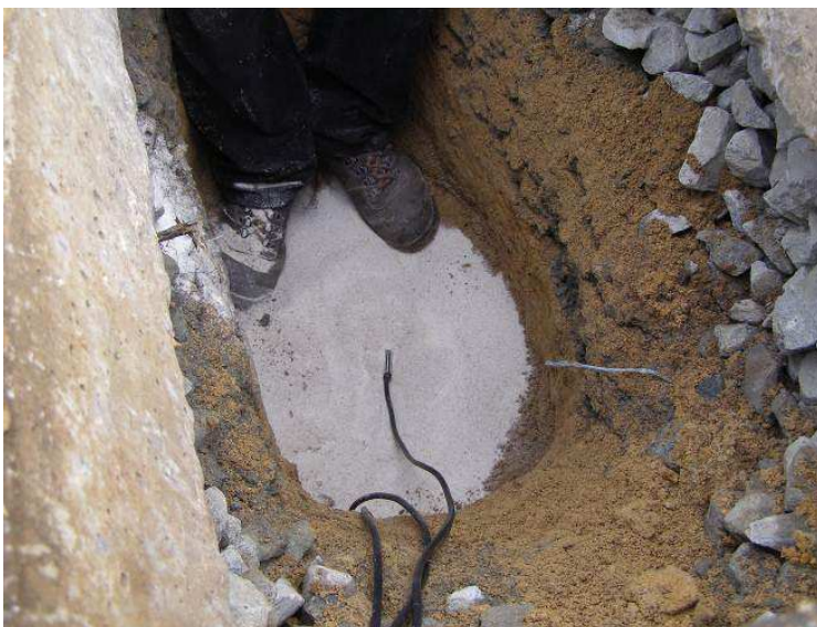
obr. 25 Ukládání snímačů
