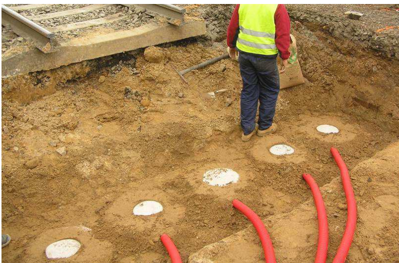
obr. 21 Osazování snímačů tlaku
