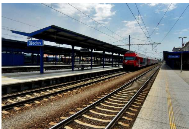
Obr. 9 Břeclav, rekonstruovaná nástupiště
