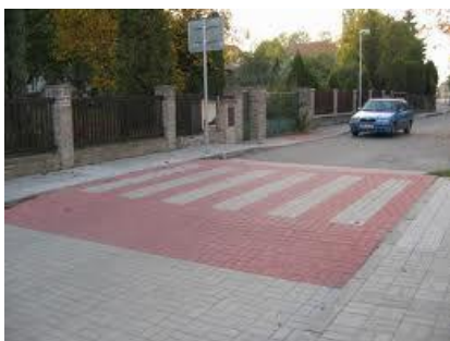
Obrázek 26 Zpomalovací prah s přechodem
