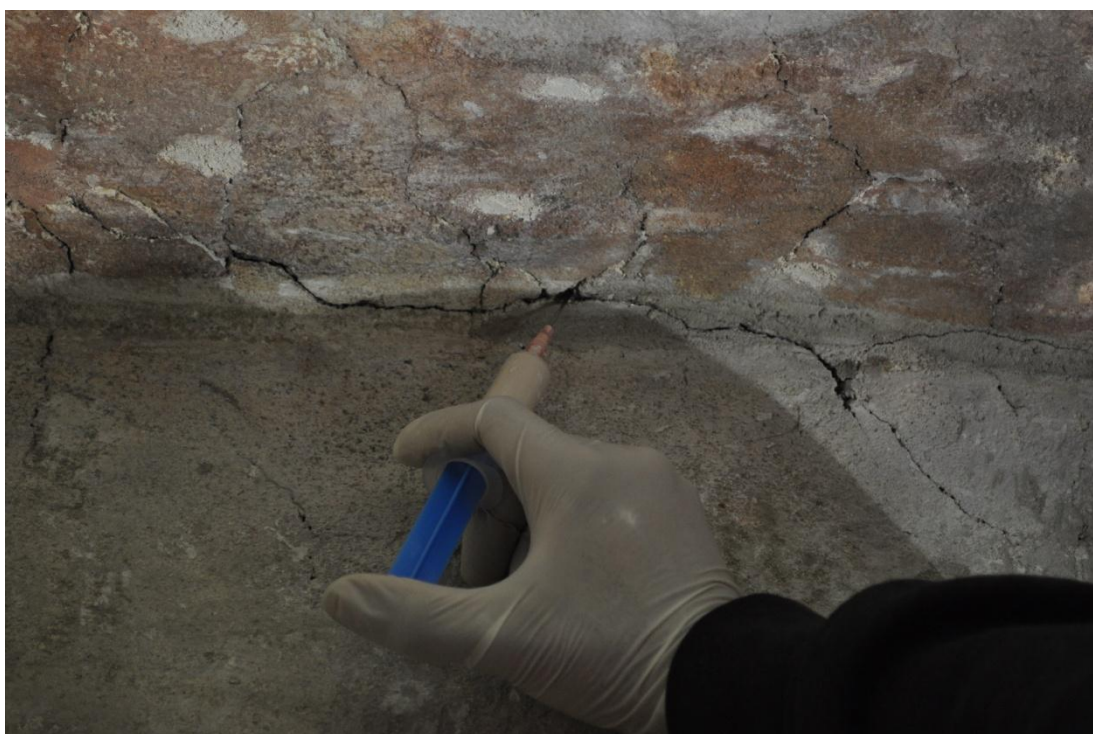
Obrázek 16 – Referenční plocha nástěnné malby (Ja). Realizace hloubkové konsolidace omítkových vrstev v části čelního oblouku
