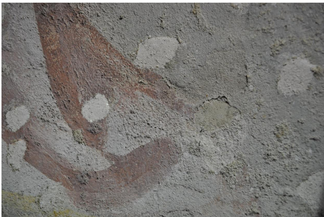
Obrázek 21 – Referenční plocha nástěnné malby (Ja). Detail vytmelených ploch, stav v průběhu aplikace maltové směsi
