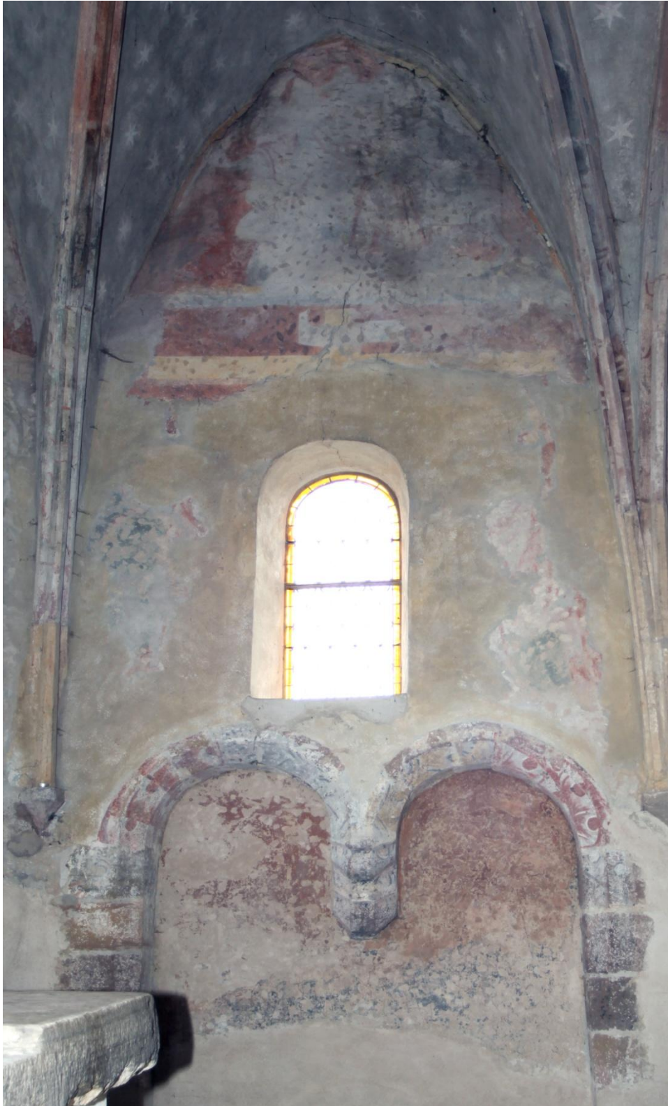
Obrázek 2 – Jižní stěna presbytáře (Jb), stávající stav
