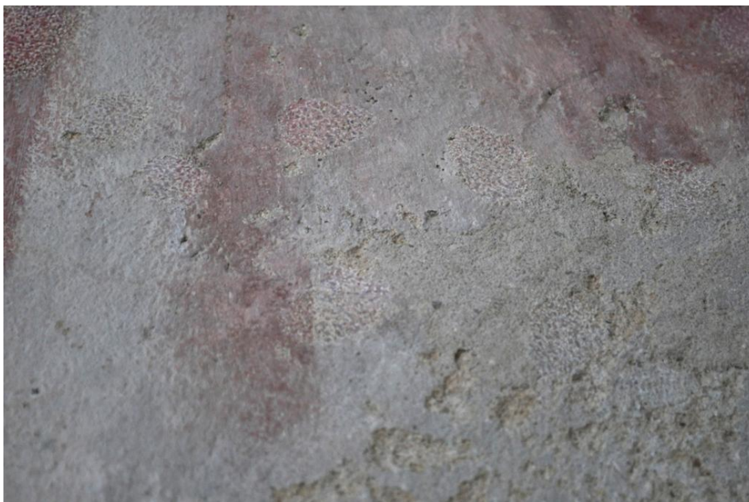
Obrázek 34 – Spodní partie referenční plochy, stav po barevné reintegraci tmelů
