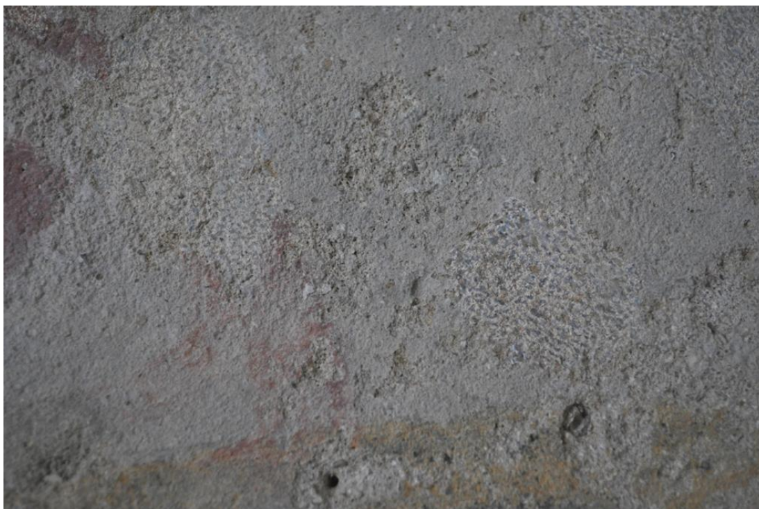
Obrázek 33 – Spodní partie referenční plochy, stav po barevné reintegraci tmelů
