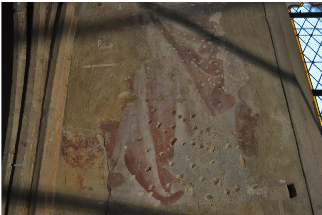
Obrázek 18 – Referenční plocha nástěnné malby (Ja). Dokumentace postupu prací při odstraňování defektů, jejich konsolidaci a následném vytmelení
