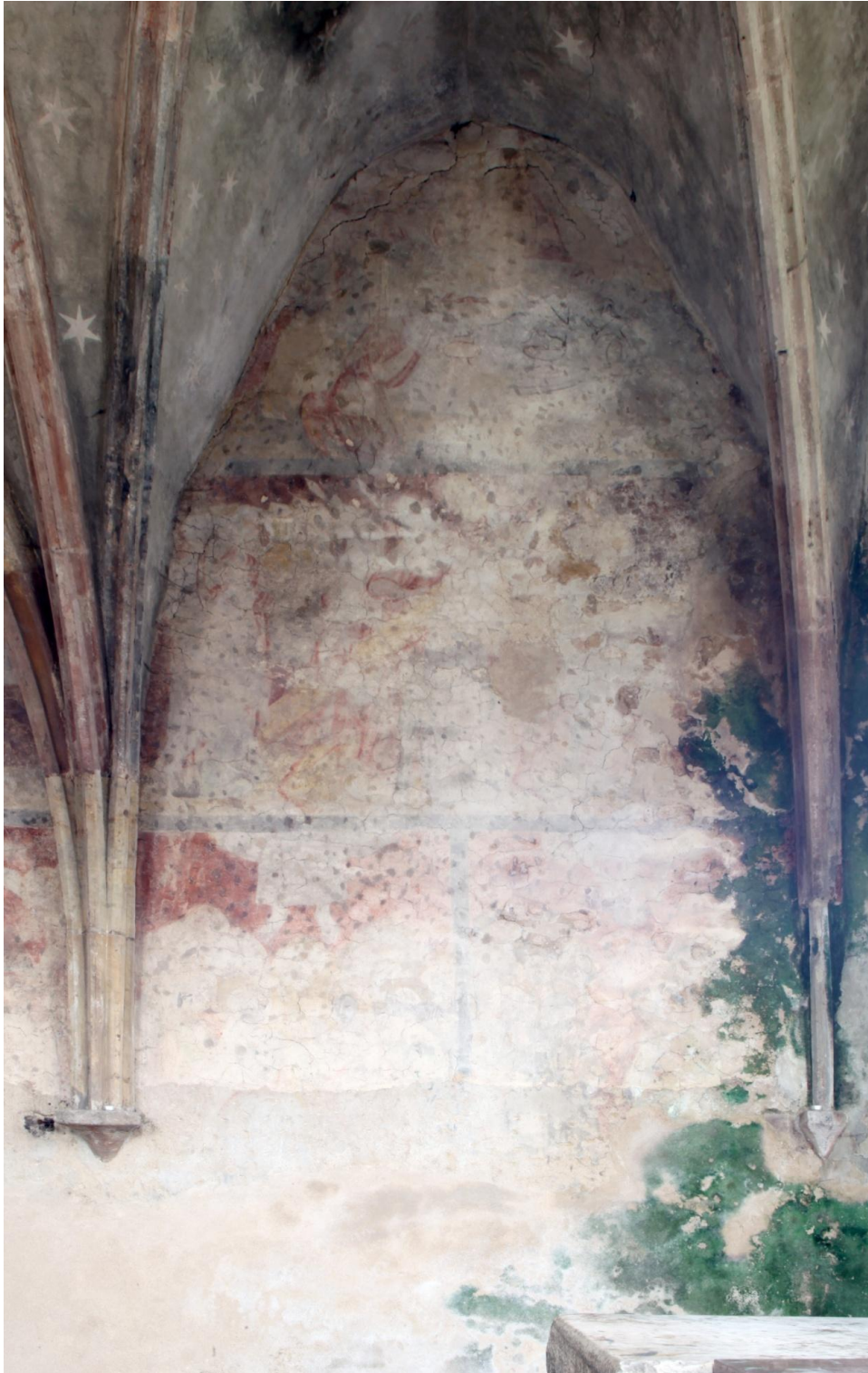
Obrázek 6 – Severní stěna presbytáře (Sb), stávající stav
