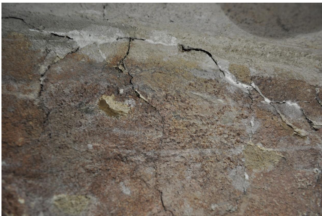
Obrázek 17 – Referenční plocha nástěnné malby (Ja). Realizace hloubkové konsolidace omítkových vrstev v části čelního oblouku, stav po dokončení
