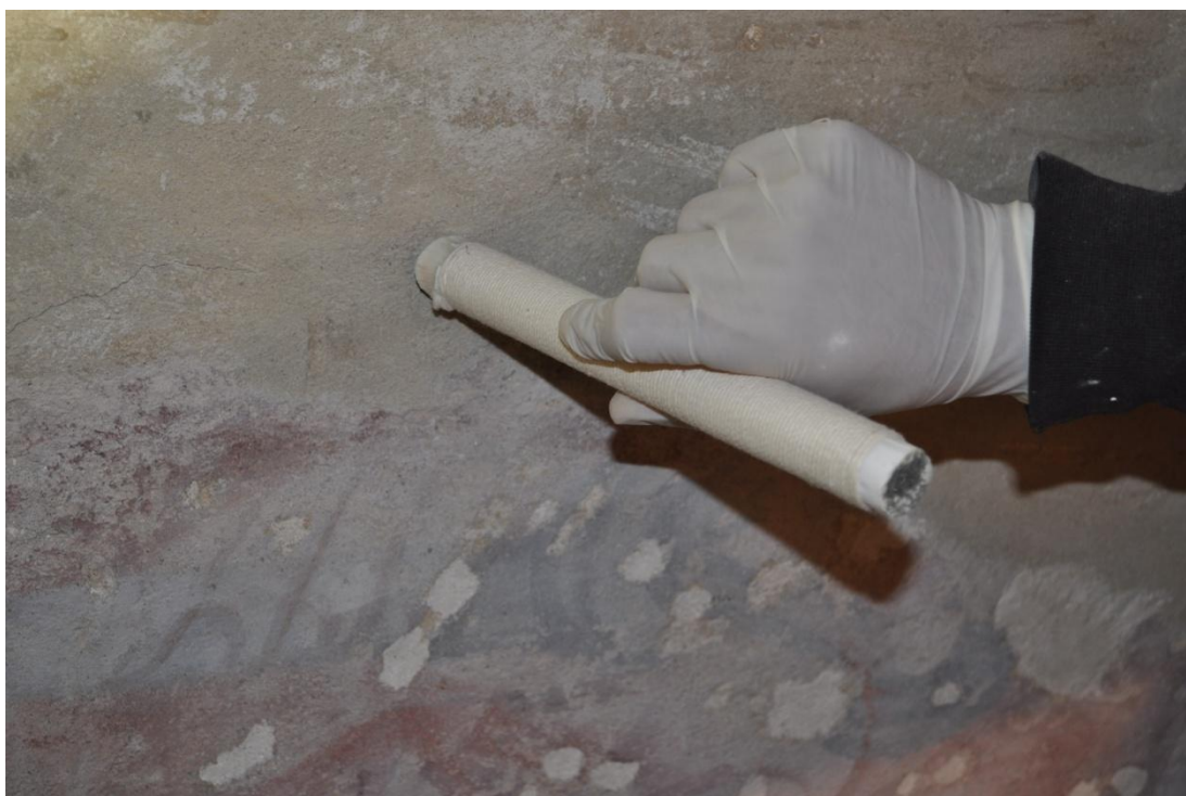
Obrázek 15 – Referenční plocha nástěnné malby (Ja), detail postavy sv. Petra. Zkouška a následná realizace dočištění pomocí skelných vláken
