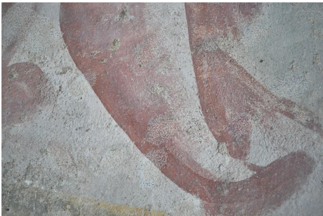
Obrázek 35 – Spodní partie referenční plochy, stav po barevné reintegraci tmelů
