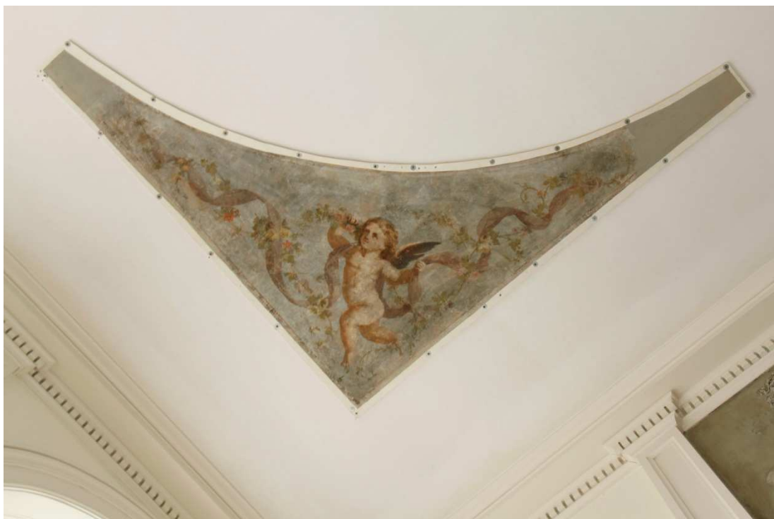
Obr. 136 „Tapeta č. 1“ po instalaci na původní místo.
