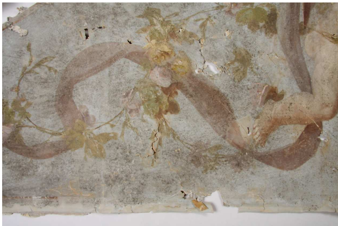
Obr. 50: Stav díla před restaurováním, detail poškození, denní rozptýlené světlo.
