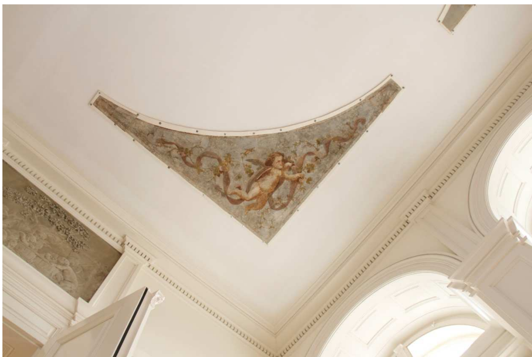
Obr. 137 „Tapeta č. 2“ po instalaci na původní místo.
