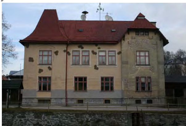
Obr. 37 Secesní budova radnice v Horním Maršově
