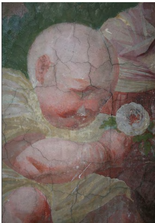
Obrázek č. 16: Původní trhliny v intonaku.
