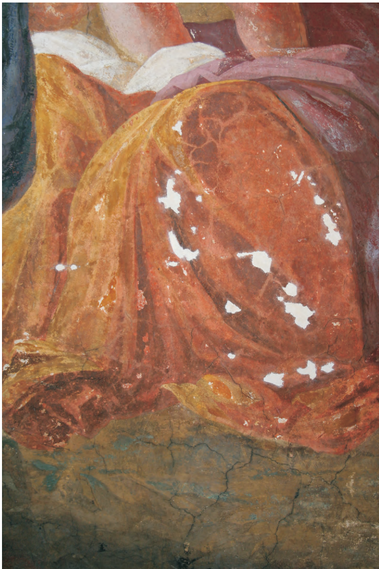
Obr. 52 Drobné defekty v intonaku v oblasti šatů Sárý - stav po vytmelení.
