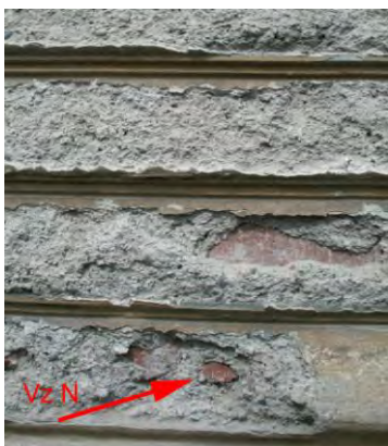
Obr. 41 Lokalizace odběru vzorku nezpevněné omítky VzN
