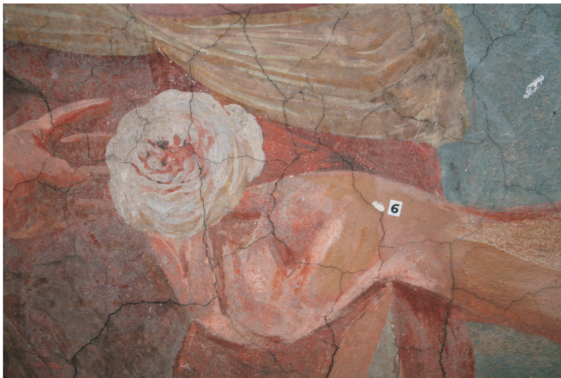
Obr. 13 Ruka ženy podávající Izákovi růži - detail vlasových trhlin, které vznikly při hem vysychání omítek - stav před restaurováním.
