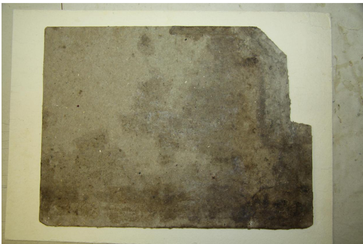
34. Začištění a vytučnění poškozené části desky
