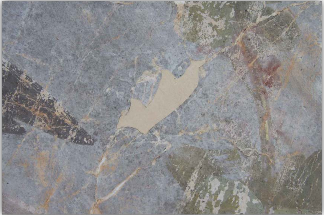
65. Obrázek: stav v průběhu restaurování; detail doplňků; snímáno v denním rozptýleném světle
