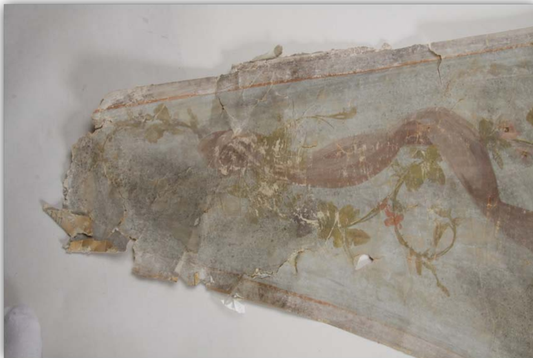
16. Obrázek: stav před restaurováním; detail poškození; snímáno v denním rozptýleném světle
