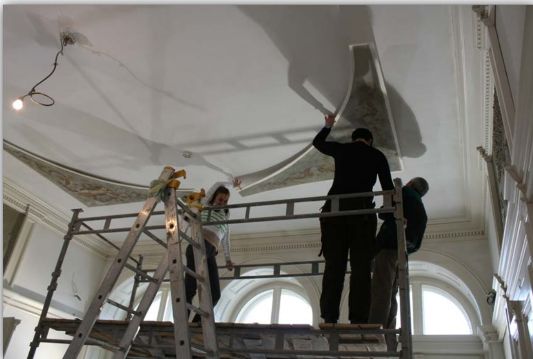
74.Obrázek: instalační práce
