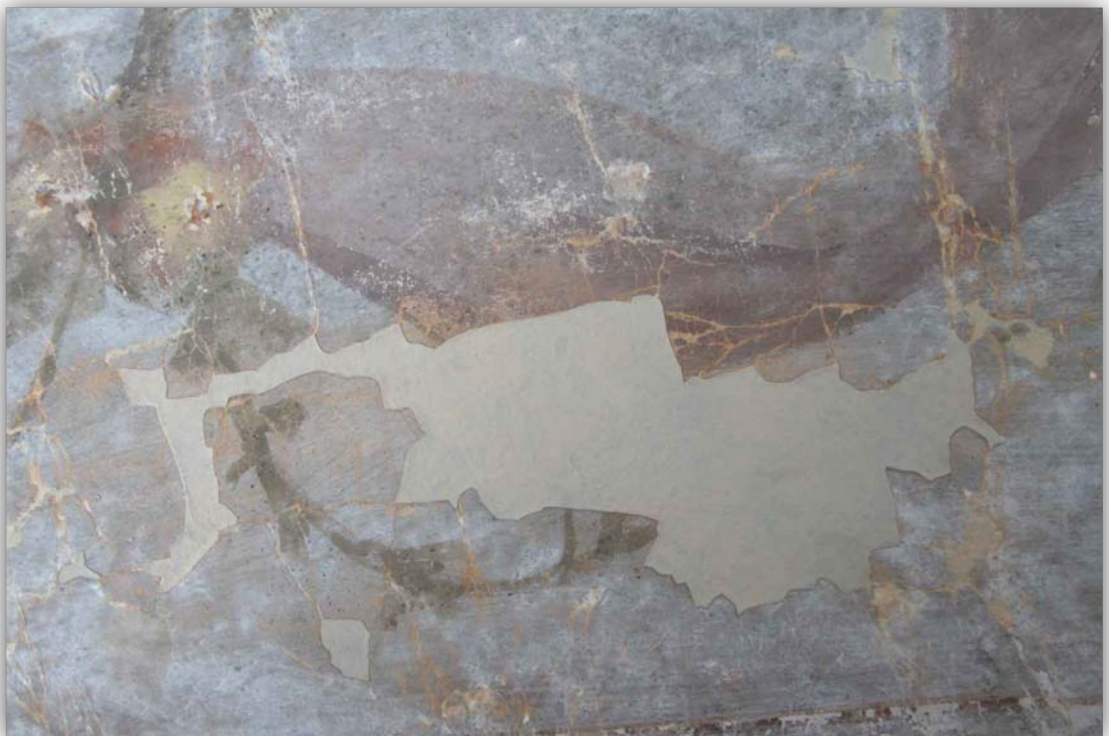
64. Obrázek: stav v průběhu restaurování; detail doplňků; snímáno v denním rozptýleném světle
