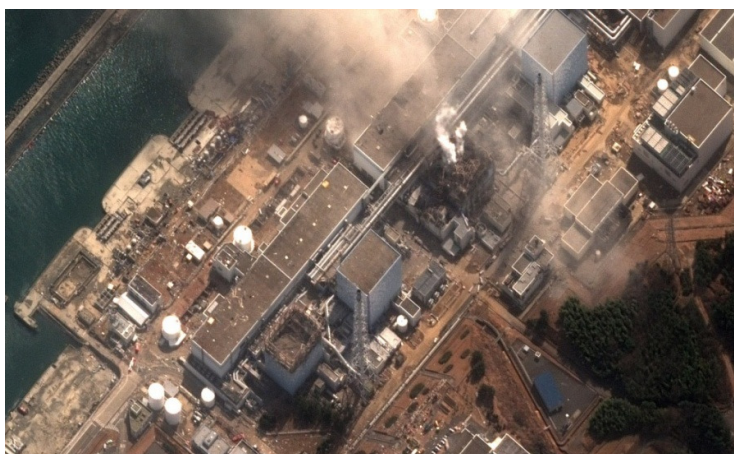
Obr. 4 Fukušima poškozený 3 reaktor
