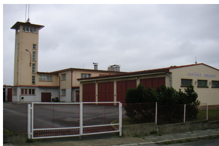
Stanice Kamenice nad Lipou
