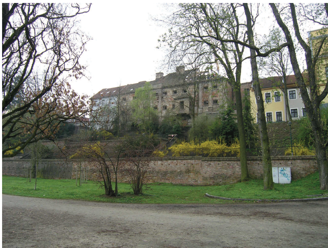
Foto 1: Areál bývalé šatlavy před rekonstrukcí 322
