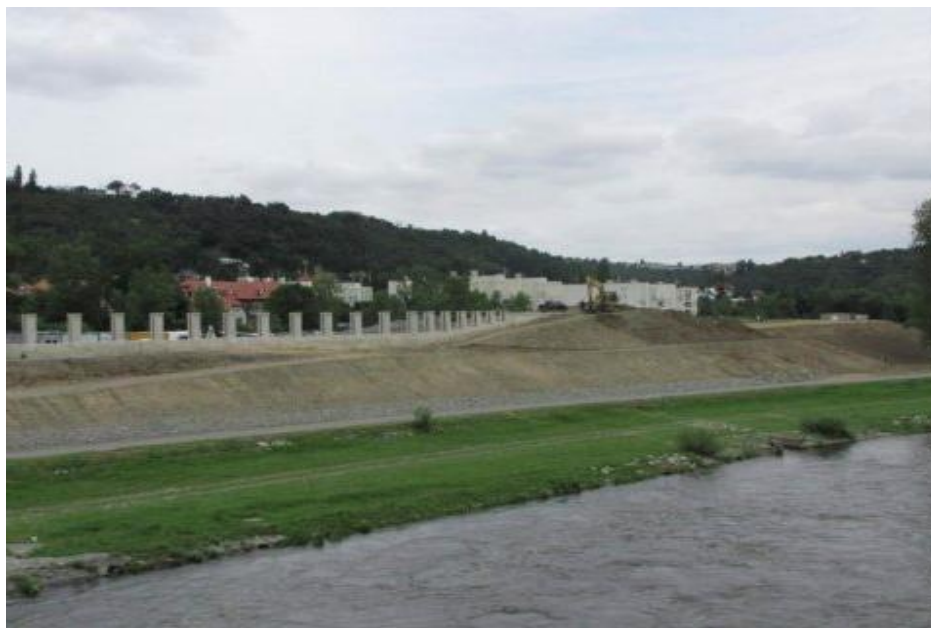
Obrázek 25: protipovodňová zeď na ochranu Troji
