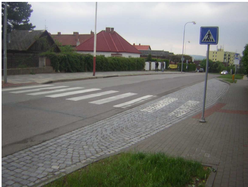
Obrázek 4.2: Současný stav přechodu pro chodce na ulici Znojemská
