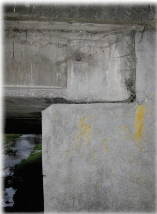
Obrázek 6 – Spodní pohled na jeden z nosníků, silně korodující konstrukční výztuž
