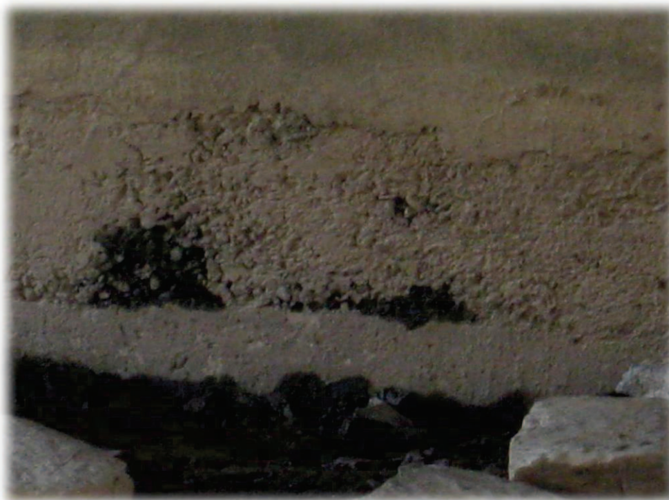
Obrázek 14 – Segregace kameniva při betonáži, chybějící cementové mléko, poškozený kamenný obklad koryta Oslavy
