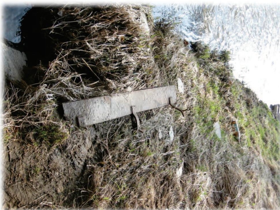
Obrázek 12 – Odpadávání sanační omítky z opěry O2, vznik dutých míst
