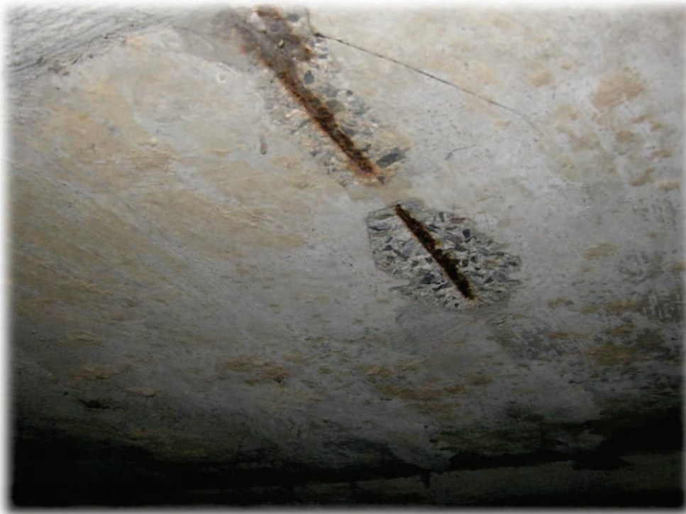
Obrázek 6 – Spodní pohled na jeden z nosníků, silně korodující konstrukční výztuž
