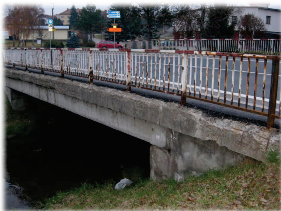
Obrázek 8 – Boční pohled na nosník, prokreslená místa korodující výztuže, viditelná vlhkost na pravé části opěry O2
