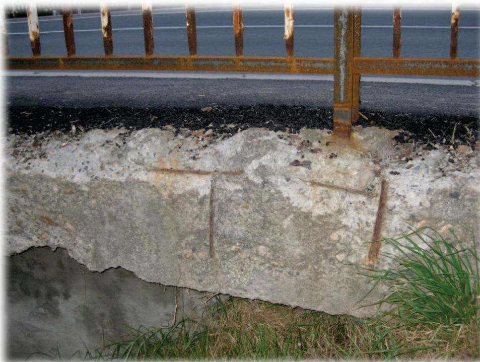
Obrázek 10 – Detail koroze římsy a zábradlí, hloubková degradace betonu
