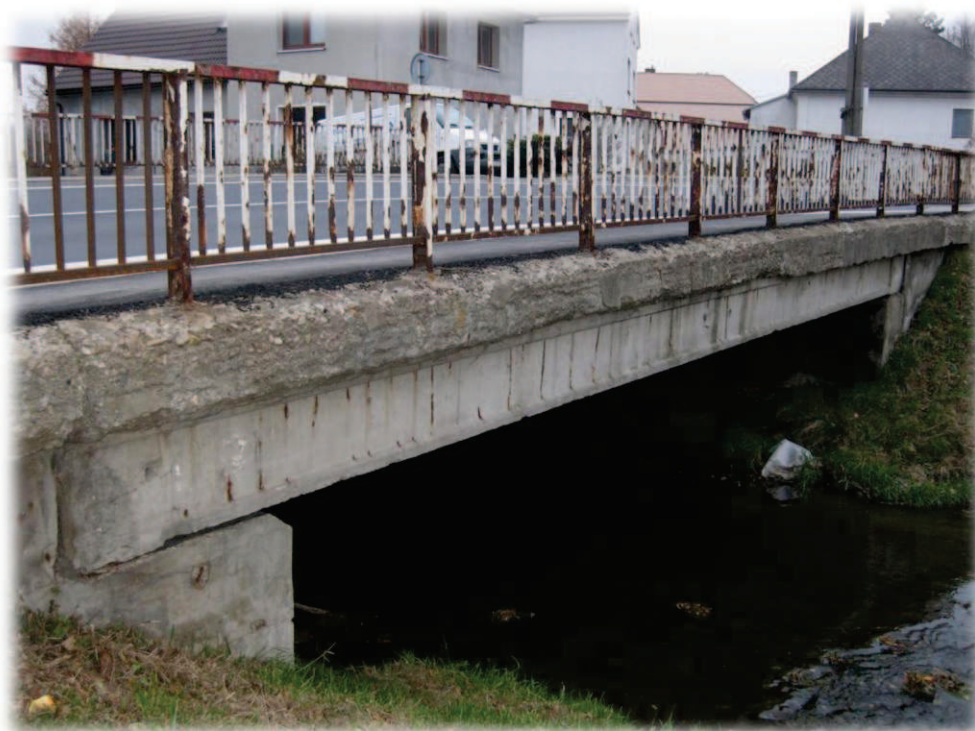
Obrázek 4 – Boční pohled na nosnou konstrukci mostu, korodující zábradlí a degradující beton římsy
