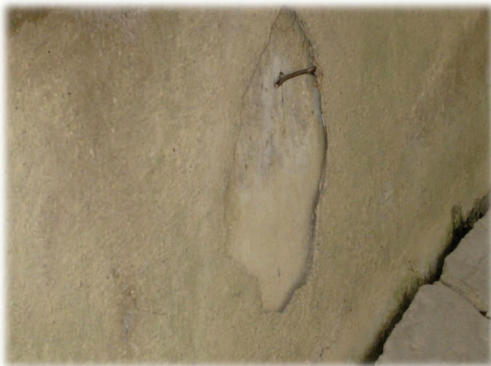
Obrázek 12 – Odpadávání sanační omítky z opěry O2, vznik dutých míst
