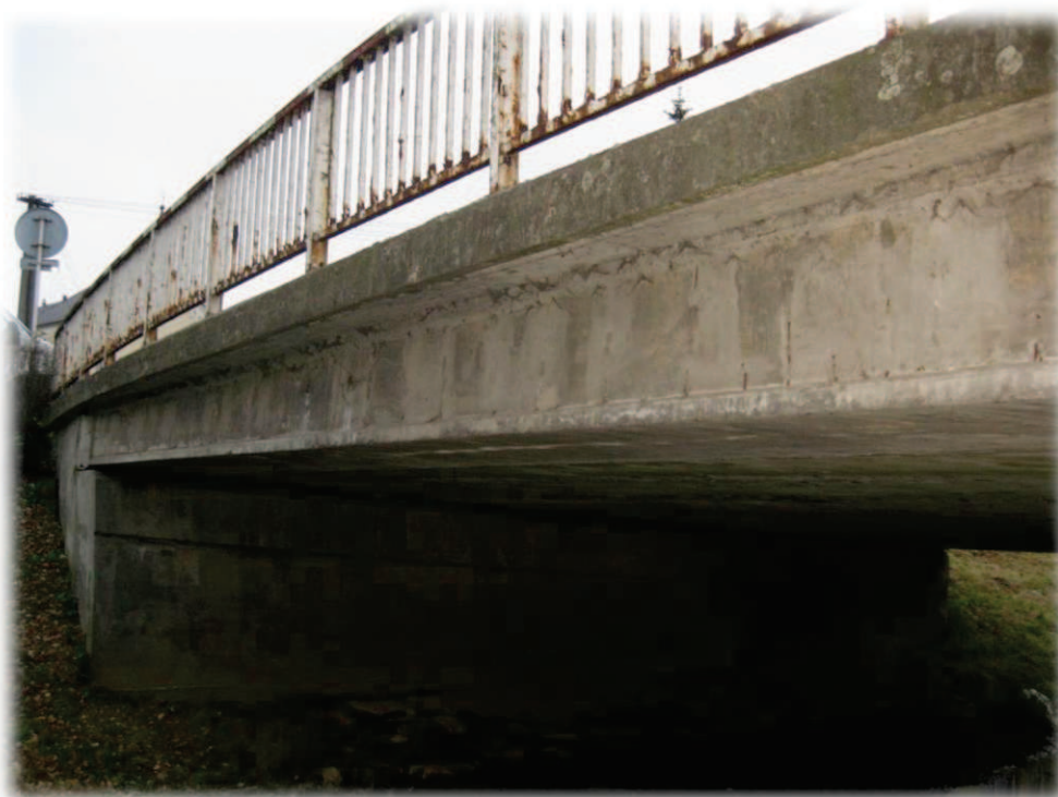
Obrázek 8 – Boční pohled na nosník, prokreslená místa korodující výztuže, viditelná vlhkost na pravé části opěry O2
