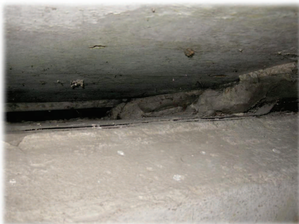
Obrázek 4 – Boční pohled na nosnou konstrukci mostu, korodující zábradlí a degradující beton římsy
