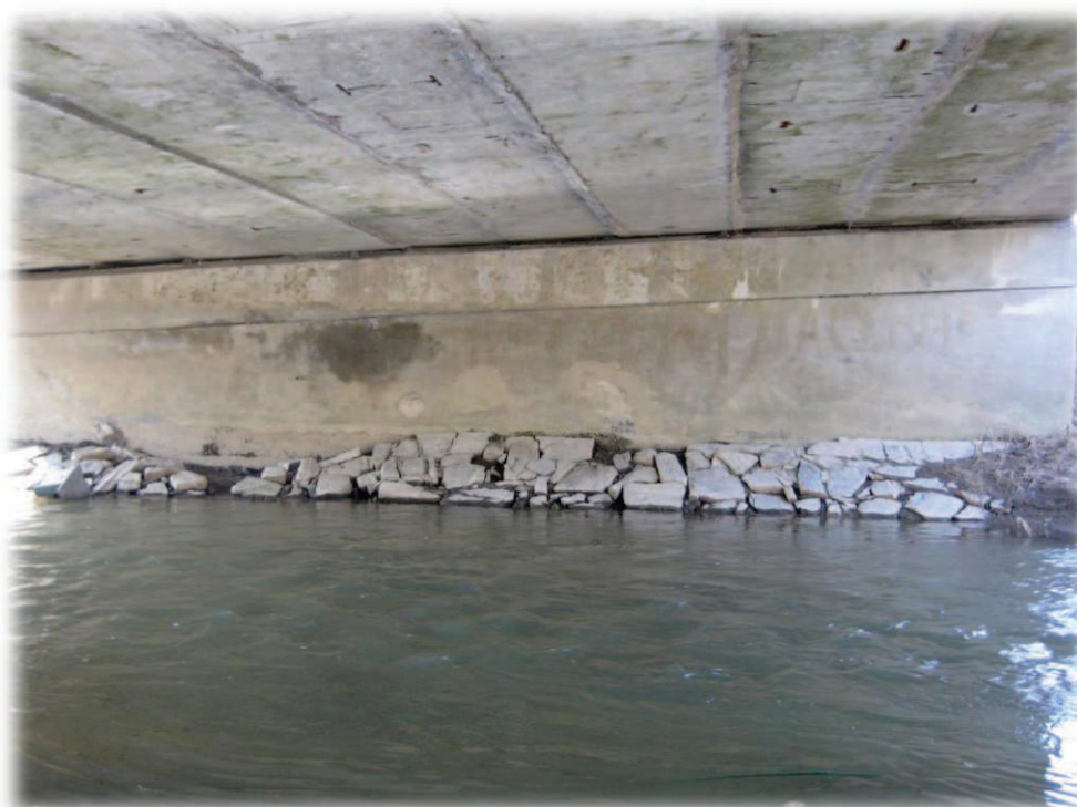
Obrázek 14 – Segregace kameniva při betonáži, chybějící cementové mléko, poškozený kamenný obklad koryta Oslavy
