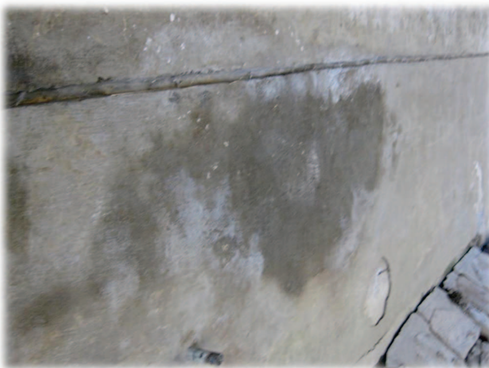
Obrázek 10 – Detail koroze římsy a zábradlí, hloubková degradace betonu
