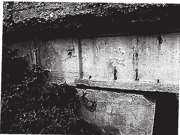
Detail uložení NK na opěru.
