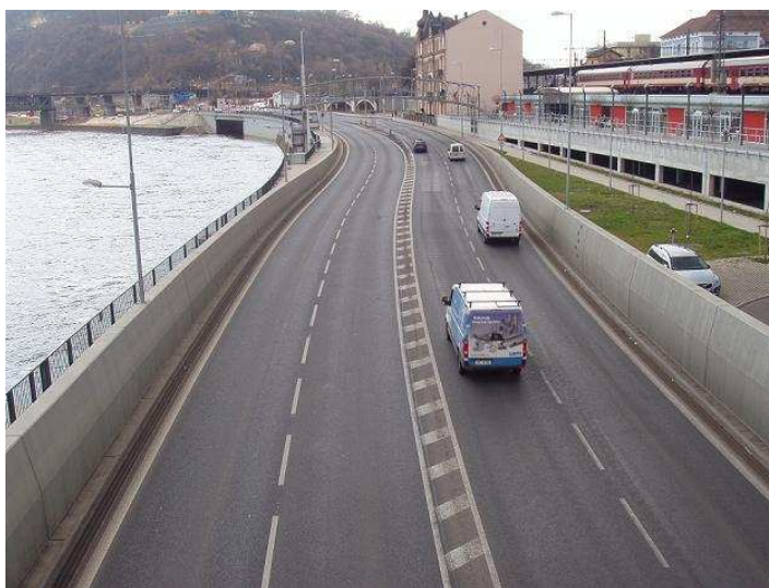
Obrázek 6 Protipovodňová vana na silnici I/30
