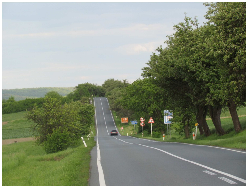
Obr. 6 Místo budoucího přemostění
