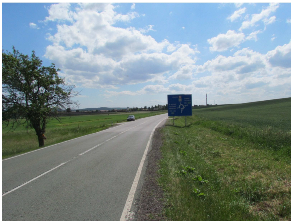
Obr. 8 Konec úseku směr Holice
