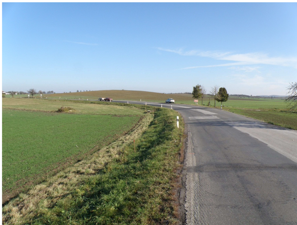
Obr. 3 Místo budoucího křížení se silnicí III. třídy
