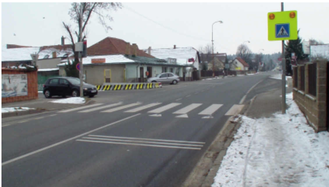
Obrázek 5: Přechod v „centru“ Horních Jirčan
