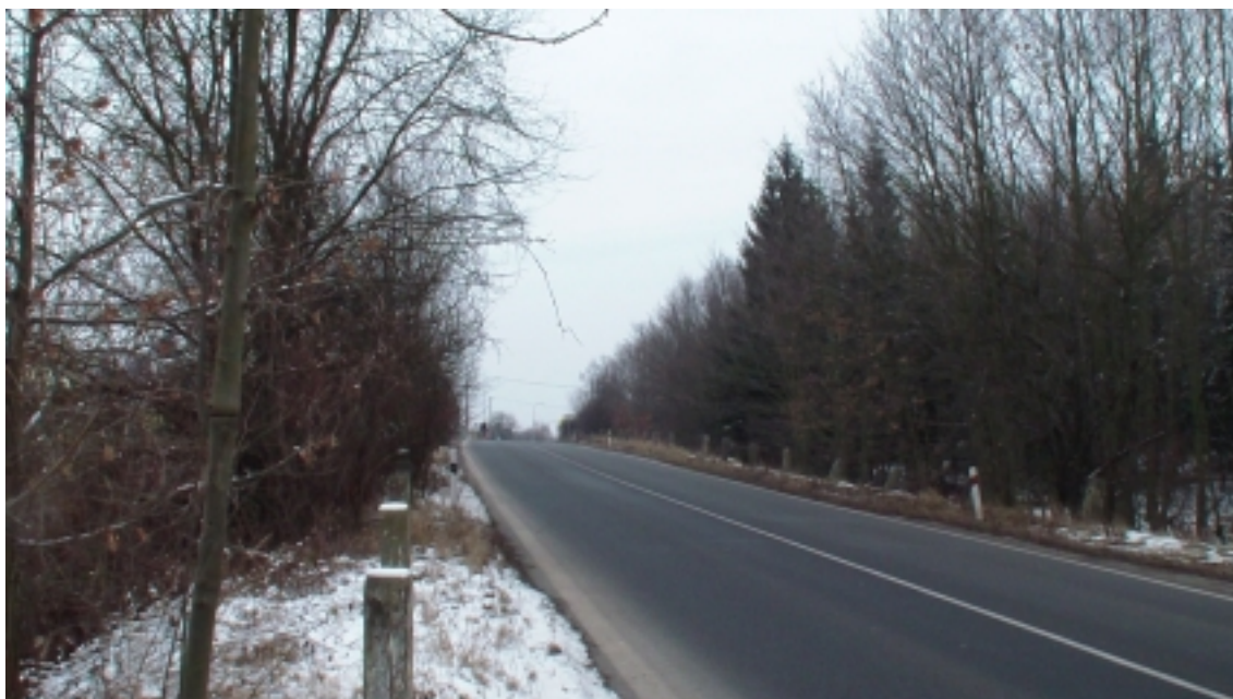
Obrázek 6: Pohled na přechod v Horních Jirčanech.
