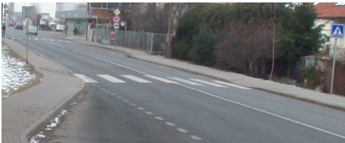
Obrázek 4: Dva ze tří přechodů u zastávky Jesenice, Bytovky.
