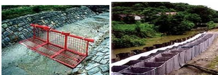
Obr. č. 15: Drátěné protipovodňové hrazení
